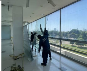
Reposición de Ventanería Piso 3
