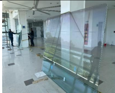
Reposición de Ventanería Piso 1
