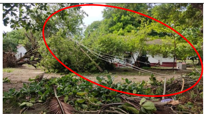
Casa 3. Árbol derribado entre casa 3 y casa 7, el cual derrumba otro poste con líneas de media baja tensión en piso.
