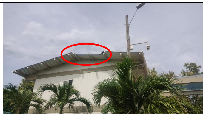
EGCOV. Teja rota resultado en el edificio de la guardia.
