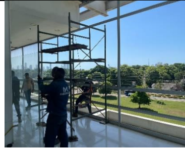
Reposición de Ventanería Piso 3
