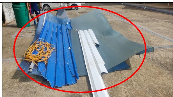
EGCOV. Tejas rotas resultado del desprendimiento del edificio e ingreso de la guardia.
