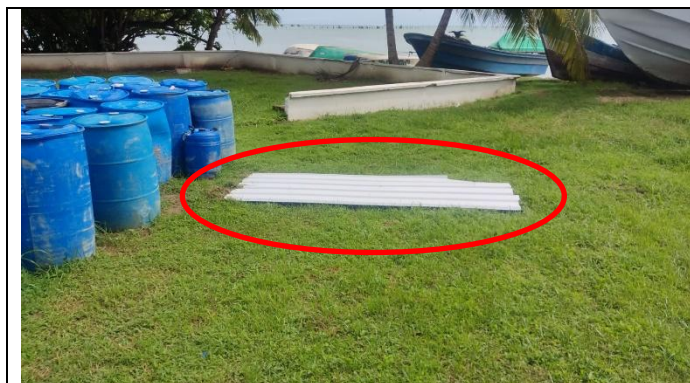
EGCOV. Teja rota resultado del desprendimiento del edificio de la guardia.
