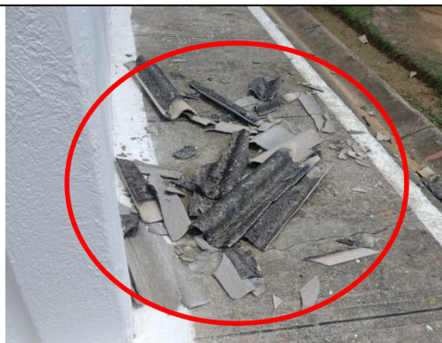
ESFIM. Tejas rotas de cubierta del salón de capacitación intermedia.
