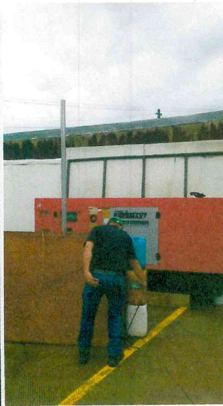
• TANQUEO Y VERIFICACION DE LIQUIDOS DE LA PLANTA ELECTRICA
