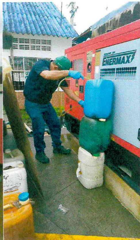
• TANQUEO Y VERIFICACION DE LIQUIDOS DE LA PLANTA ELECTRICA
