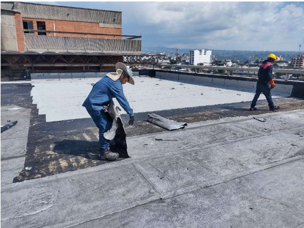
Retiro de manto asfaltico con alumfoil terraza Torre A
