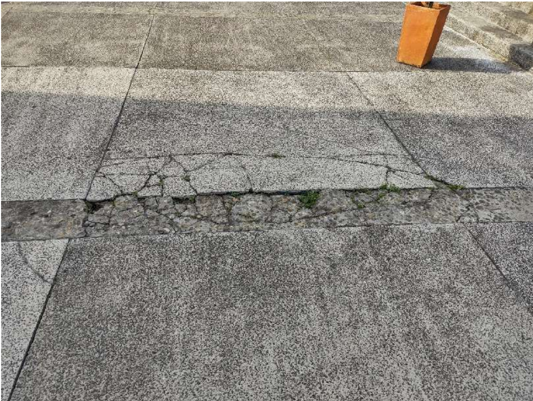
Demolición de huellas y contrahuellas de la plazoleta acceso principal
