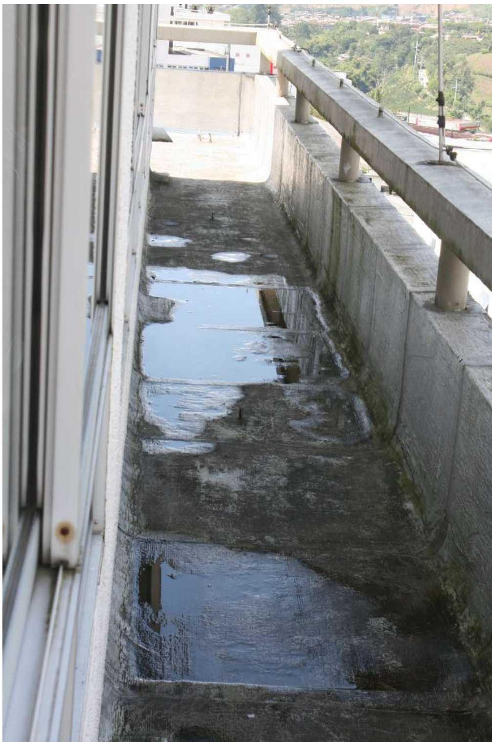
Vista general del corredor norte de la terraza Torre A
