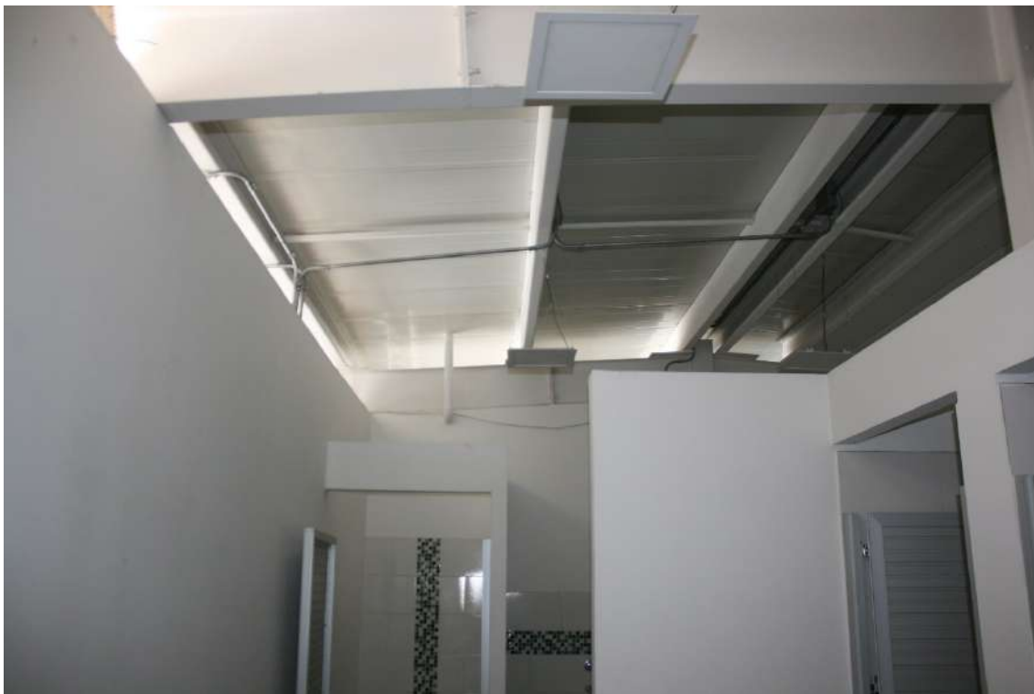
Vista interior del baño de hombres gimnasio
