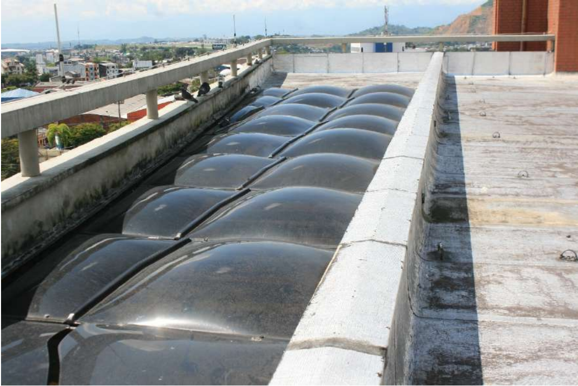
Estado actual de la cubierta con domos en acrílico torre A
