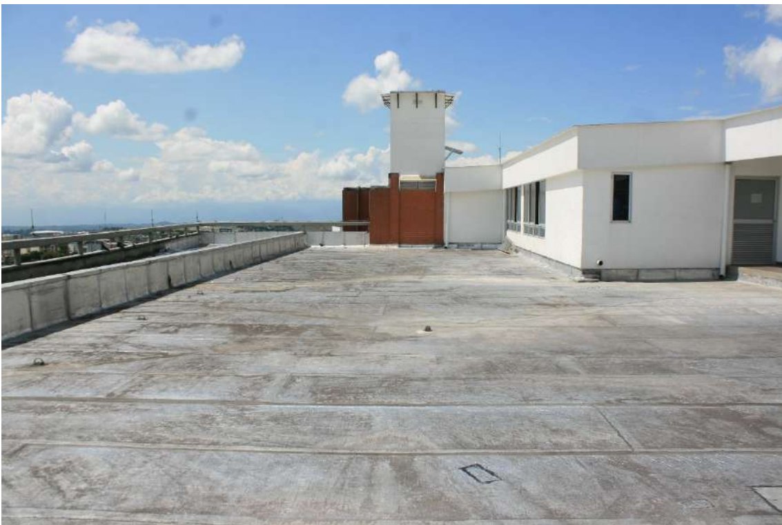
Vista general estado actual de la terraza de la Torre A
