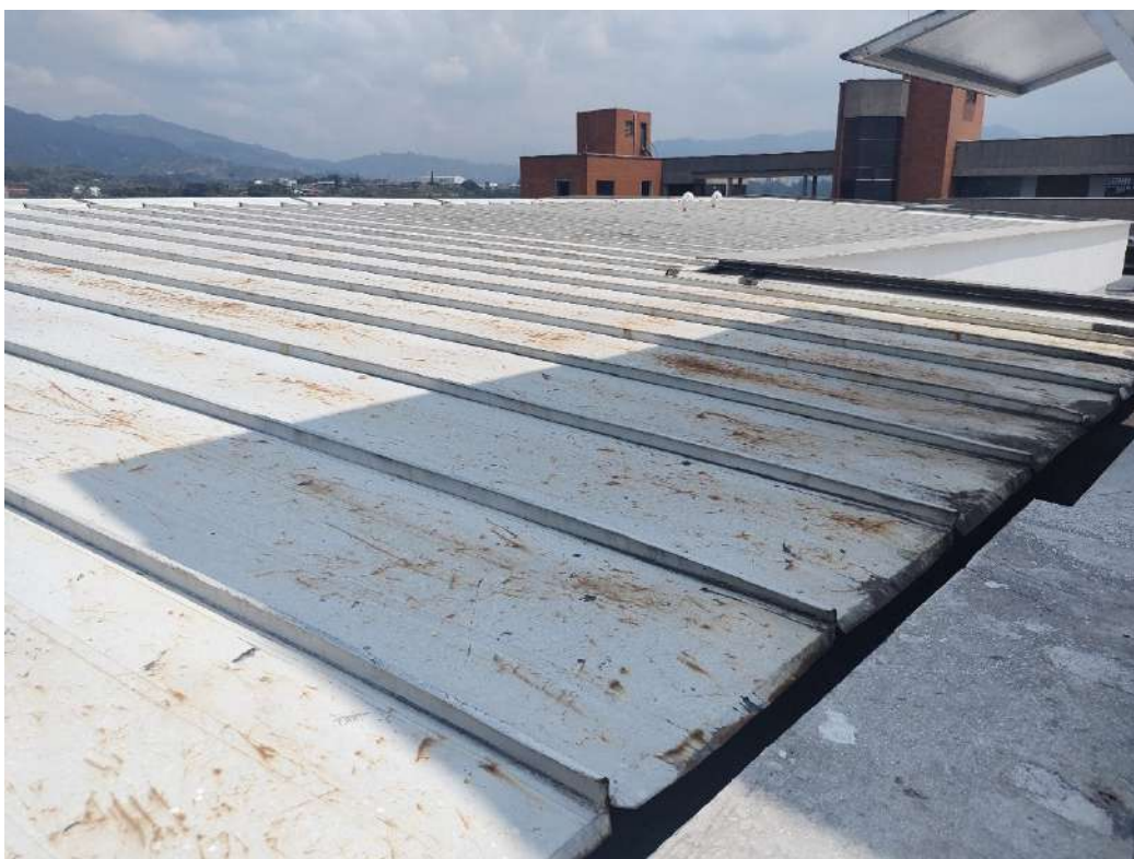
Recorrido de canales cubierta gimnasio
