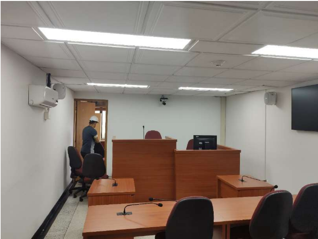
Desmonte para reemplazo de cielo raso en laminas de 0.60 x 0.60 en yeso
