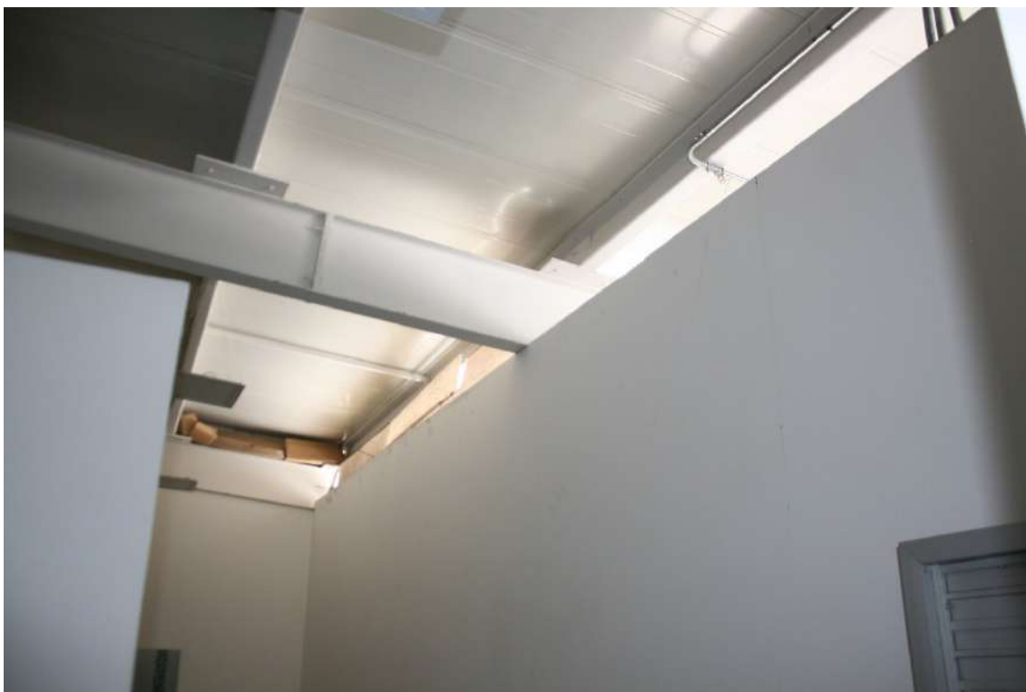
Construcción de muro en sistema liviano para impedir ingreso de aves
