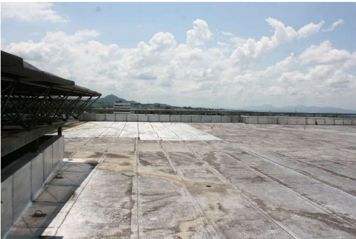
Vista general de la terraza de la Torre A
