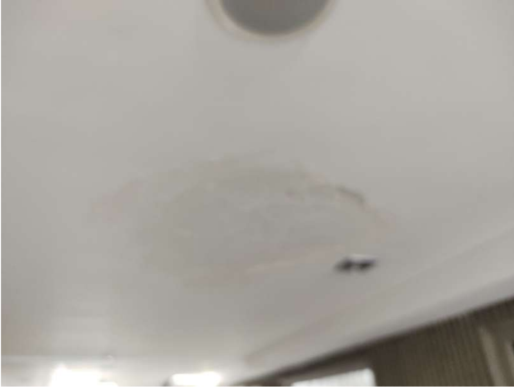
Estuco y pintura para reparación de humedades en cielos de los corredores
