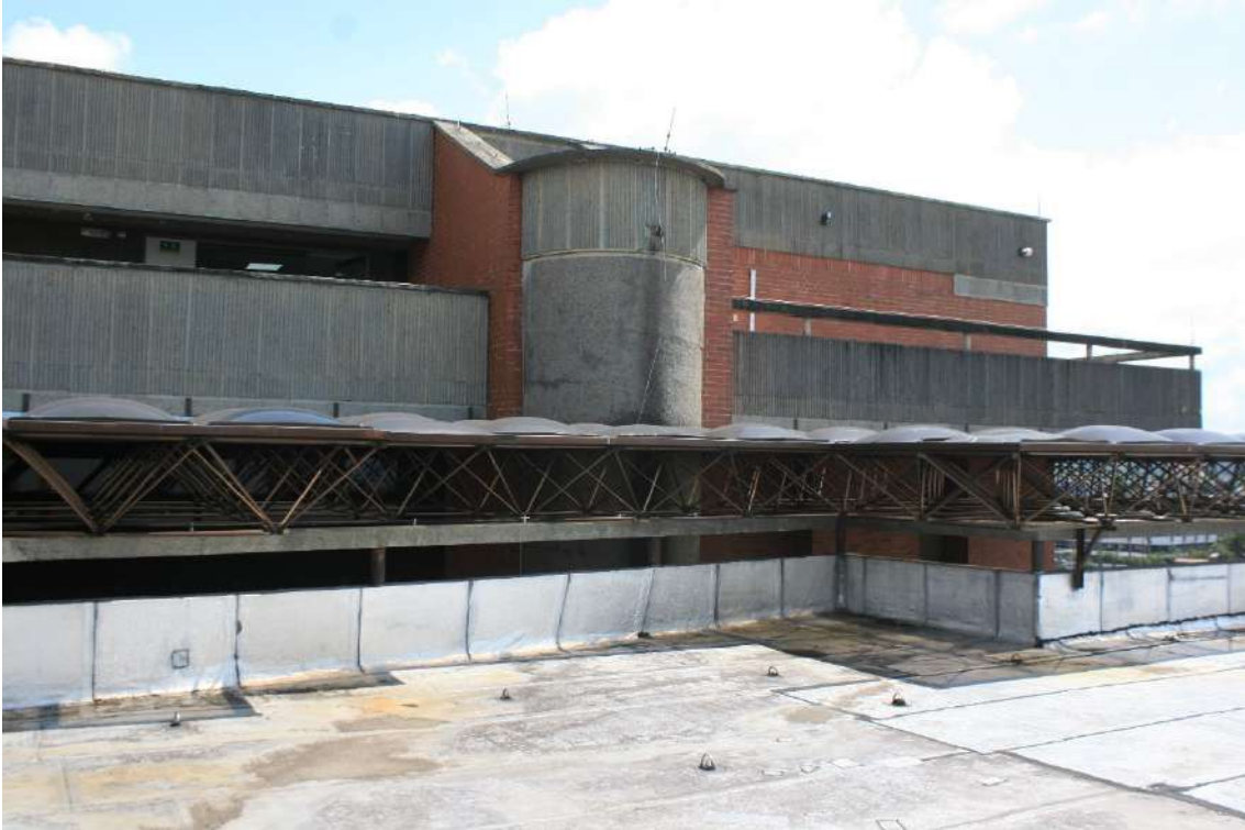
Vista general de los antepechos de la terraza de la Torre A
