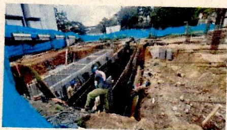
ARMADO DE FORMALETA TANQUE
