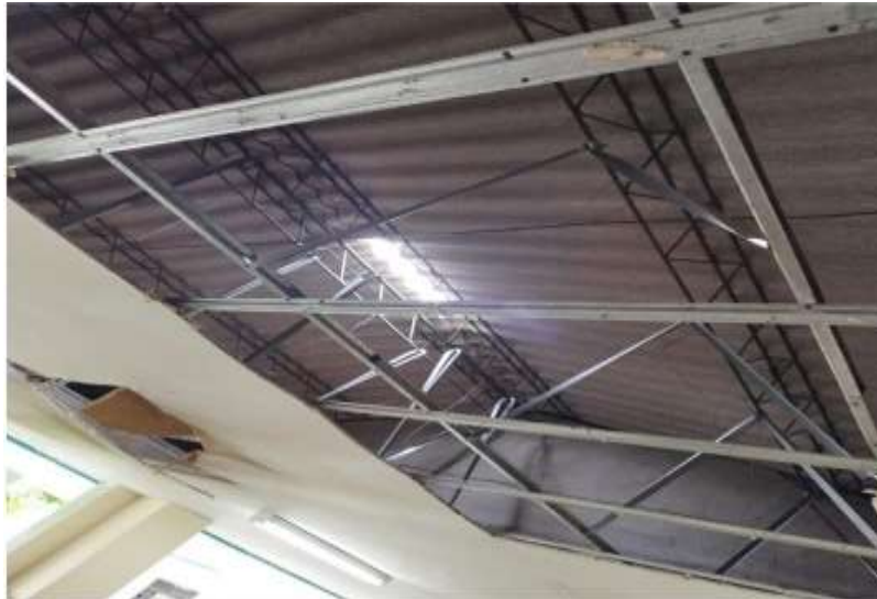
Fotografías 3: Ubicación zona de intervención (Fuente visita técnica)
