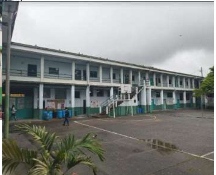
Fotografías 1 y 2: Ubicación zona de intervención (Fuente visita técnica)
