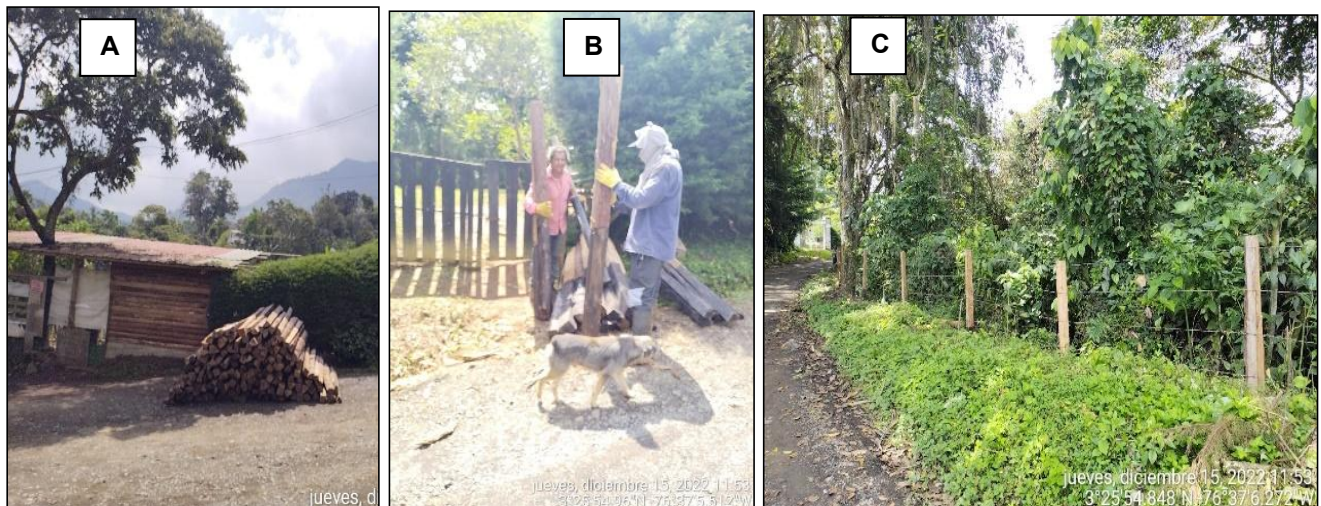
Figura 2. A. Posteadura para instalación de cerco. B. Inmunización de posteadura. C. Posteadura instalada. Predio La Yolanda, Corregimiento Los Andes.
