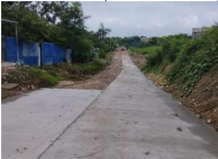
CARRERA 9J1 ENTRE CALLES 70C Y 77, Barrio Lipaya
