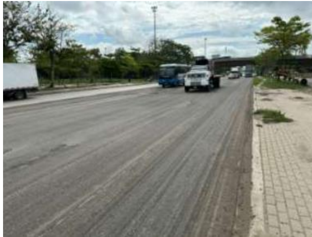
Vía Circunvalar sentido sur norte a las alturas del puente de Murillo
