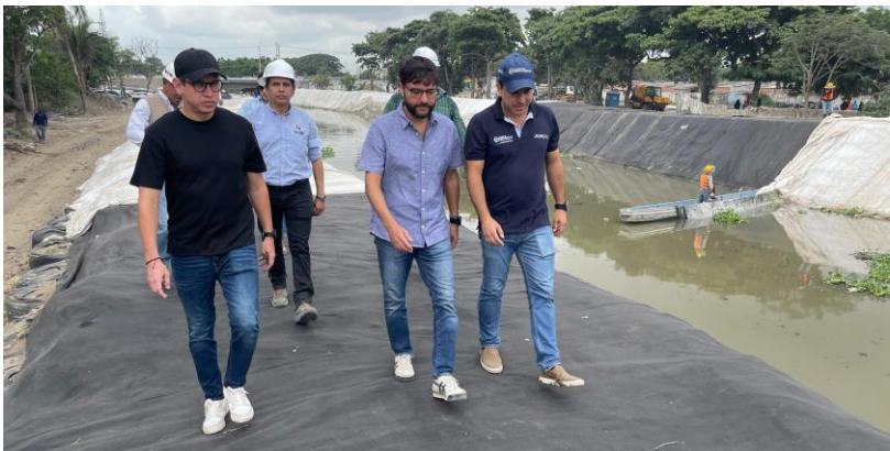
Recorridos de Obras de Recuperación del caño de la Auyama
