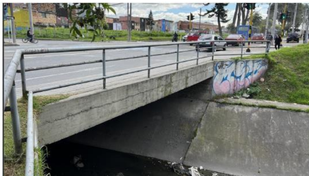
Es un puente vehicular tipo box coulvert.
