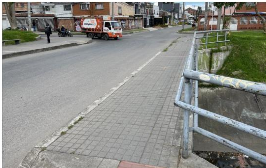
Es un puente vehicular en estructura tipo Box Coulvert.
