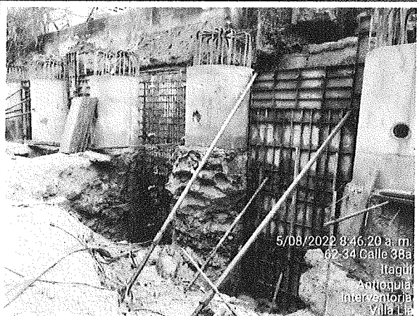
ENCOFRADO Y VACIADO DE CONCRETO PARA MURO PANTALLA DE ESTRUCTURA DE CONTENCIÓN.
