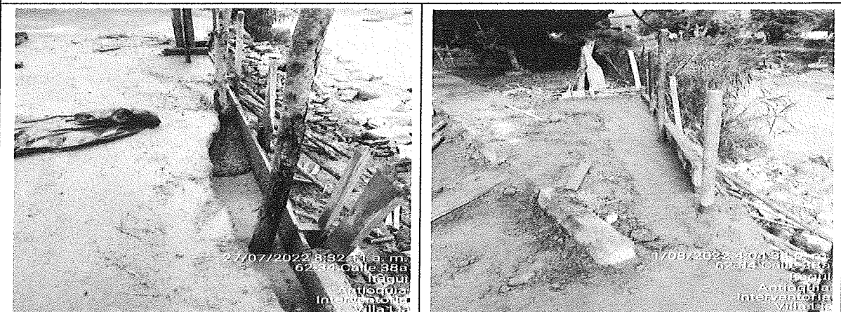
CONSTRUCCIÓN DE RECINTES EN CONCRETO CICLÓPEO EN MÁRGENES DE LA QUEBRADA.
