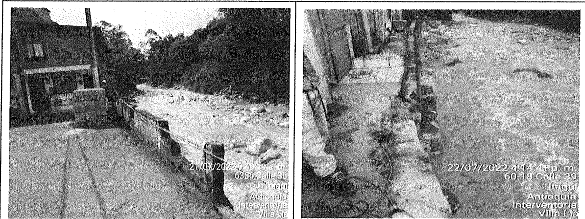
CONSTRUCCIÓN DE ANCLAJES CON RECUBRIMIENTO EPÓXICO PARA MURO EN BLOQUE DE CONCRETO NUEVO.
