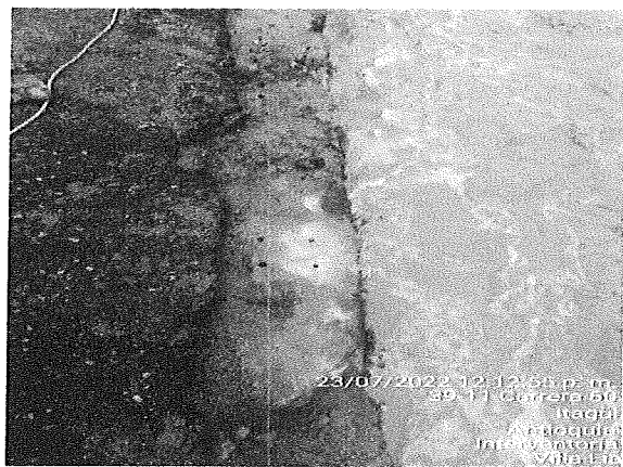
CONSTRUCCIÓN DE ANCLAJES CON RECUBRIMIENTO EPÓXICO PARA MURO EN BLOQUE DE CONCRETO NUEVO.
