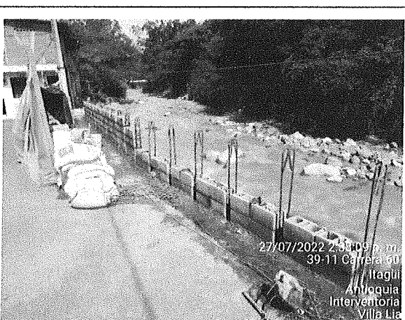
CONSTRUCCIÓN DE MURO EN BLOQUE DE CONCRETO INCLUYENDO VIGUETAS Y COLUMNETAS SEGÚN DISEÑO.
