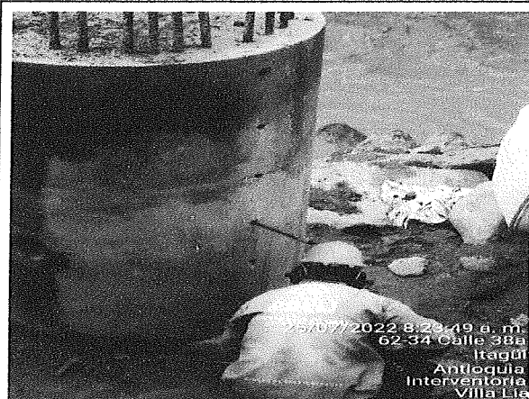
INSTALACIÓN DE ANCLAJES PARA ACERO DE REFUERZO DE MURO PANTALLA EN ESTRUCTURA DE CONTENCIÓN.
