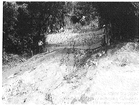
PERFILACIÓN MANUAL Y REVEGETALIZACIÓN DE TALUD CON PASTO TIPO VETIVER E INSTALACIÓN DE AGROMANTO EN MATERIAL BIODEGRADABLE.
