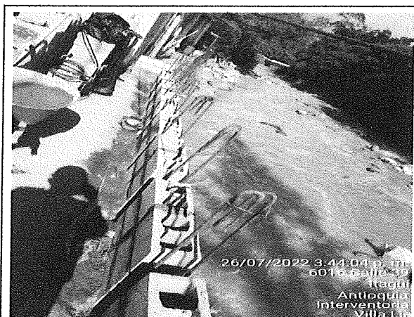
CONSTRUCCIÓN DE MURO EN BLOQUE DE CONCRETO INCLUYENDO VIGUETAS Y COLUMNETAS SEGÚN DISEÑO.
