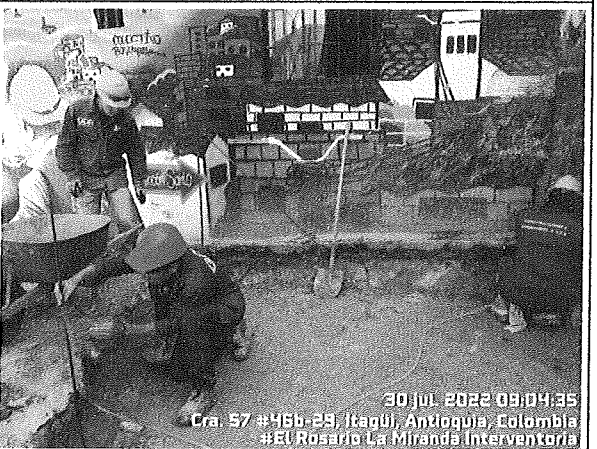
EXCAVACIÓN MANUAL Y ADECUACIÓN DE TERRENO PARA LA CONSTRUCCIÓN DE GAVIONES DE CONTENCIÓN.
