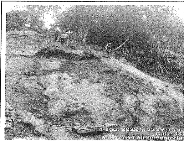
PERFILACIÓN MANUAL Y REVEGETALIZACIÓN DE TALUD CON PASTO TIPO VETIVER E INSTALACIÓN DE AGROMANTO EN MATERIAL BIODEGRADABLE.
