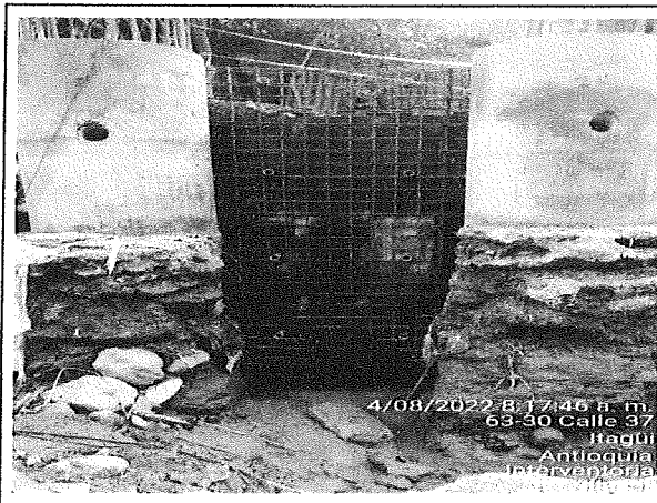
ENCOFRADO PARA MURO PANTALLA DE ESTRUCTURA DE CONTENCIÓN.
