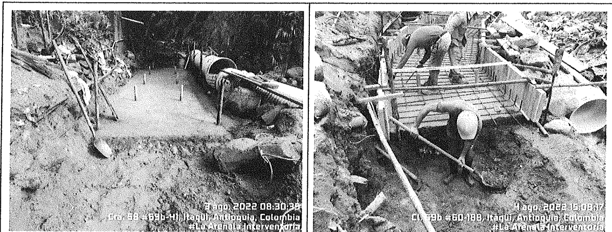
CONSTRUCCIÓN DE SOLADO DE LIMPIEZA E INSTALACIÓN DE ACERO DE REFUERZO PARA PISOS DE CANAL HIDRÁULICO EN CONCRETO.
