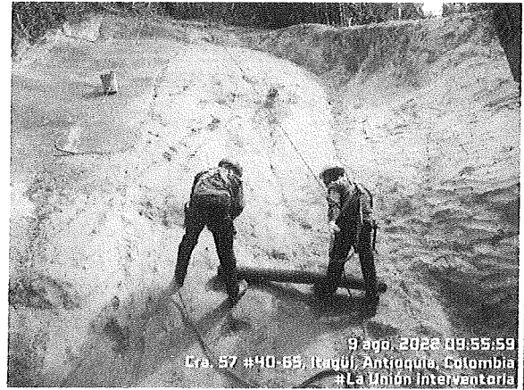
CHAMPEADO EN MORTERO PARA ESTABILIZACIÓN DE TALUD.
