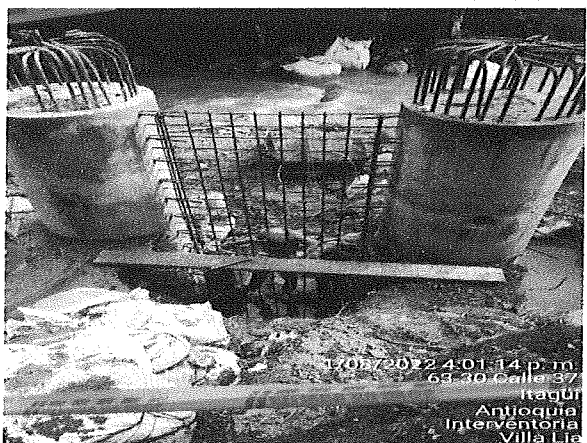
ARMADO E INSTALACIÓN DE ACERO DE REFUERZO PARA MURO PANTALLA DE ESTRUCTURA DE CONTENCIÓN.
