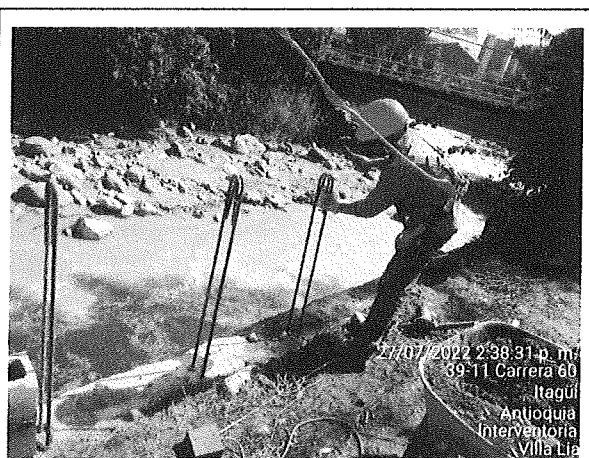
CONSTRUCCIÓN DE MURO EN BLOQUE DE CONCRETO INCLUYENDO VIGUETAS Y COLUMNETAS SEGÚN DISEÑO.
