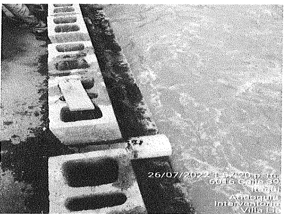
CONSTRUCCIÓN DE MURO EN BLOQUE DE CONCRETO INCLUYENDO VIGUETAS Y COLUMNETAS SEGÚN DISEÑO.
