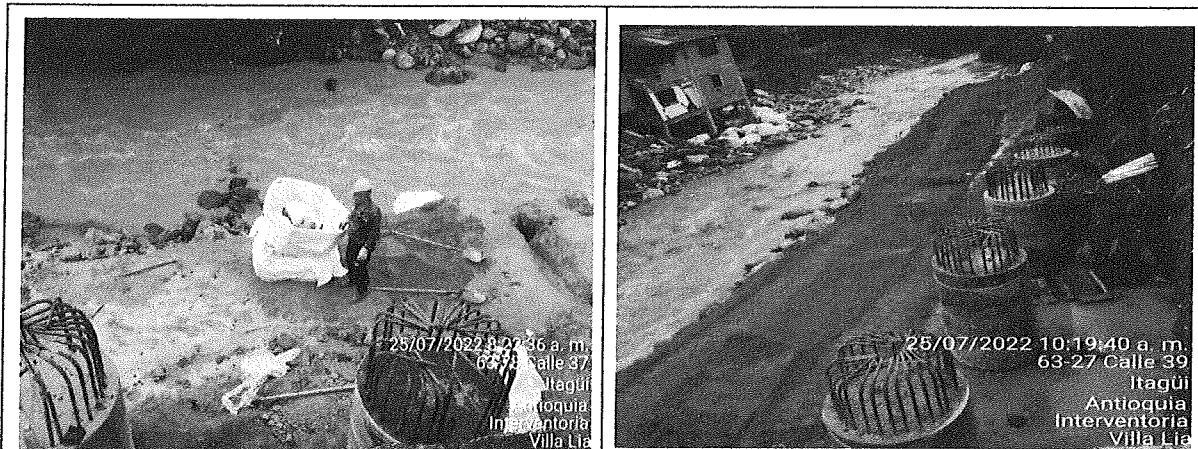
CONSTRUCCIÓN DE ESTRUCTURA DE CONTENCIÓN EN MÁRGEN DE LA QUEBRADA.
