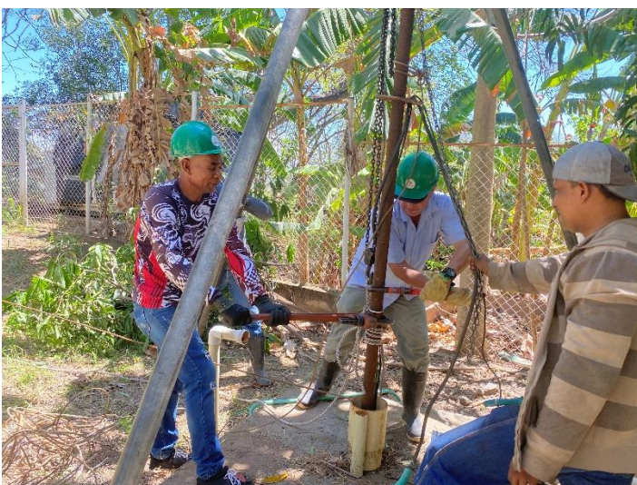
Fotografía 34. Actividad de extracción de bomba submersible captación PTAP, febrero de 2023.
