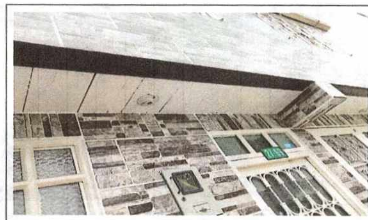
Foto No 8 Descripción: Teja enchapado en buen estado
