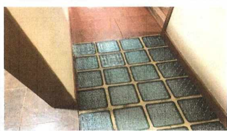
Foto No 4 Descripción Placa translúcida en buen estado
