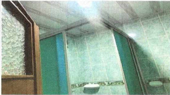
Foto No 1 Descripción Muro enchapado en buen estado
