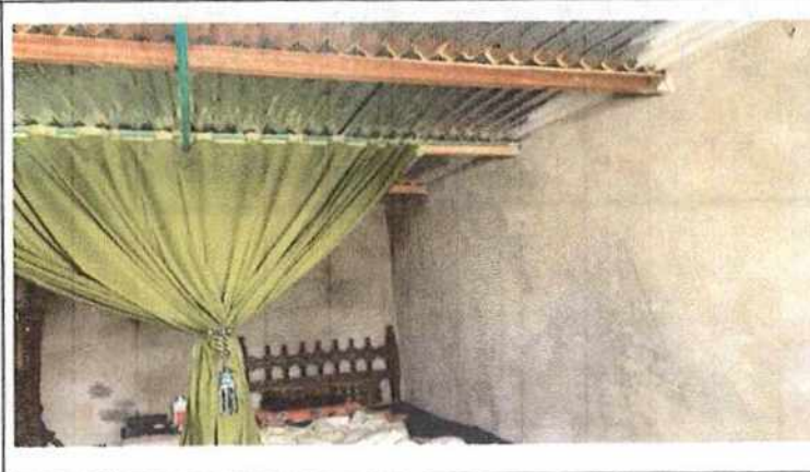
Foto No 2 Descripción Mujo con humedad y retracción en pared
