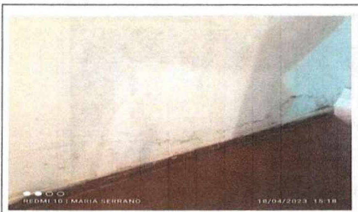
Foto No 3 Descripción se evidencia humedad y humedad en muro
