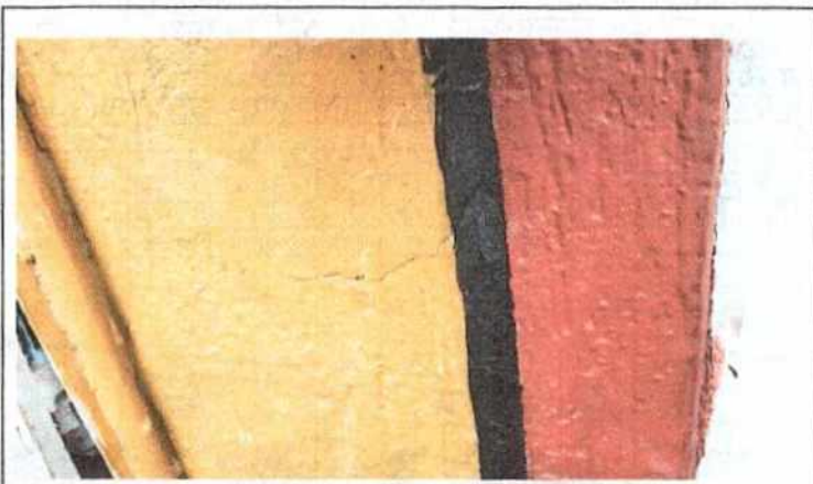
Foto No 1 Descripción Reparación en graniplast
