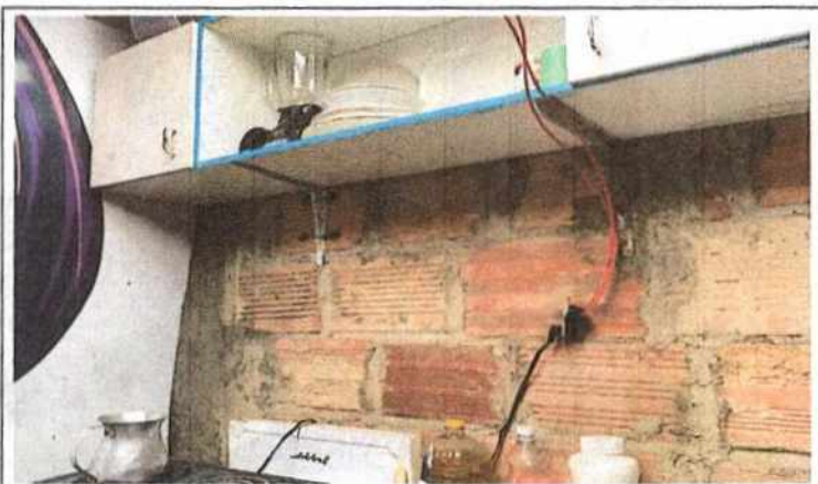
Foto No 7 Descripción Muros en bloque
