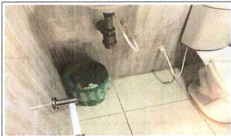
Foto No 5 Descripción Se evidencia muro en baño enchapado en buen estado
