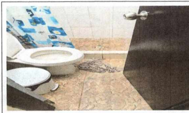
Foto No 8 Descripción Piso de baño en baldosa en buen estado
