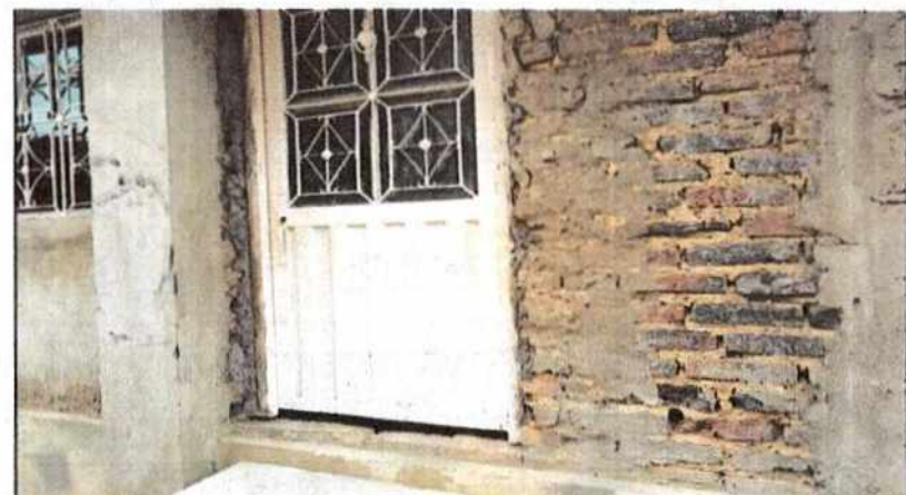
Foto No 4 Descripción Se evidencia desprendimiento de material
