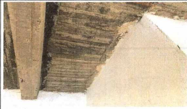
Foto No 6 Descripción Viga y placa de ante piso a la vista.
