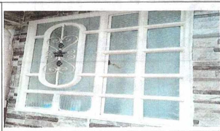
Foto No 2 Descripción: Carpintería metálica y vidrio en buen estado
