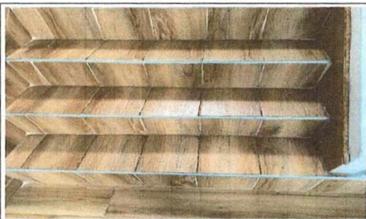
Foto No 1 Descripción Se evidencia escalera con baldosa en buen estado
