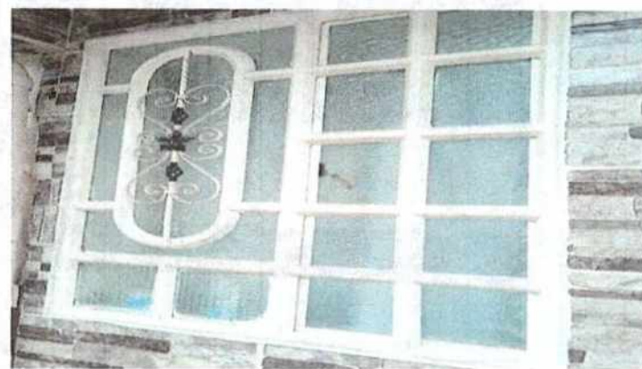
Foto No 6 Descripción: Vidrios en buen estado
