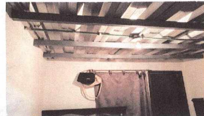
Foto No. 6 Descripción: cubierta en teja metálica en buen estado
