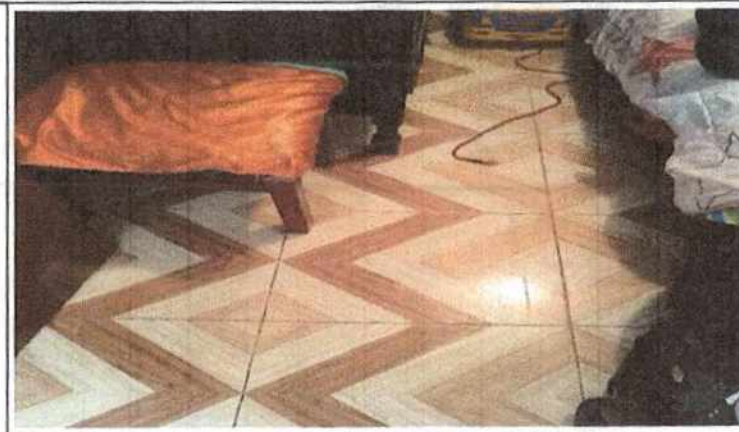
Foto No 2 Descripción Pisos en baldosa en buen estado con desgaste.
