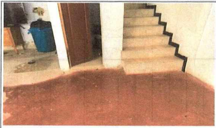
Foto No 5 Descripción Pisos en cemento
