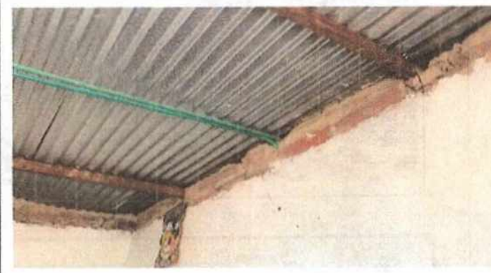
Foto No. 8 Descripción cubierta en lamina zinc en buen estado, con estructura de madera tallada
