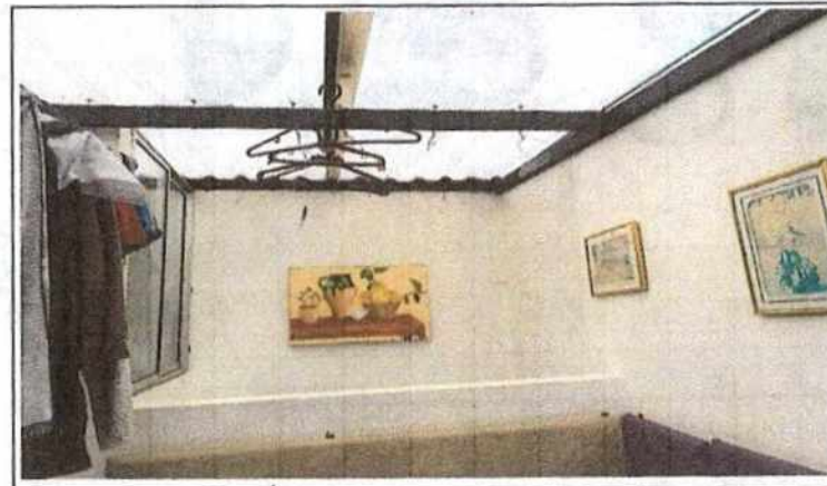
Foto No 8 Descripción Cubierta en teja plastica translucida
