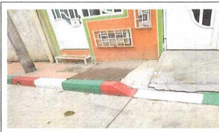
Foto No 4 Descripción Se evidencia arden en muro-pared.
