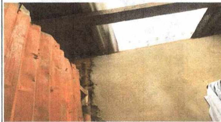
Foto No 6 Descripción Tera plastica translucida.
