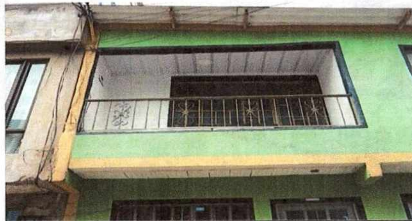
Foto No 8 Descripción estado general en varias condiciones
