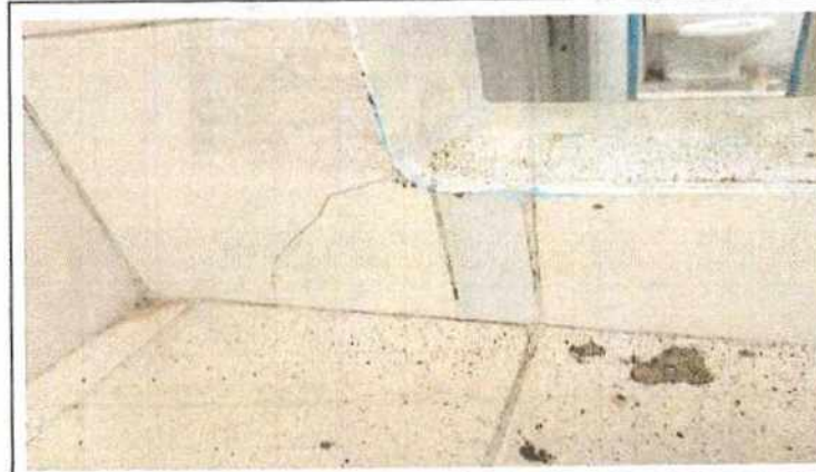
Foto No 8 Descripción Muros con enchape en baldosas frías
