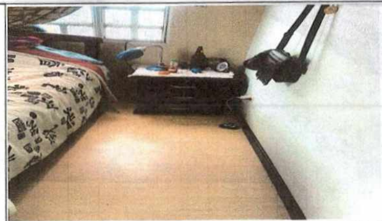
Foto No 2 Descripción Pisos en buen estado.
