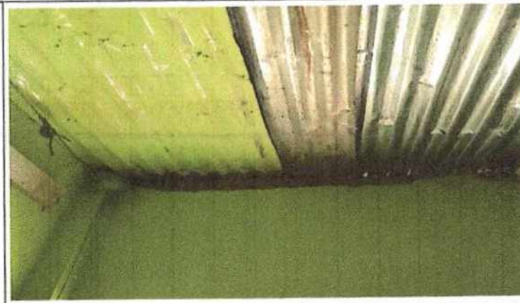
Foto No 6 Descripción Cubierta en lamina con porosidad
