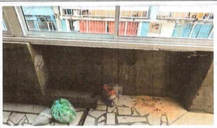
Foto No 5 Descripción Se evidencian vidrios en buen estado
