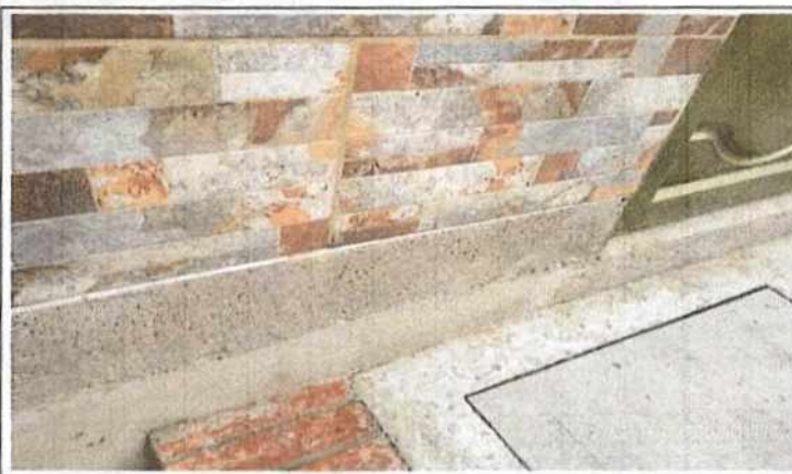
Foto No 3 Descripción Muros en baldosa en buen estado
