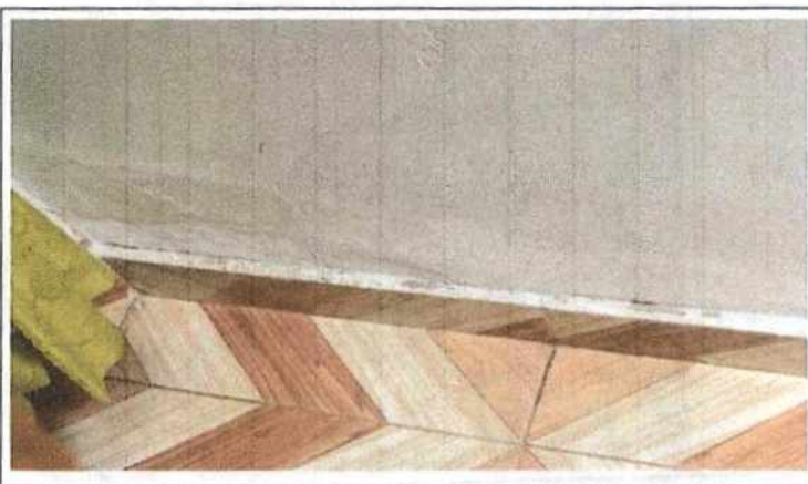
Foto No 7 Descripción Muros con material superpuesto en parte
