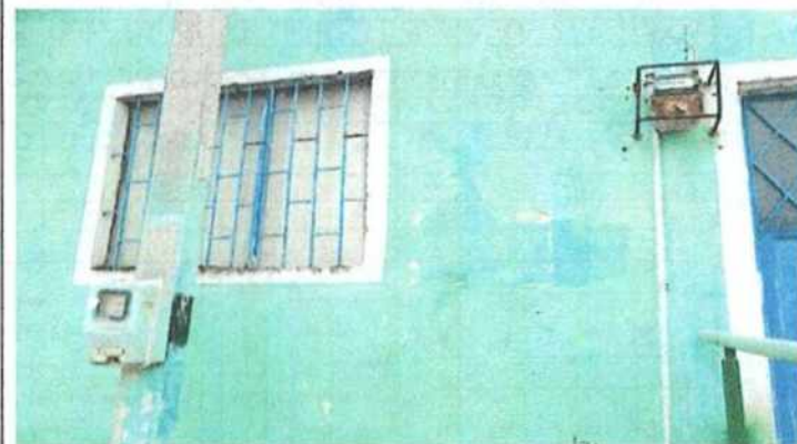
Foto No 6 Descripción se evidencia vidrios en buen estado
