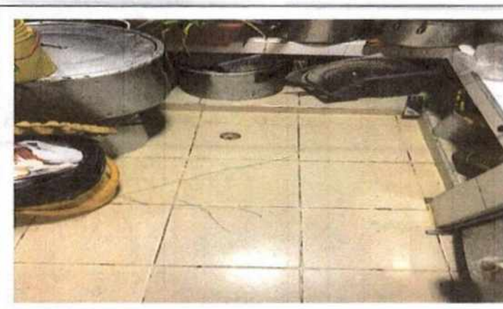
Foto No. 6 Descripción se evidencia pisos en baldosa en buen estado
