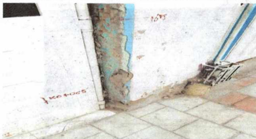
Foto No 4 Descripción Se evidencia desprendimiento de material en fijas
