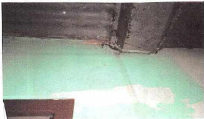
Foto No. 5 Descripción Cobertura con presencia de humedad y hongo.
