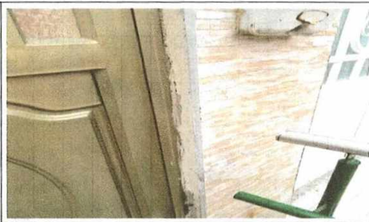
Foto No 2 Descripción Carpintería metálica en buen estado
