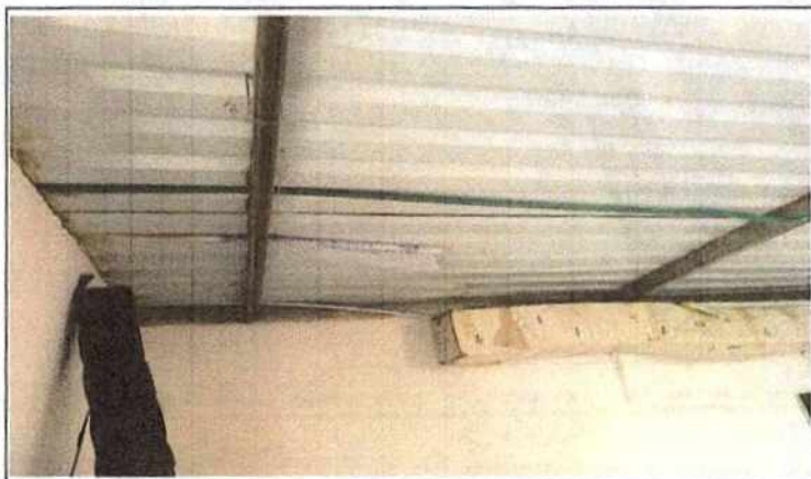
Foto No 7 Descripción Se evidencia cubierta en teja termoacustica en buen estado
