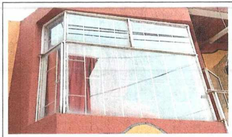
Foto No 5 Descripción Carpintera Metálica y Vidrios en buen estado
