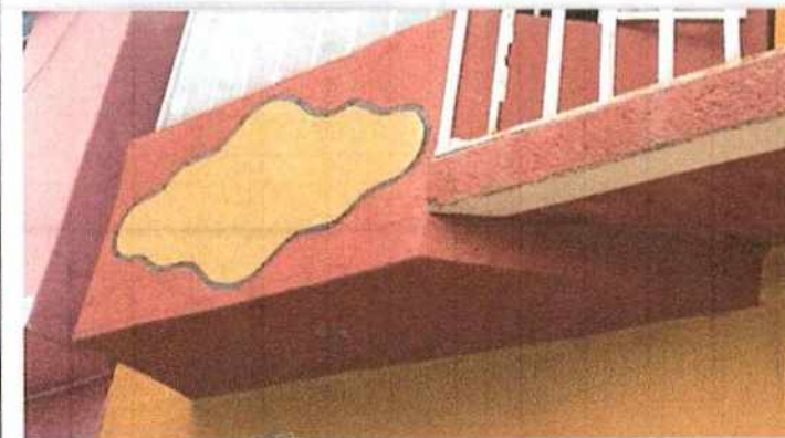
Foto No 6 Descripción Huio con retracción
