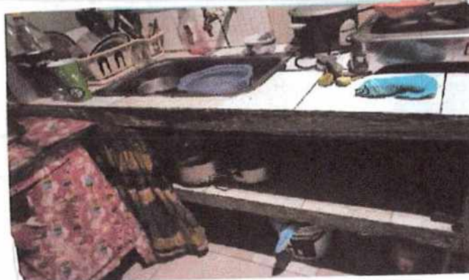
Foto No 2 Descripción Mesa de cocina faltante de enchape Park del frente
