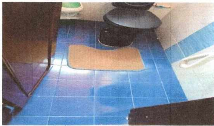
Foto No 1 Descripción Piso baño en buen estado
