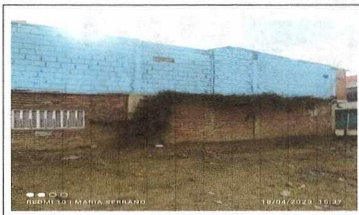
Foto No 8 Descripción Capa vegetal sobre fachada de ladrillo
