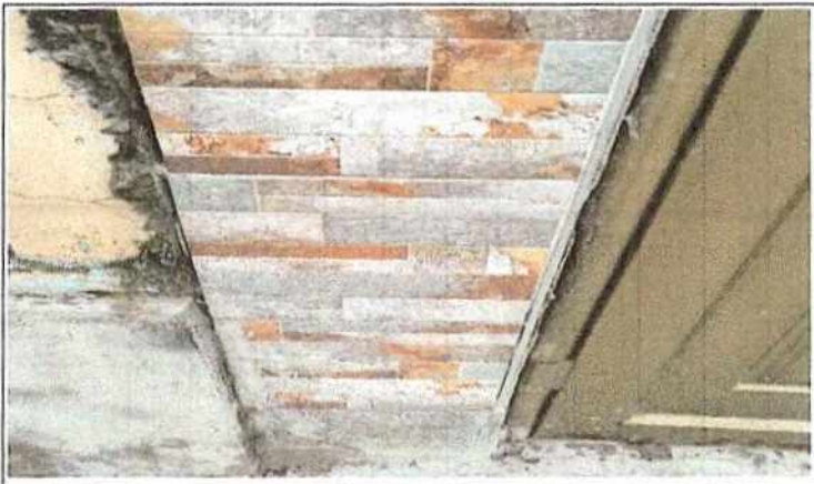
Foto No 5 Descripción Muro en baldosa en buen estado
