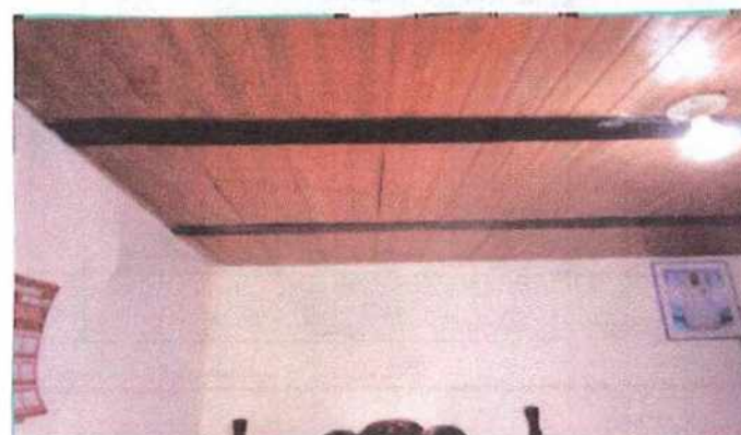
Foto No 4 Descripción Techo en placa aligerada
