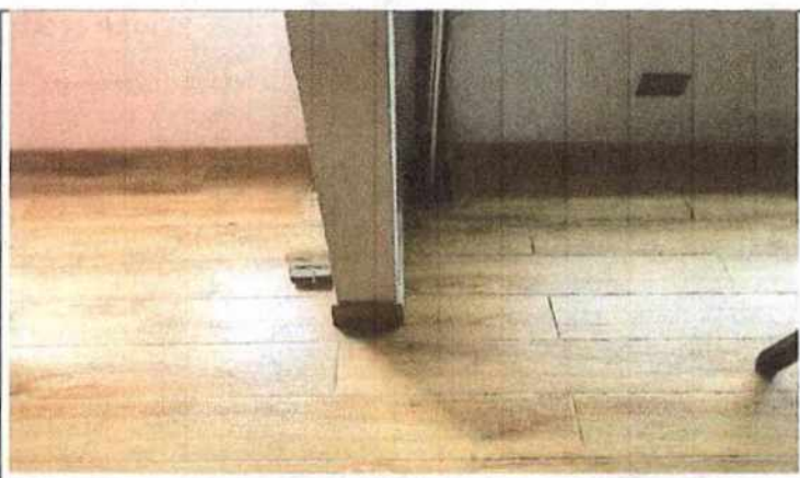
Foto No 3 Descripción Se evidencia piso en buen estado
