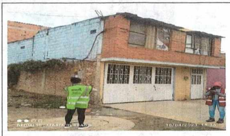
Foto No 3 Descripción Fachada lateral en pintura sobre ladrillo.
