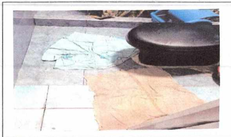
Foto No 5 Descripción Piso de baño cerámico en dos tonulidades
