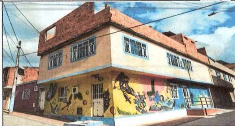
Foto No. 4 Descripción se evidencia tercer nivel en etapa de construcción incompleta
