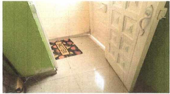
Foto No 2 Descripción Piso en baldosa en buen estado con desgaste
