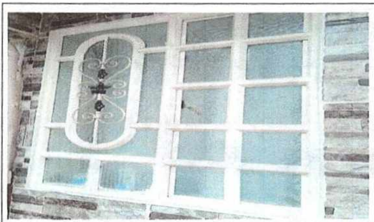
Foto No 3 Descripción: Carpintería metálica en buen estado
