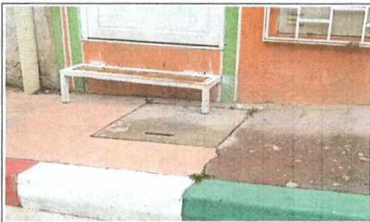
Foto No 1 Descripción Se evidencia creación de camino a predio metálico con presencia de arden.
