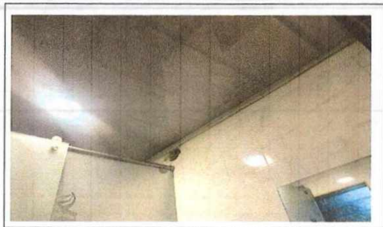
Foto No 3 Descripción Cielo raso en dry wall en buen estado
