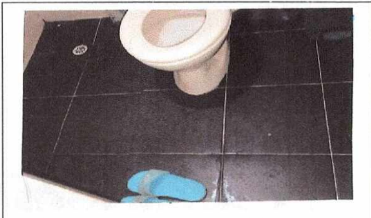
Foto No. 5 Descripción: piso en baldosa en buen estado
