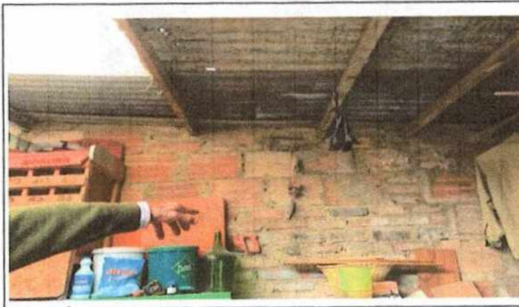
Foto No 4 Descripción Mujo en bloque y ladrillo
