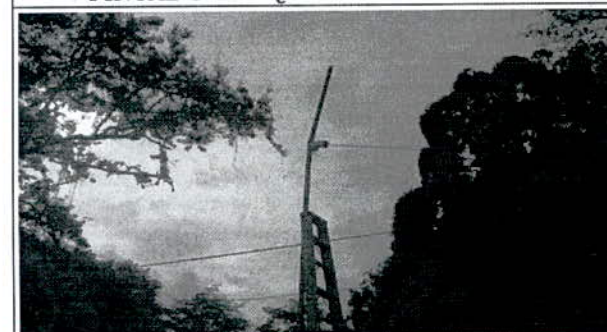
INSTALACIÓN LAMPARAS 120W
