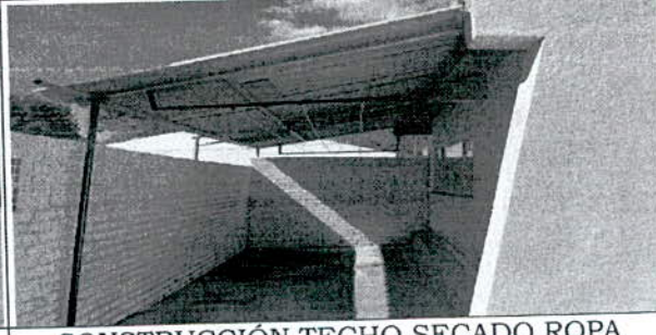
CONSTRUCCIÓN TECHO SECADO ROPA
