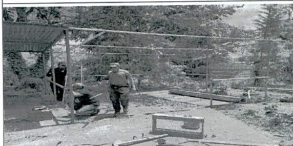
ESTRUCTURA PARQUEADERO MOTOS
