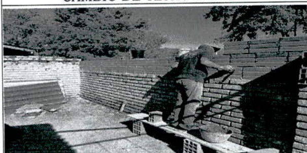
CONSTRUCCIÓN MURO PATIO
