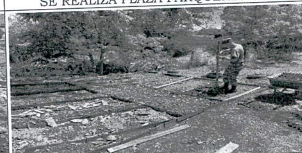
PLACAS PARQUEADERO MOTOS
