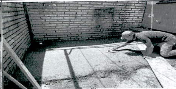
MEJORAMIENTO DEL PISO EN EL PATIO
