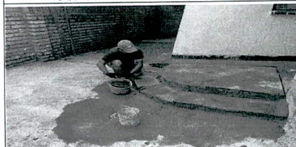
MEJORAMIENTO DEL PISO EN EL PATIO
