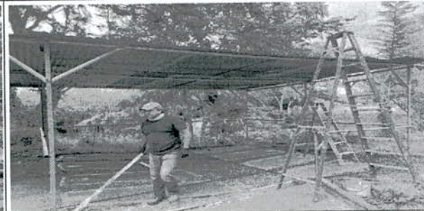
ESTRUCTURA PARQUEADERO MOTOS
