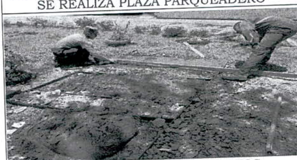
PLACAS PARQUEADERO MOTOS
