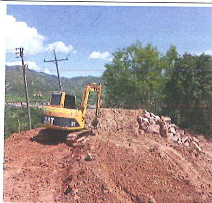
Excavación mecánica Tanque de Almacenamiento
