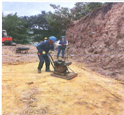
Compactación para solado de tanque de almacenamiento
