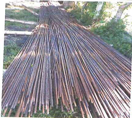
Acero para tanque de almacenamiento
