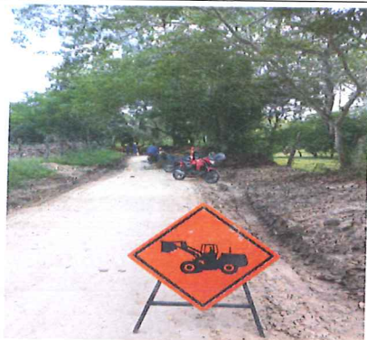
Maquinaria en la Vía
