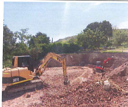
Excavación mecánica Tanque de Almacenamiento
