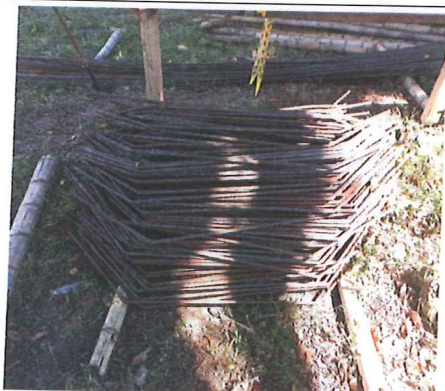
Acero para tanque de almacenamiento
