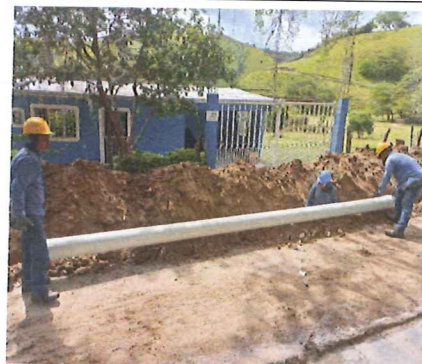
Instalación de tubería de 8"
