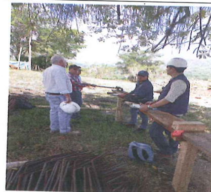
Comité técnico Aguas del huila, Solserving y Ut Pma Suaza Tanque de Almacenamiento
