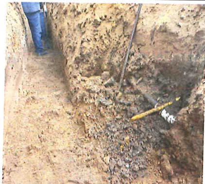
Arreglos a tuberías del Gas y agua potable
