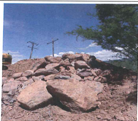
Retiro de sobrantes provenientes de las excavaciones
