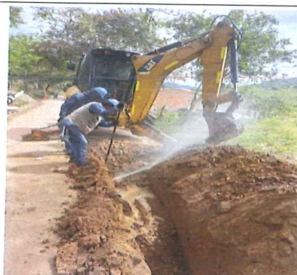
Reparaciones de tubería de gas y agua
