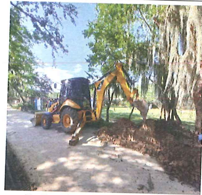
Retiro de material sobrante
