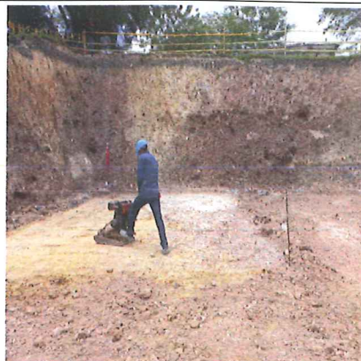
Compactación para solado de tanque de almacenamiento
