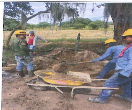
Relleno sobre zanja de la línea de conducción
