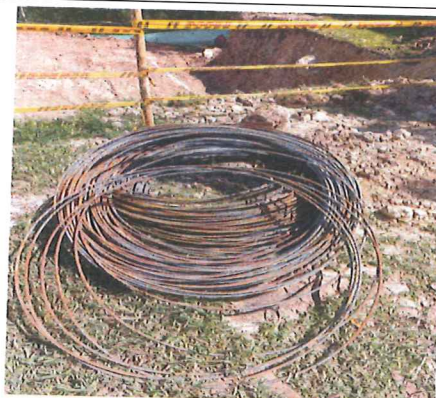
Acero para tanque de almacenamiento
