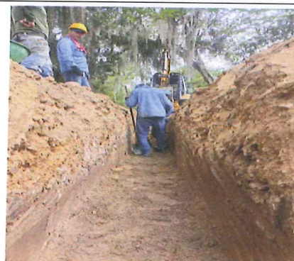
Compactación sobre zanja de la línea de conducción
