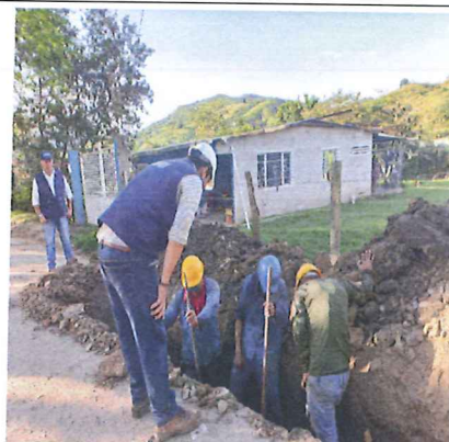
Instalación de arena para protección de tubería
