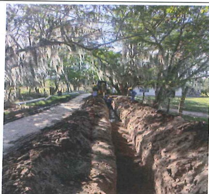
Instalación de arena para protección de tubería
