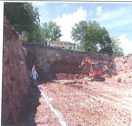
Excavación mecánica Tanque de Almacenamiento
