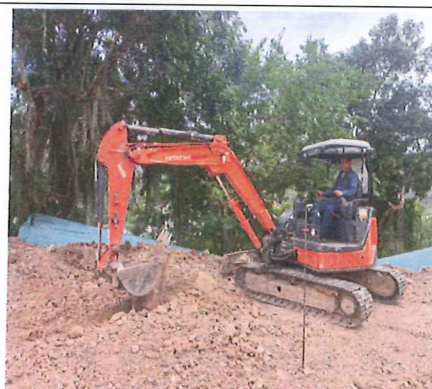
Retiro de sobrantes provenientes de las excavaciones
