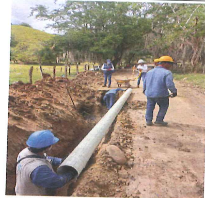
Instalación de tubería de 8"
