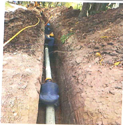
Instalación de tubería de 8"
