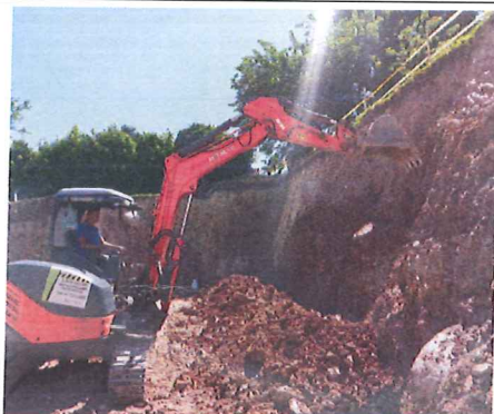
Excavación mecánica Tanque de Almacenamiento
