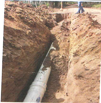
Instalación de arena para protección de tubería
