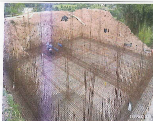
Avance de instalación de Hierro
