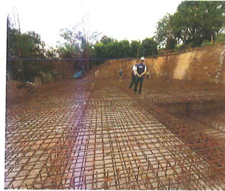
Supervisión figurado de hierro
