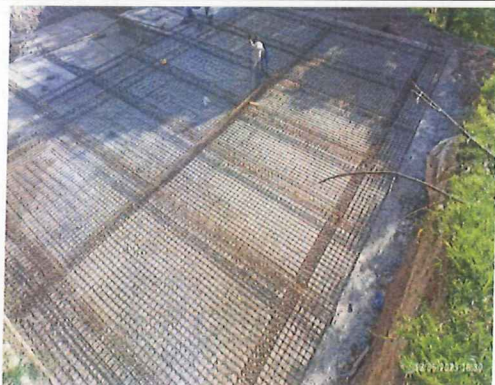
Inicio de instalación hierros para vigas
