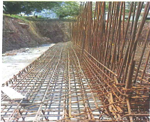
Supervisión figurado de hierro
