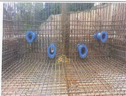
Instalación de pasamuros para tanque de almacenamiento
