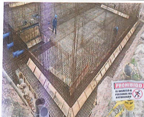
Avance instalación formaleta
