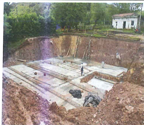
Inicio de instalación hierros para vigas
