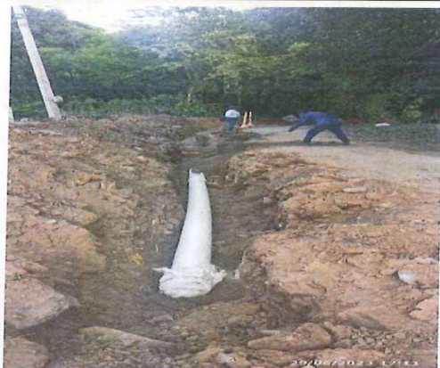
Instalación de tubería de 8"
