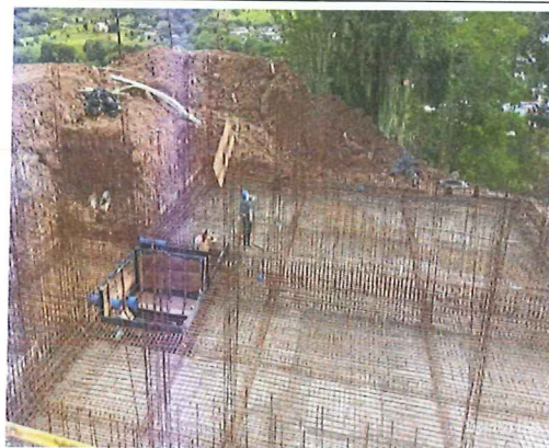
Avance instalación de Hierro
