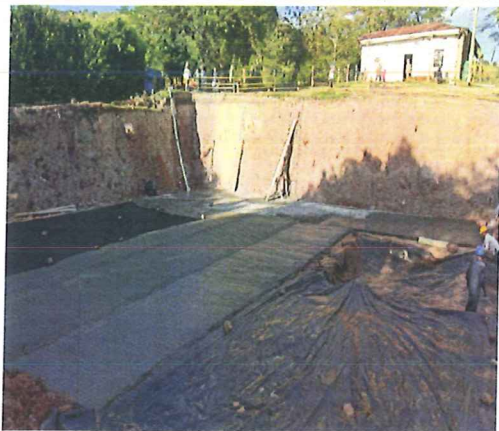
Fundición del solado del tanque
