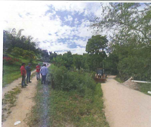
Inicio acenso línea de conducción de 8"
