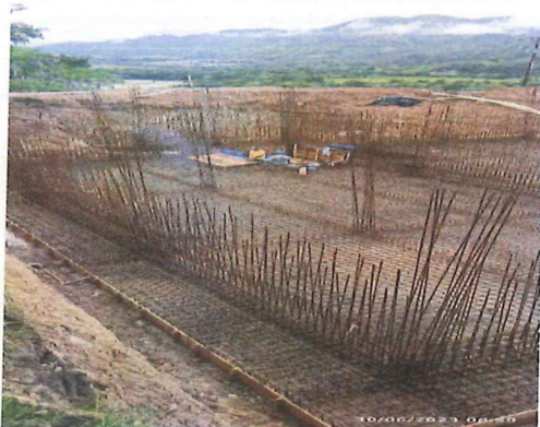
Panorámica de obra
