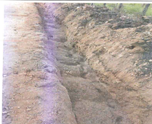
Instalación capa de arena línea de conducción
