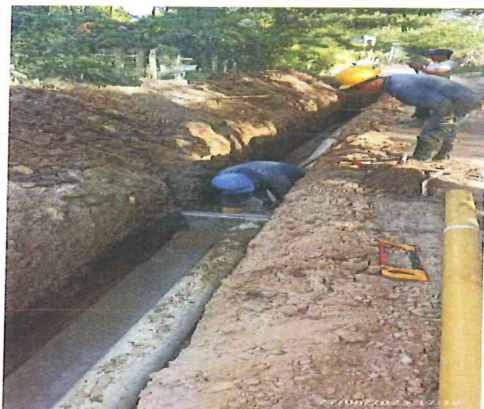
Instalación de tubería de 8"
