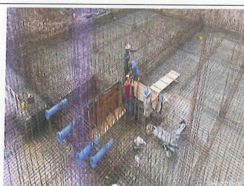
Instalación formaleas en tanque de almacenamiento de agua
