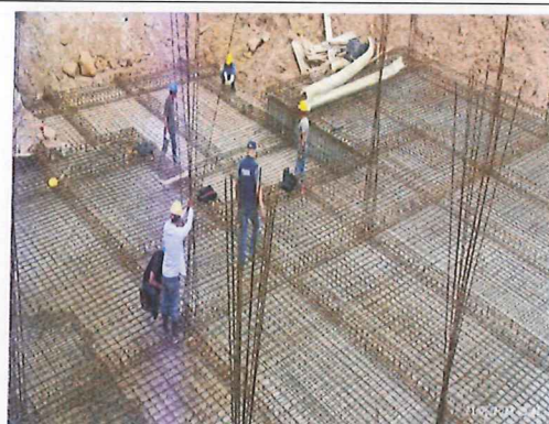
Instalación de Hierros para columnas
