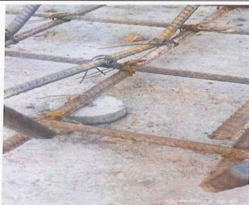
Apoyos para realce de hierro
