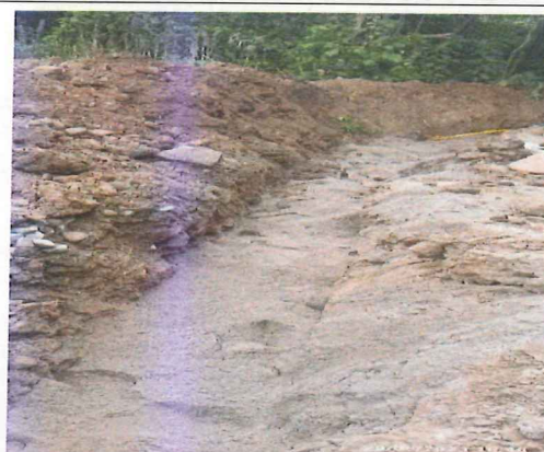
Instalación capa de arena línea de conducción
