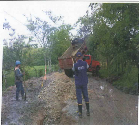
Descargue de recebo en línea de conducción de 8"
