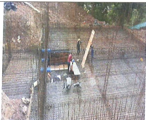
Avance instalación formaleta
