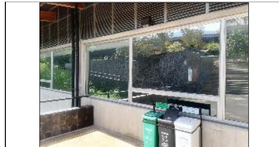
UBICACIÓN: Parque Biblioteca San Antonio de Prado COMENTARIOS: Suministro e instalación de vidrios, Suministro e instalación de película ANTI SOLAR
