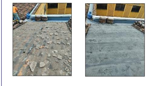
UBICACIÓN: Biblioteca Santa Cruz COMENTARIOS: Mantenimiento y Reparación de techo en teja de barro
