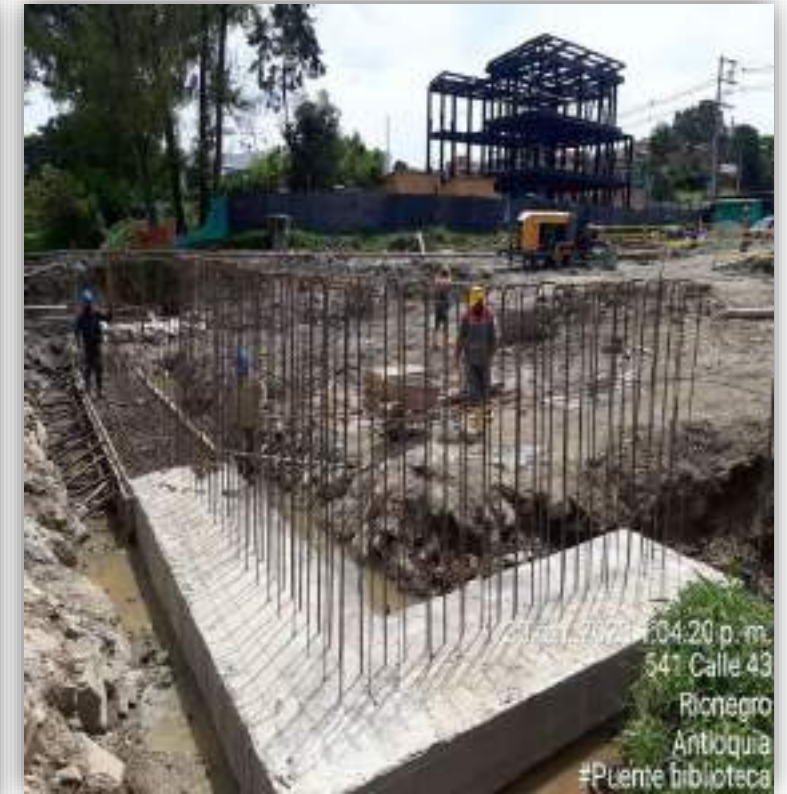
REGISTRO FOTOGRÁFICO CONSTRUCCIÓN DE VIGA CABEZAL PARA MURO DE CONTENCIÓN
