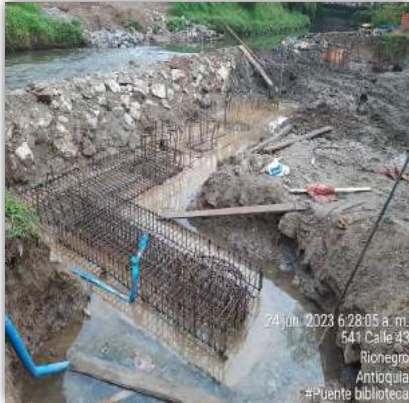
REGISTRO FOTOGRÁFICO CONSTRUCCIÓN DE VIGA CABEZAL PARA MURO DE CONTENCIÓN
