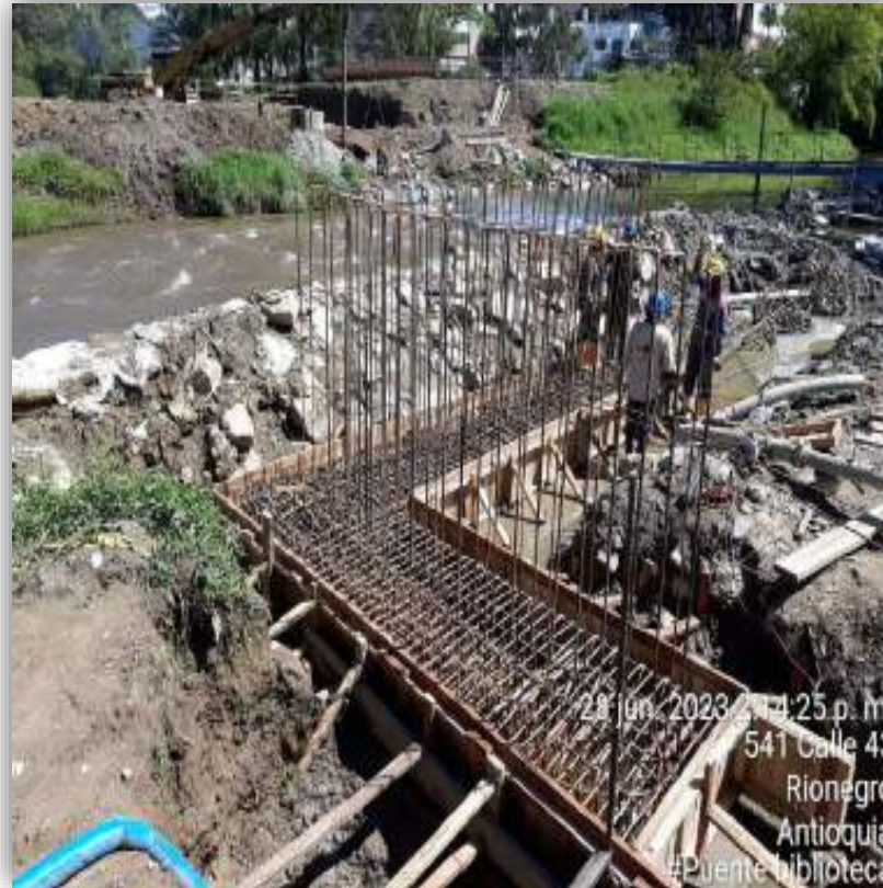
REGISTRO FOTOGRÁFICO CONSTRUCCIÓN DE VIGA CABEZAL PARA MURO DE CONTENCIÓN
