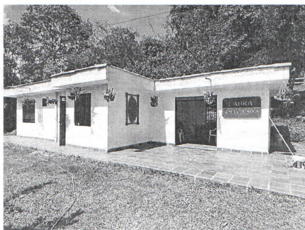
Construcción de Vivienda Nueva
