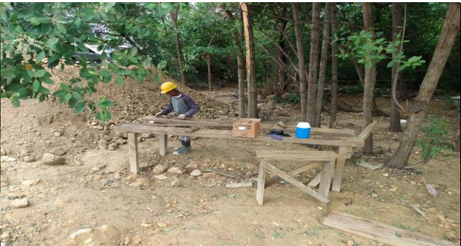
FIGURACION ACERO DE REFUERZO
