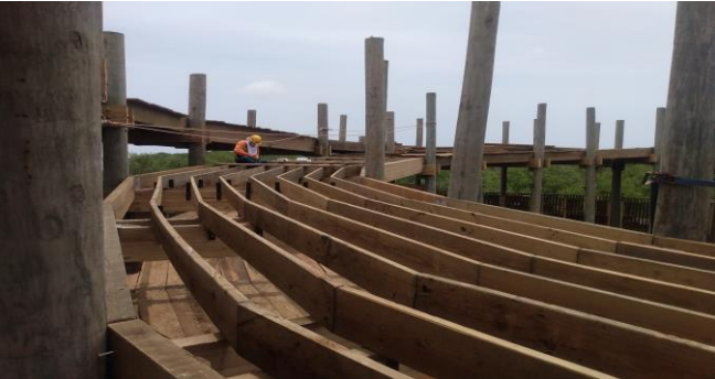
INSTALACION VIGAS LOOP AVISTAMIENTO DE AVES
