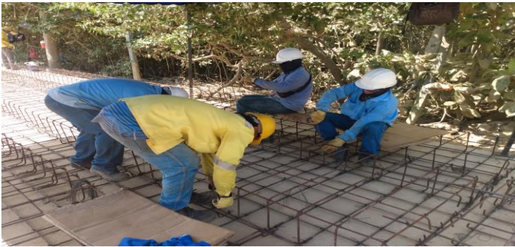
ARMADO ACERO DE REFUERZO MODULO TRANVIA
