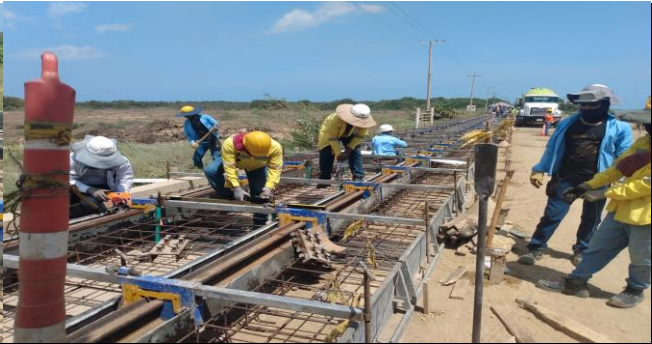
ALINACION Y NIVELACION DE RIELES
