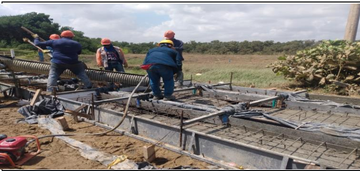
VACIADO CONCRETO LOSA TRANVIA
