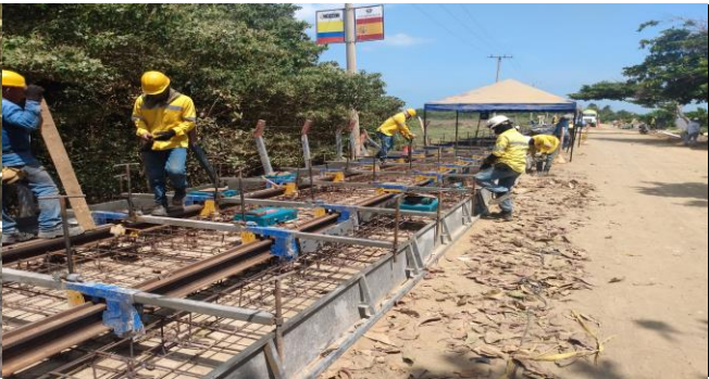
ARMADO FORMALETERIA ESPECIAL TOPDOWN
