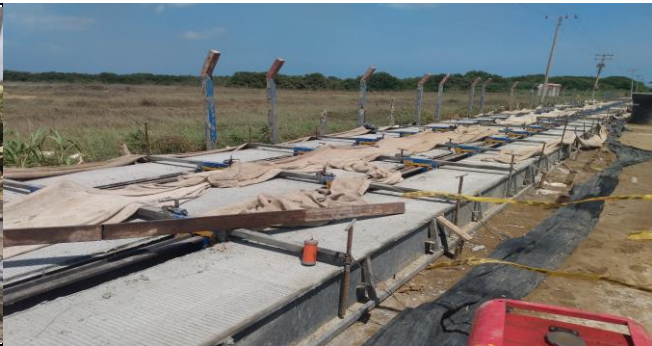
TELA DE FIQUE PARA CONTROL DE CURADO DEL CONCRETO
