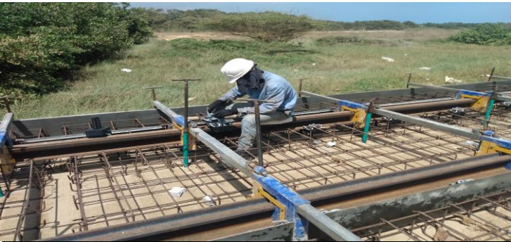
INSTALACION DE SUJECIONES DEL RIEL DEL TRANVIA
