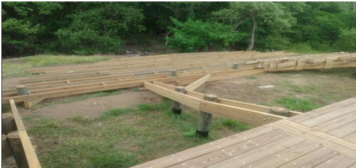
VIGAS ZONA DE CONTEMPLACION
