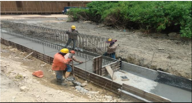
FUNDIDA ZAPATA MURO DE CONTENCIÓN ANDÉN
