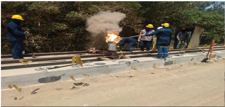
SOLDADURA PUNTAS DE RIELES
