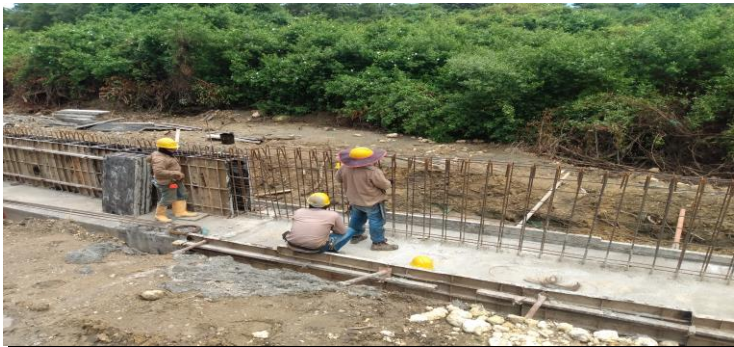
INSTALACION FORMALETAS MURO DE CONTENCION ANDEN
