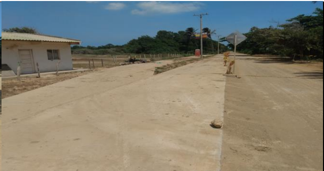
SOLADO ZONA DE BYPASS INTERCAMBIADOR
