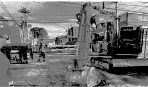
Demolición carpeta asfáltica.
