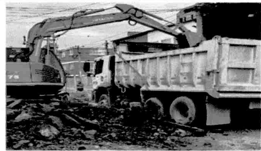
Excavación mecánica y disposición final de escombros.
