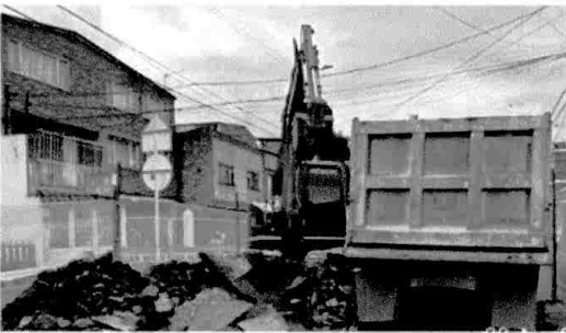
Excavación mecánica y disposición final de escombros.
