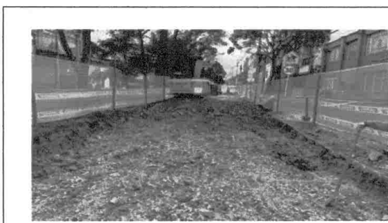
Excavación y lleno de bárrenos con Cal.
