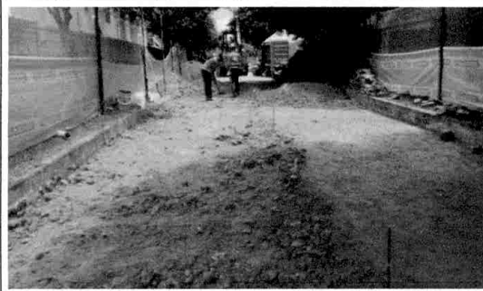
Estabilización de base granular con aditivo potencializado y cemento.
