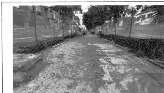
Instalación de geotextil y geocelda.
