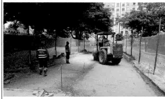
Estabilización de base granular con aditivo potencializado y cemento.
