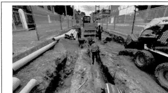
Excavación e instalación de red sanitaria.
