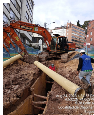
CAMBIO DE TUBERIA EN GRES POR TUBERIA EN MATERIAL PVC
