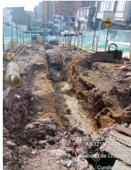
RELLENO PARA PROTECCION DE TUBERIA
