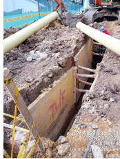
CAMBIO DE TUBERIA EN GRES POR TUBERIA EN MATERIAL PVC
