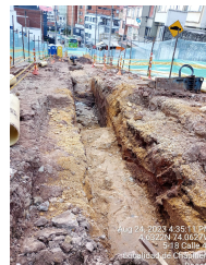
CAMBIO DE TUBERIA EN GRES POR TUBERIA EN MATERIAL PVC
