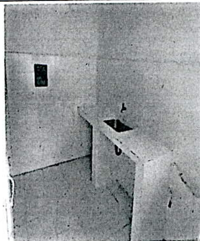
Paredes y mesón de cocina enchapados
