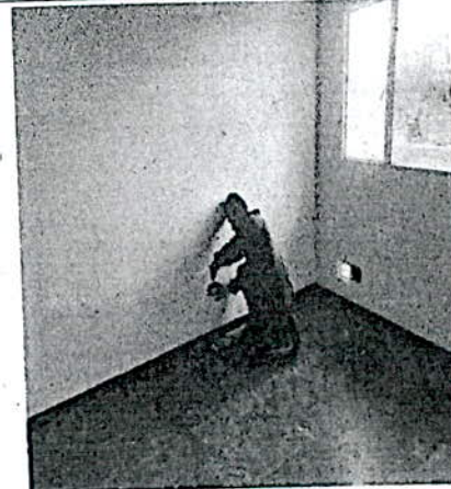
Cambio de interruptor mal estado
