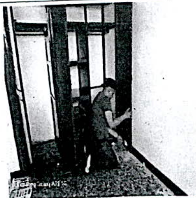
Realizando pintado de closet
