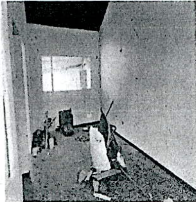
Resane y pintura de paredes internas
