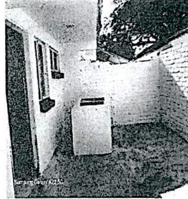
Paredes del patio de ropas pintadas
