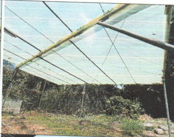
suministro e instalación de cubierta plástica (invernaderos) de 10 más ancho calibre 7.
