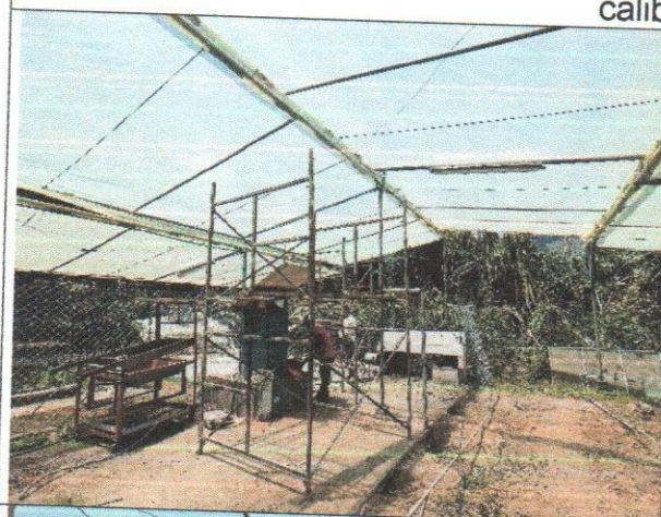
suministro e instalación de cubierta plástica (invernaderos) de 10 más ancho calibre 7.
