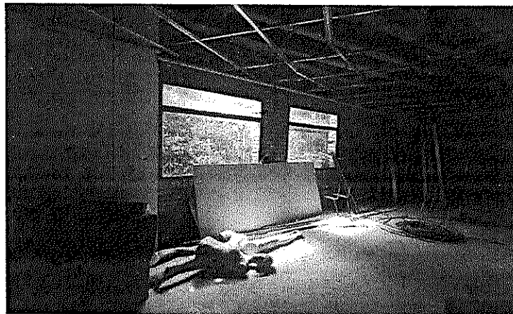
Imagen 20. Salón segundo piso zona de puestos de trabajo.
