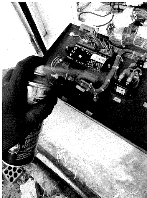
Limpeza y ajuste de contactos de control y potencia
