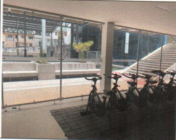
SUMINISTRO E INSTALACIÓN DE TUBO DE PROTECCION EN 2" EN ACERO INOXIDABLE
