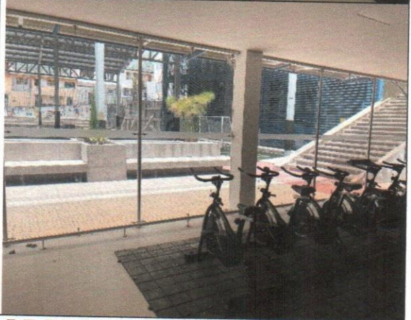
SUMINISTRO E INSTALACIÓN DE TUBO DE PROTECCION EN 2" EN ACERO INOXIDABLE
