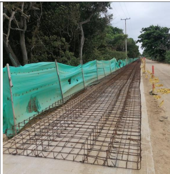
IMAGEN 8 Acero de refuerzo figurado LUGAR: Tajamar 1 FECHA: julio-2023
