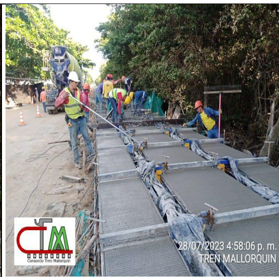
IMAGEN 19 Acabado de concreto final MR38 con micro y macro texturizado. LUGAR: Tajamar 1 FECHA: julio-2023
