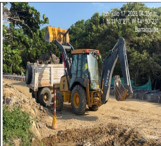
IMAGEN 13 Transporte y disposición final de RCD (Incluye cargue en obra).
