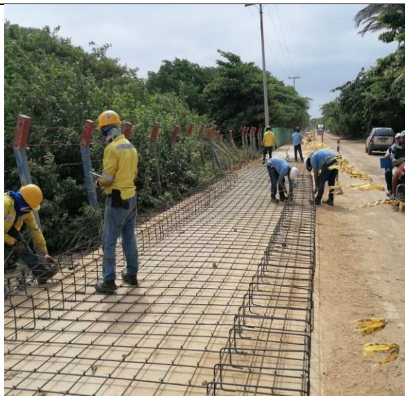
IMAGEN 7 Acero de refuerzo figurado LUGAR: Tajamar 1 FECHA: julio-2023
