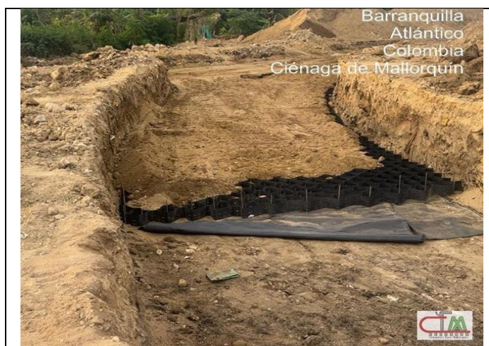
IMAGEN 9 Suministro e instalación geotextil t2100 LUGAR: Tajamar 1 FECHA: julio-2023
