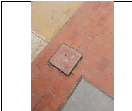
Suministro y construcción de puesta tierra
