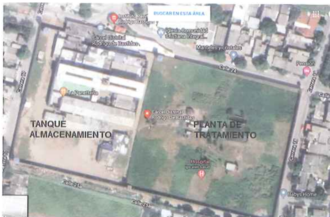
IMAGEN 2. UBICACIÓN DE LA PLANTA DE TRATAMIENTO DENTRO DEL CENTRO PENITENCIARIO.
