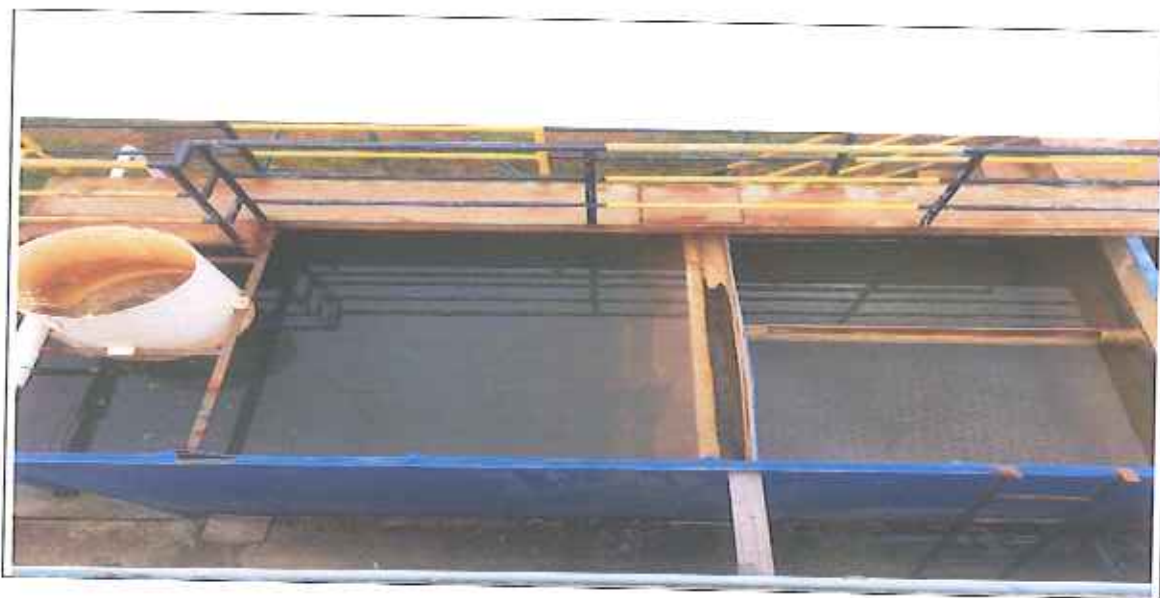
VERIFICACIÓN DEL ESTADO DE LA PLANTA DE AGUA POTABLE
