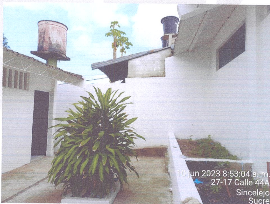
Pintura de muro exterior
