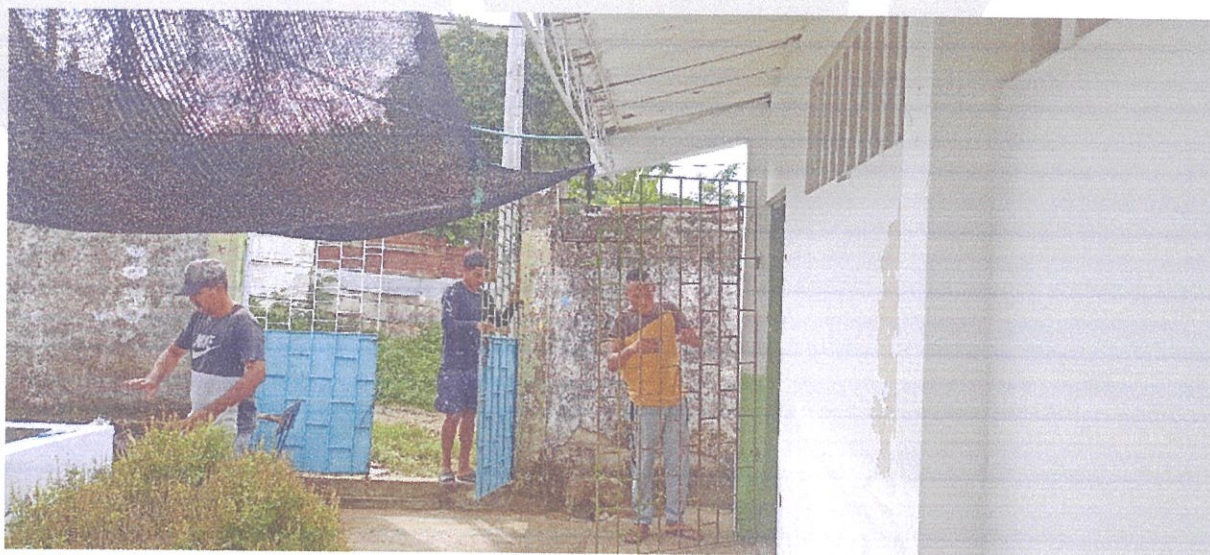
Pintura de rejas puertas de acceso y aula b
