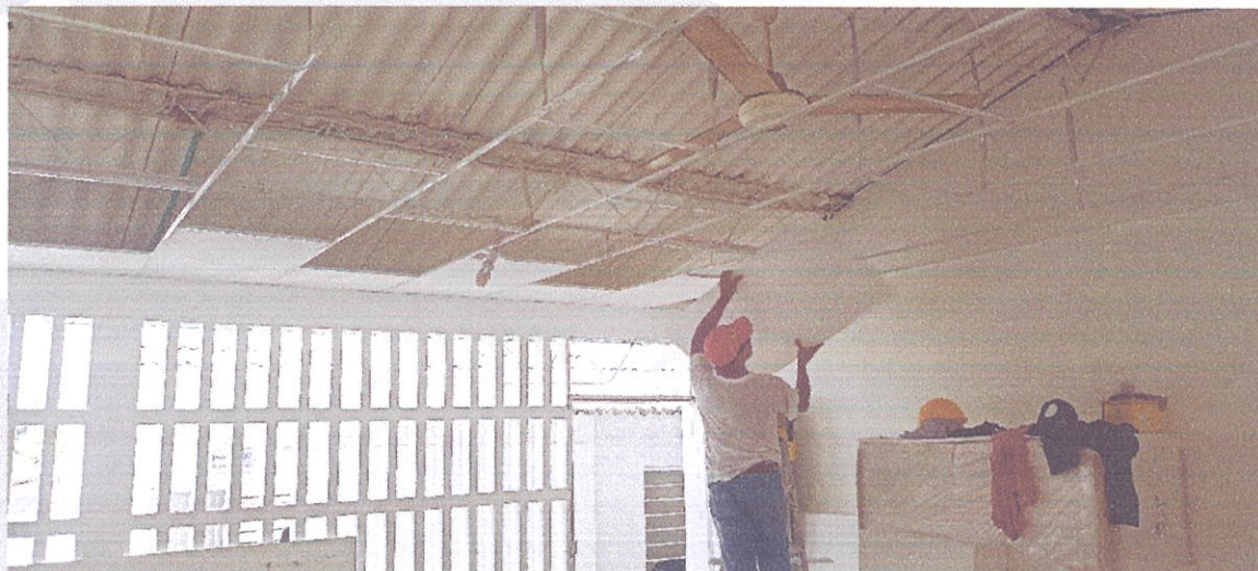
instalación de cielo raso aulas
