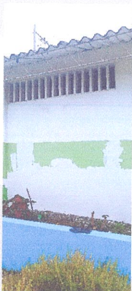
detalle en estuco muro exterior aula A pintura de muro interno y muro exterior.
