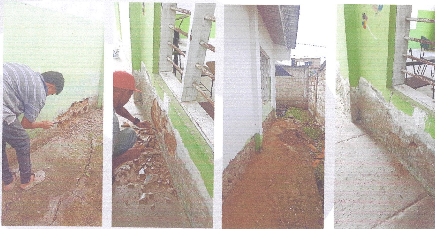
demolicion de pañete en mal estado
