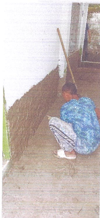
demolicion de pañete en mal estado
