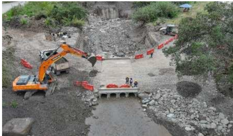
Ilustración 2 - Adecuaciones aproches obra provisional
