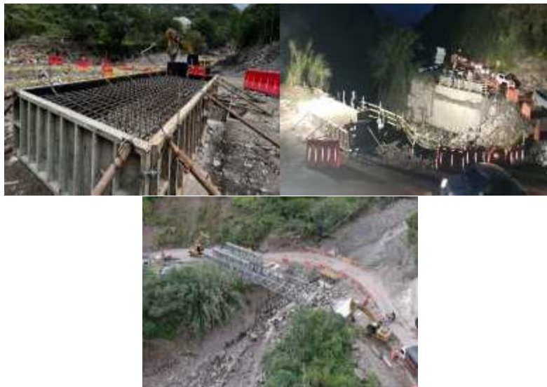
Ilustración 4 - Obras de cimentación para puente metálico provisional
