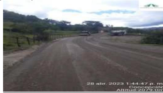
Reciclaje para construcción de estructura pavimento
