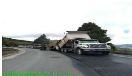
Pavimentación segunda capa
