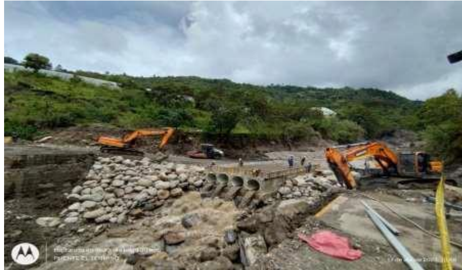
Ilustración 1 - Construcción placa en concreto hidráulica obra provisional
