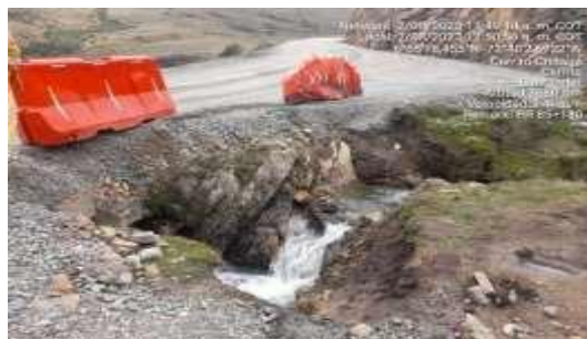
Obras de drenaje
