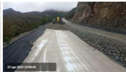
Estructura de soporte pavimento
