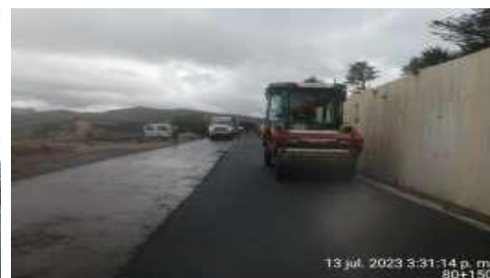
Compactación segunda capa
