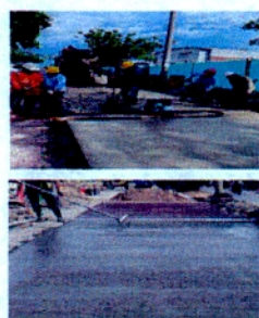
MEZCLA DE CONCRETO PRE MEZCLADO EN PLANTA PARA COLOCACIÓN EN SITIO CON EQUIPO TIPO MIXER, VIBRADO ALLANADO, TEXTURIZADO Y CURADO CON ANTISOL, PAVIMENTO EN CONCRETO E=0.25 MT Y MR=4.2 MPA.
