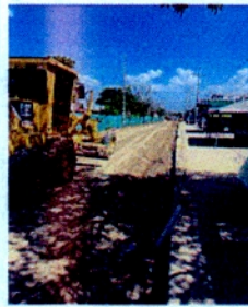
LIMPIEZA Y COMPACTACIÓN DE SUBRASANTE CON EQUIPO MOTONIVELADORA Y VIBROCOMPACTADOR
