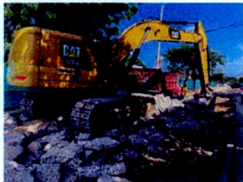
DEMOLICIÓN DE PAVIMENTO RÍGIDO CON LOS SIGUIENTES EQUIPOS: RETROEXCAVADORA 320
