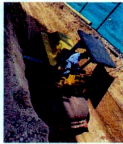
EXCAVACIÓN MECÁNICA CON EQUIPO RETROEXCAVADORA 320 Y ENTIBADO PARA INSTALACIÓN DE TUBERÍA DE 8" Y DE 6"
