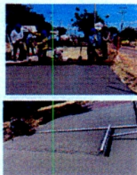
MEZCLA DE CONCRETO PRE MEZCLADO EN PLANTA PARA COLOCACIÓN EN SITIO CON EQUIPO TIPO MIXER, VIBRADO ALLANADO, TEXTURIZADO Y CURADO CON ANTISOL, PAVIMENTO EN CONCRETO E=0.25 MT Y MR=4.2 MPA.
