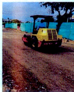
COMPACTACIÓN DE SUB BASE CON EQUIPO VIBROCOMPACTADOR Y TOMA DE DENSIDADES
