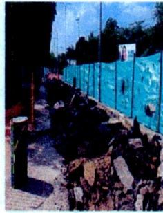
DEMOLICIÓN DE PAVIMENTO RÍGIDO CON LOS SIGUIENTES EQUIPOS: RETROEXCAVADORA 320
