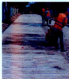
CORTE Y DILATACIÓN DE PLACAS DE PAVIMENTO Y SELLO DE JUNTAS EN CORDÓN DE POLIURETANO CON SELLO DE SILICONA.
