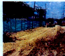
LIMPIEZA DE SUBRASANTE CON EQUIPO MOTONIVELADORA
