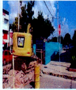
RETIRO DE DEMOLICIÓN DE PAVIMENTO RÍGIDO EXISTENTE CON MAQUINARIA TIPO RETROEXCAVADORA 320 Y VOLQUETA
