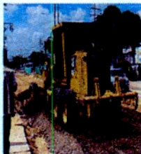
EXTENSIÓN DE MATERIAL DE SUB BASE GRANULAR TIPO INVIAS CON MOTONIVELADORA
