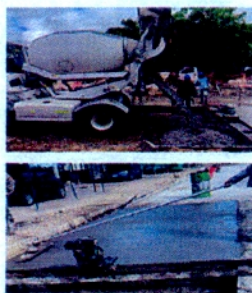
MEZCLA DE CONCRETO PRE MEZCLADO EN PLANTA PARA COLOCACIÓN EN SITIO CON EQUIPO TIPO MIXER, VIBRADO ALLANADO, TEXTURIZADO Y CURADO CON ANTISOL, PAVIMENTO EN CONCRETO E=0.25 MT Y MR=4.2 MPA.
