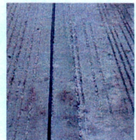
CORTE Y DILATACIÓN DE PLACAS DE PAVIMENTO Y SELLO DE JUNTAS EN CORDÓN DE POLIURETANO CON SELLO DE SILICONA.
