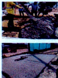
MEZCLA DE CONCRETO PRE MEZCLADO EN PLANTA PARA COLOCACIÓN EN SITIO CON EQUIPO TIPO MIXER, VIBRADO ALLANADO, TEXTURIZADO Y CURADO CON ANTISOL, PAVIMENTO EN CONCRETO E=0.25 MT Y MR=4.2 MPA.
