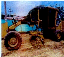
LIMPIEZA DE SUBRASANTE CON EQUIPO MOTONIVELADORA
