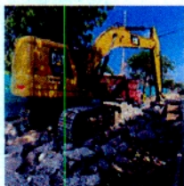
RETIRO DE DEMOLICIÓN DE PAVIMENTO RÍGIDO EXISTENTE CON MAQUINARIA TIPO RETROEXCAVADORA 320 Y VOLQUETA
