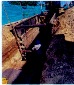
EXCAVACIÓN MECÁNICA CON EQUIPO RETROEXCAVADORA 320 Y ENTIBADO PARA INSTALACIÓN DE TUBERÍA DE 8" Y DE 6"
