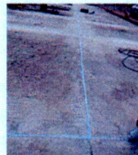
CORTE Y DILATACIÓN DE PLACAS DE PAVIMENTO Y SELLO DE JUNTAS EN CORDÓN DE POLIURETANO CON SELLO DE SILICONA.
