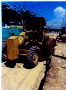
EXTENSIÓN Y HUMECTACIÓN DE MATERIAL DE SUB BASE GRANULAR TIPO INVIAS CON MOTONIVELADORA Y CARROTANQUE
