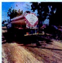
HUMECTACIÓN Y COMPACTACIÓN DE SUB BASE CON EQUIPO VIBROCOMPACTADOR
