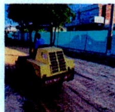
HUMECTACIÓN Y COMPACTACIÓN DE SUB BASE CON EQUIPO VIBROCOMPACTADOR
