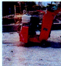
CORTE Y DILATACIÓN DE PLACAS DE PAVIMENTO Y SELLO DE JUNTAS EN CORDÓN DE POLIURETANO CON SELLO DE SILICONA.
