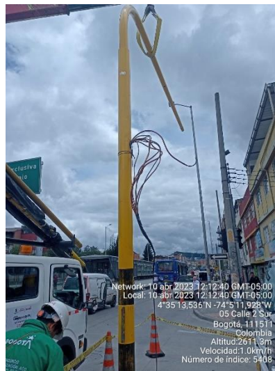
Imagen 8. INSTALACION DE POSTE EXT. 3045
