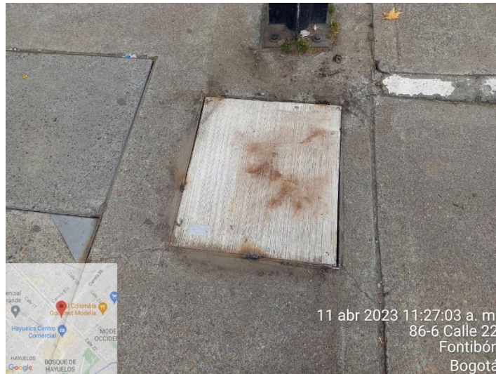
Imagen 7. INSTALACION DE TAPAS EXT. 2844
