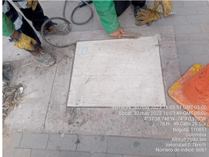
Imagen 5. INSTALACION DE TAPAS EXT. 3460
