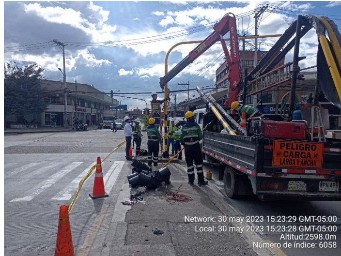
Imagen 3. INSTALACION DE POSTE EXT. 2023
