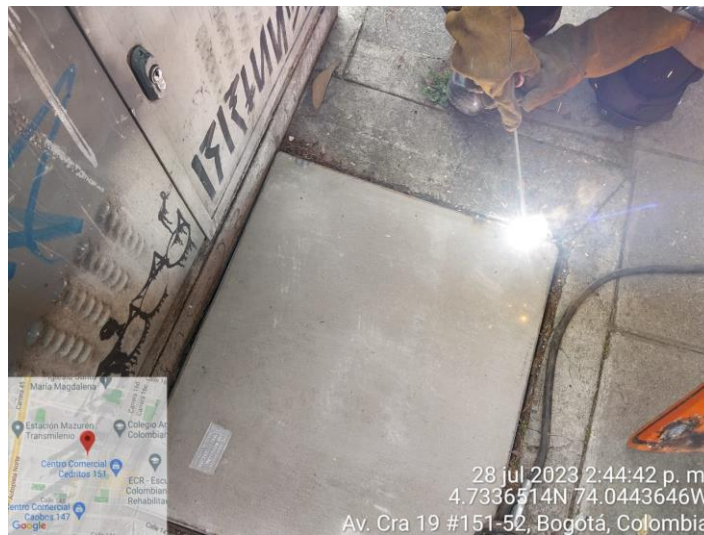
Imagen 6. INSTALACION DE TAPAS EXT. 1620
