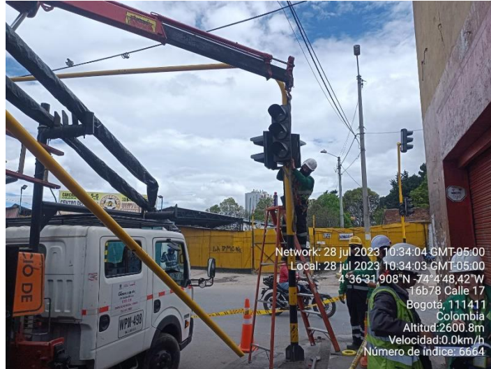
Imagen 5. INSTALACION DE POSTE EXT. 2954
