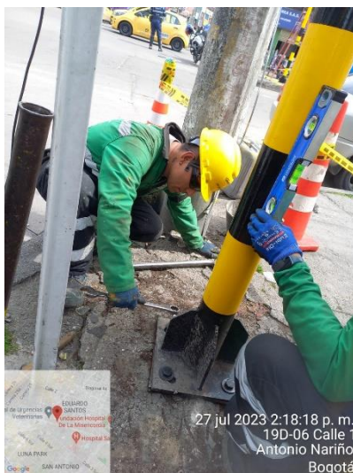
Imagen 7. NIVELACION DE POSTE EXT. 3707
