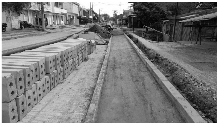
FOTO No.11. CONSTRUCCION DE VIAS Y ANDENES DEL CORREDOR VIAL ARGELIA PERTENECIENTE AL SISTEMA ESTRATEGICO DE TRANSPORTE PUBLICO DE PASAJEROS DE LA CIUDAD DE SINCELEJO - FASE II. visita de obra, en compañía de la interventoría, en donde se procedió a la revisión de las actividades realizadas por el contratista de obra. - Actividad de BORDILLO BARRERA RECTO U10 (800x150x450mm) (Incluye suministro, transporte, instalación, y demás actividades para su correcta colocación en obra)
