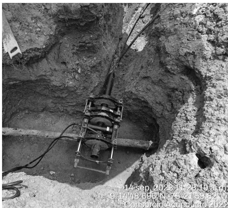
FOTO No.2. OPTIMIZACIÓN DEL SISTEMA DE ACUEDUCTO EN EL CORREGIMIENTO CASTAÑEDA, VEREDA MIRABEL Y VEREDA LA GARITA PERTENECIENTES AL MUNICIPIO DE SINCELEJO visita de obra, en compañía de la interventoría, en donde se procedió a la revisión de las actividades realizadas por el contratista de obra. – actividad de tee de polietileno dn = 3"
