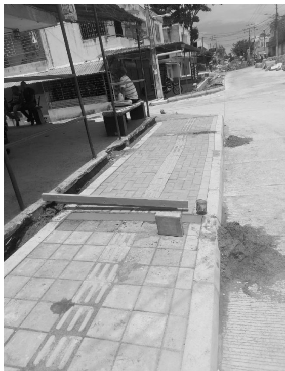
FOTO No.12. CONSTRUCCION DE VIAS Y ANDENES DEL CORREDOR VIAL ARGELIA PERTENECIENTE AL SISTEMA ESTRATEGICO DE TRANSPORTE PUBLICO DE PASAJEROS DE LA CIUDAD DE SINCELEJO - FASE II. visita de obra, en compañía de la interventoría, en donde se procedió a la revisión de las actividades realizadas por el contratista de obra. - Actividad de Construcción de andenes.
