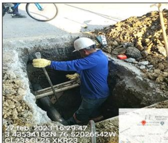
Redes existentes en apique de lanzamiento.
