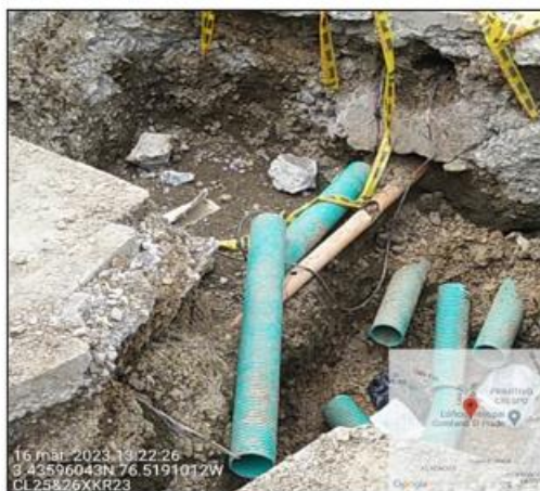
Redes existentes en excavación anclajes.
