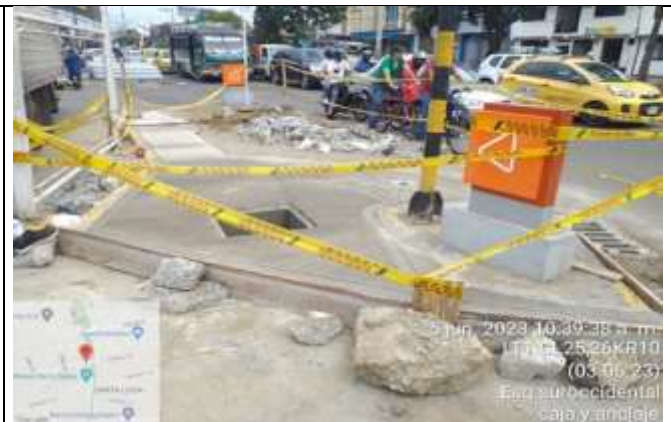
Foto No. 4 Descripción: Reposición de Anden y Sardinel
