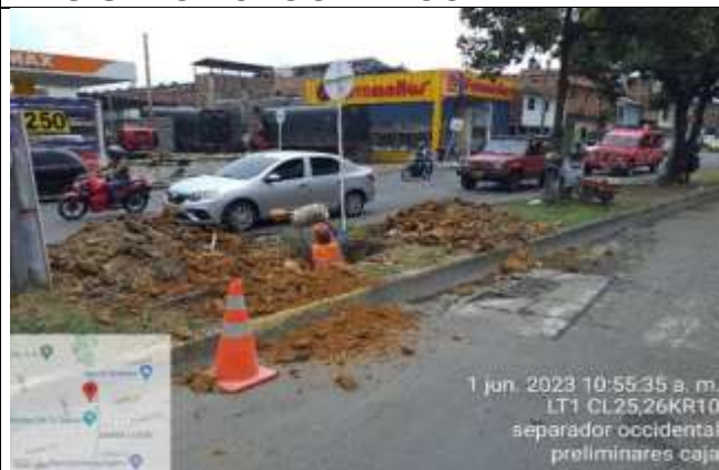
Foto No. 1 Apiques para fundición de caja y anclaje
