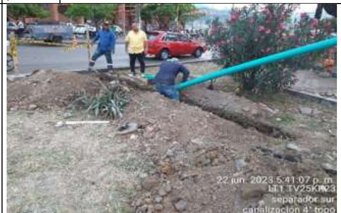
Foto 6 Entubar excavación topo de 4"
