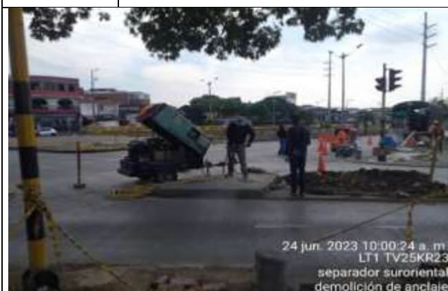
Foto 5- Limpieza de caja de inspección existente
