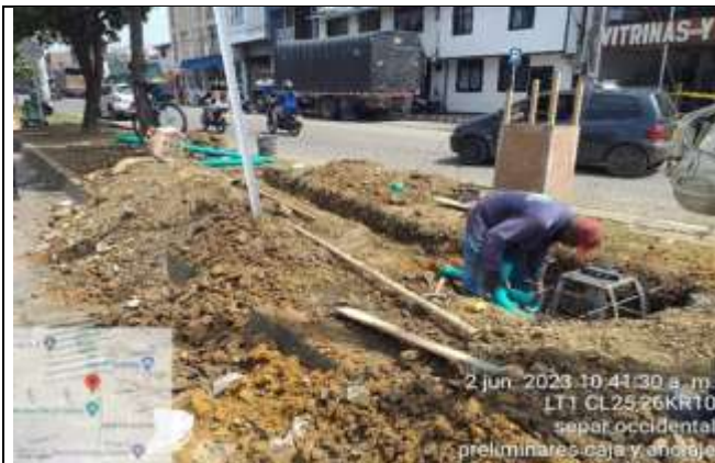
Foto No. 3 Preliminar de fundición de anclaje
