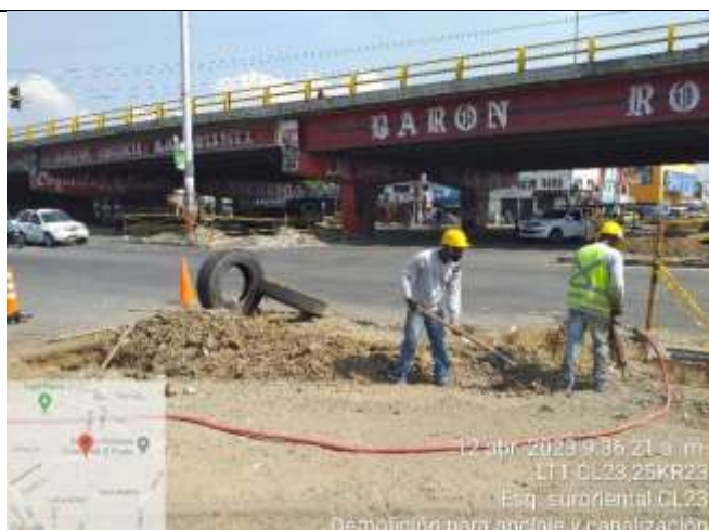
Foto No. 2 | Descripción: Demolición de andén
