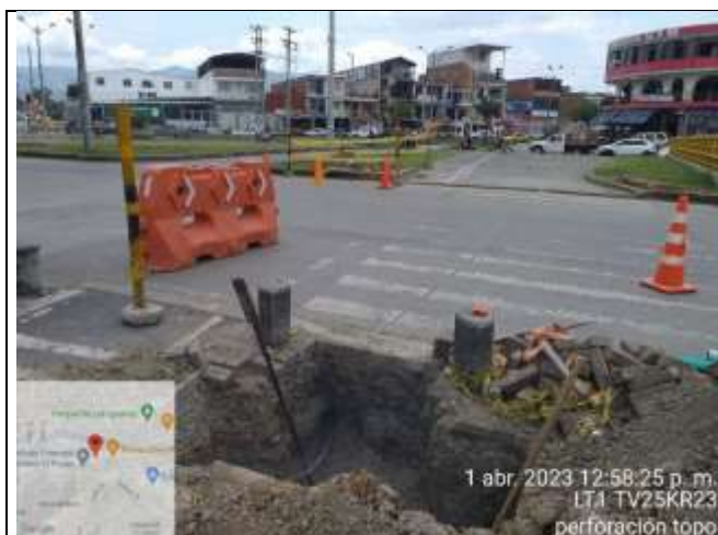
Foto No. 1 | Apiques de lanzamiento de topo
