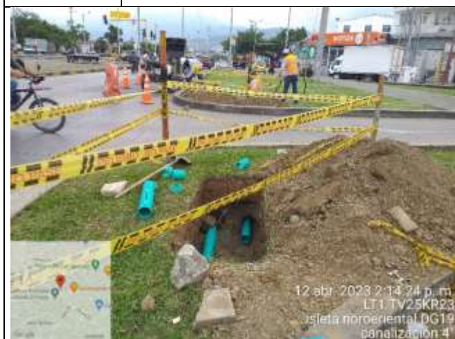
Foto No. 3 | Perforación neumática.
