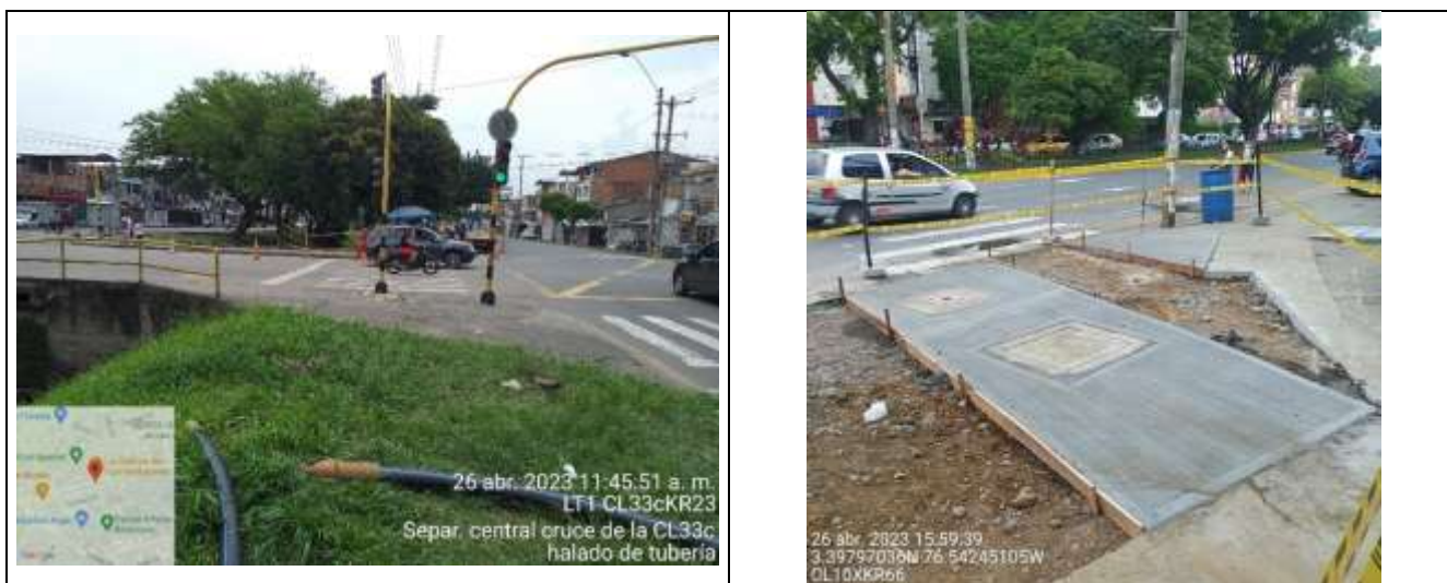
Foto 9 Halado de tubería PHD
