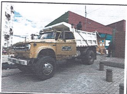
FOTO 22 COLEGIO ALFREDO IRIARTE Retiro de sobrantes
