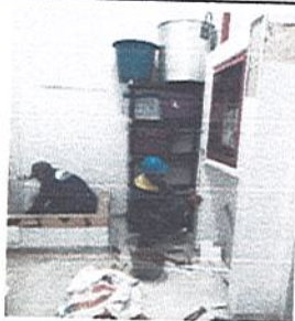
FOTO 5 COLEGIO ANTONIA SANTOS Demolicion enchape y granito
