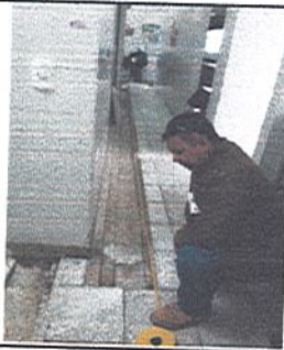
FOTO 4 COLEGIO ANTONIA SANTOS Medición carcamos cocina
