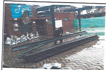
FOTO 12 COLEGIO ANTONIO BARAYA Llega material para cubierta
