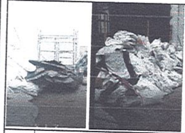
FOTO 3 COLEGIO AGUSTIN NIETO CABALLERO Acopio de escombros
