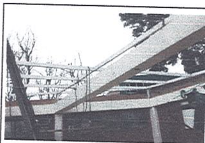
FOTO 10 COLEGIO EL LIBERTADOR Instalacion estructura metalica
