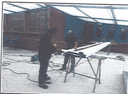
FOTO 8 COLEGIO EL LIBERTADOR Pintura estructura metalica
