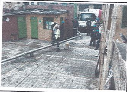
FOTO 16 COLEGIO ALFREDO IRIARTE Inicio fundida cancha
