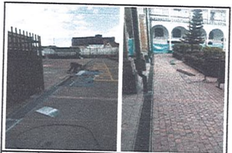
FOTO 11 COLEGIO AGUSTIN NIETO CABALLERO Anticorrosivo Rejilla Carcamo 1 y 2
