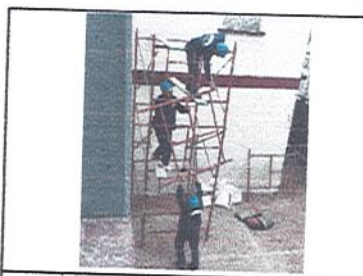
FOTO 7 COLEGIO ANTONIO RICAURTE Armada de andamios para impermeabilización placa
