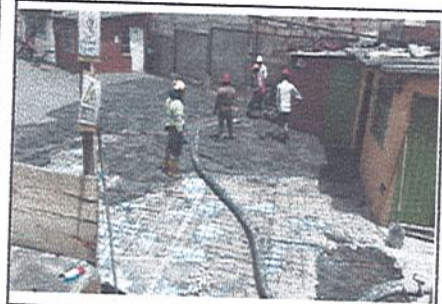
FOTO 18 COLEGIO ALFREDO IRIARTE Fundida cancha con bomba
