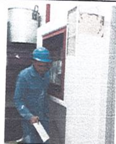
FOTO 6 COLEGIO ANTONIA SANTOS Demolicion enchape
