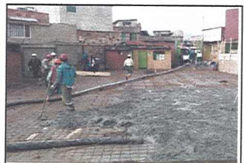
FOTO 3 COLEGIO ALFREDO IRIARTE Fundida placa cancha
