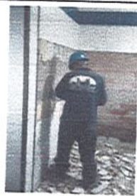
FOTO 11 COLEGIO SANTA LUCIA Demolicion enchape
