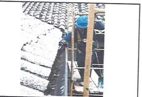
FOTO 7 COLEGIO AGUSTIN NIETO CABALLERO Limpieza canales patio 1
