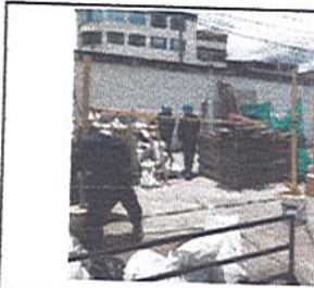
FOTO 6 COLEGIO AGUSTIN NIETO CABALLERO Acopio de escombros
