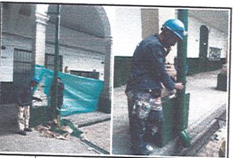
FOTO 12 COLEGIO AGUSTIN NIETO CABALLERO Arreglo bajantes patio 1 y 2
