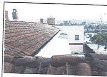
FOTO 9 COLEGIO ANTONIO RICAURTE Impermeabilización placa sobre circulación
