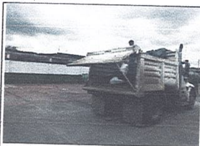
FOTO 4 COLEGIO AGUSTIN NIETO CABALLERO Retiro de escombros
