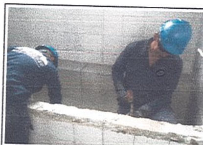
FOTO 12 COLEGIO SANTA LUCIA Demolicion granito
