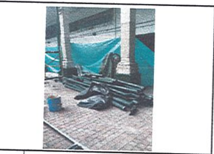
FOTO 10 COLEGIO AGUSTIN NIETO CABALLERO Retiro de bajantes
