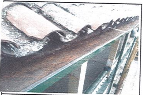
FOTO 9 COLEGIO AGUSTIN NIETO CABALLERO Limpieza canales patio 2
