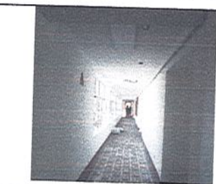
FOTO 8 COLEGIO ANTONIO RICAURTE Instalación lámparas
