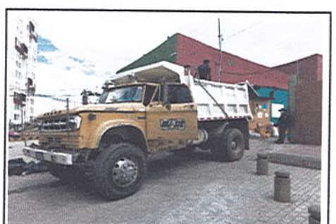
FOTO 6 COLEGIO ALFREDO IRIARTE Retiro de sobrantes
