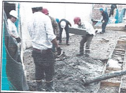
FOTO 17 COLEGIO ALFREDO IRIARTE Fundida cancha con bomba y formaleta carcamo
