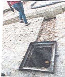
FOTO 14 COLEGIO ALFREDO IRIARTE Colocacion marcos y conexión carcamo a caja
