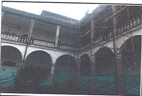
FOTO 8 COLEGIO AGUSTIN NIETO CABALLERO Limpieza canales patio 1
