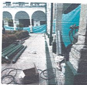
FOTO 2 COLEGIO AGUSTIN NIETO CABALLERO Arreglo Rejillas Patio
