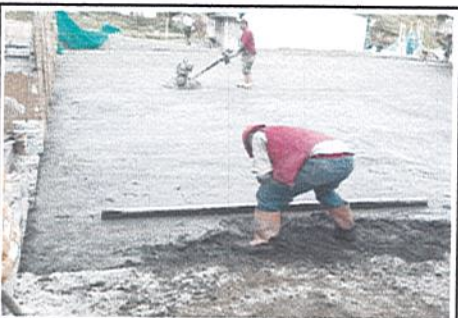
FOTO 4 COLEGIO ALFREDO IRIARTE Fundida placa cancha
