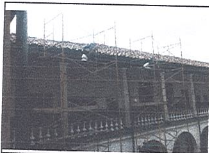
FOTO 1 COLEGIO AGUSTIN NIETO CABALLERO Limpieza de canales
