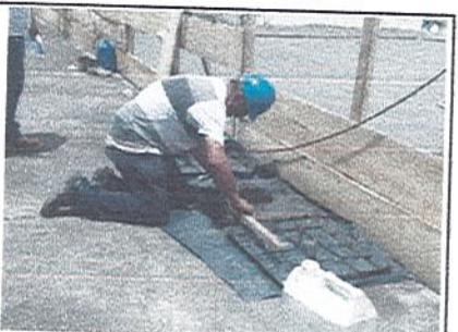
FOTO 19 COLEGIO ALFREDO IRIARTE Fundida tapas cajas
