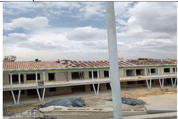
Sector 1/ cubierta/ continuación de actividad de instalación de teja de barro
