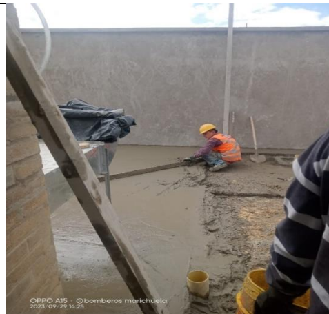
Sector 3/cubierta/ vaciado de sobre piso en zona de punto fijo
