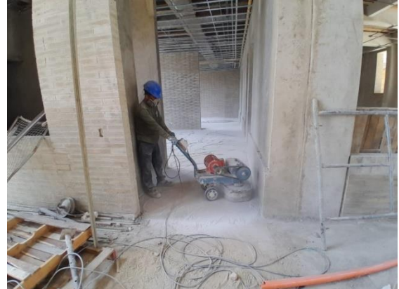
Destronque de enchapes - sector 1// piso 1 // hall portería.
