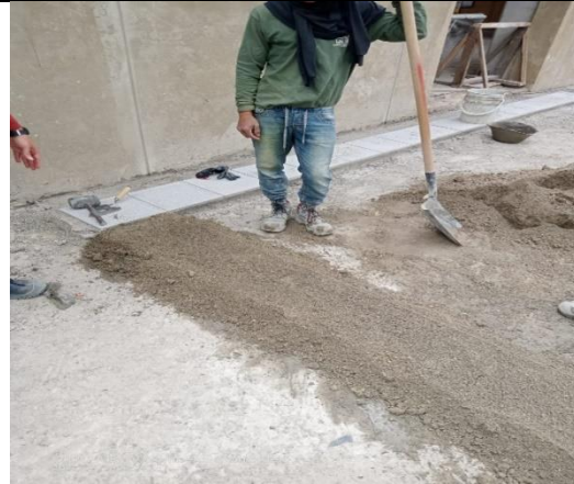
Sector 1/circulación/ aplicación de mezcla para instalación de enchape de piso
