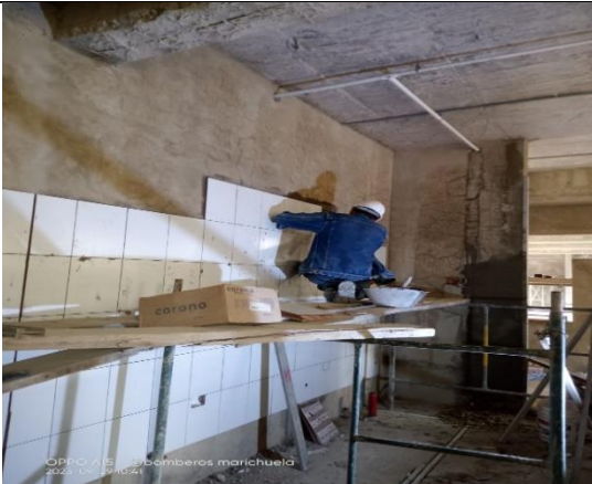
Sector 3/ servicios/ enchape de muro para cocina
