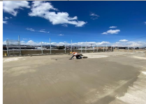
Instalación de alistado en mortero impermeabilizado - sector 5 // nivel cubierta.
