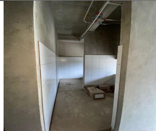
Sector 3/Servicios/ enchapes para muros de zonas húmeda
