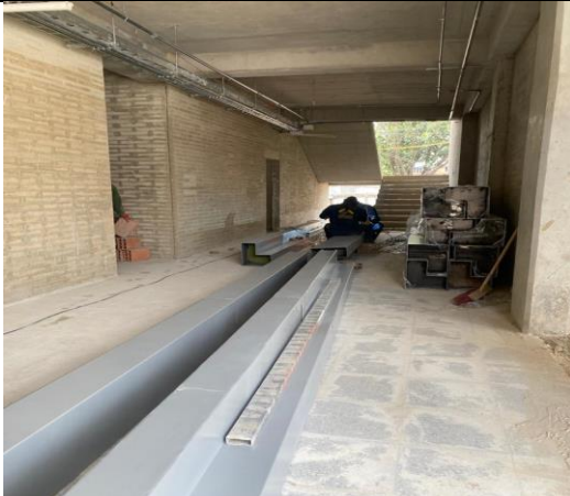
Armado de estructura metálica para fachada occidental // sector 5 // punto fijo
