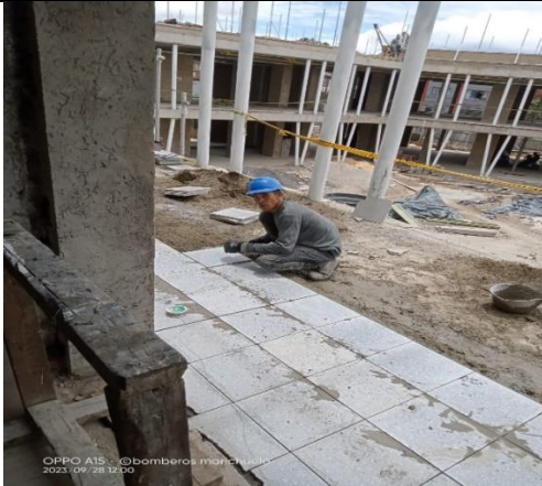
Sector 1/circulación/instalación de enchape de piso en granito pulido
