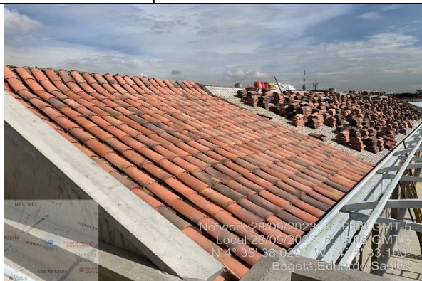
Sector 1/ cubierta/ instalación de teja de barro
