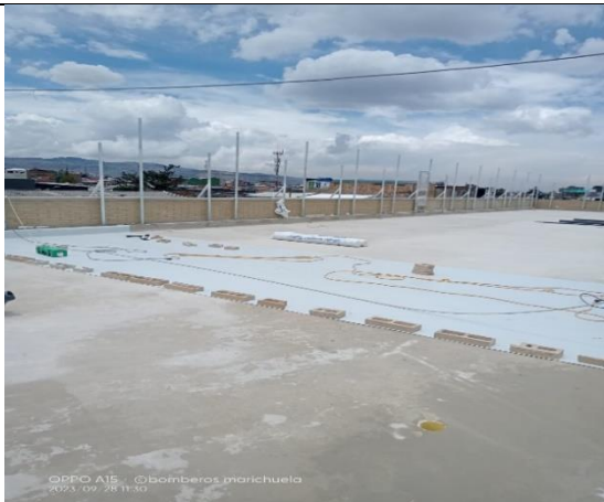
Sector 5/ cubierta/ instalación de membrana impermeabilizante
