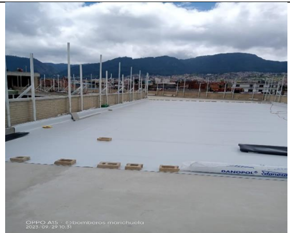
Sector 5/cubierta/ continuación de impermeabilización de membrana
