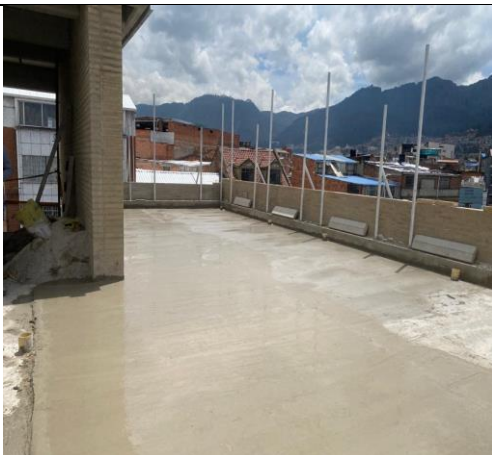
Sector 4/cubierta/vaciado de sobre piso
