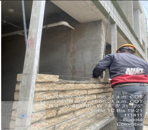
Instalación de mampostería tipo siciliano Split - sector 3 // nivel 1 //fachada norte.
