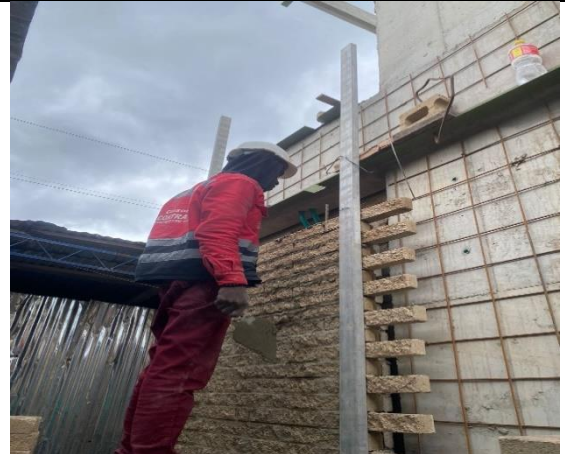
Instalación de mampostería tipo siciliano Split - sector 3 // nivel 1 //fachada norte.
