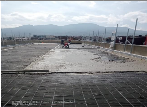
Instalación de alistado en mortero impermeabilizado - sector 5 // nivel cubierta.
