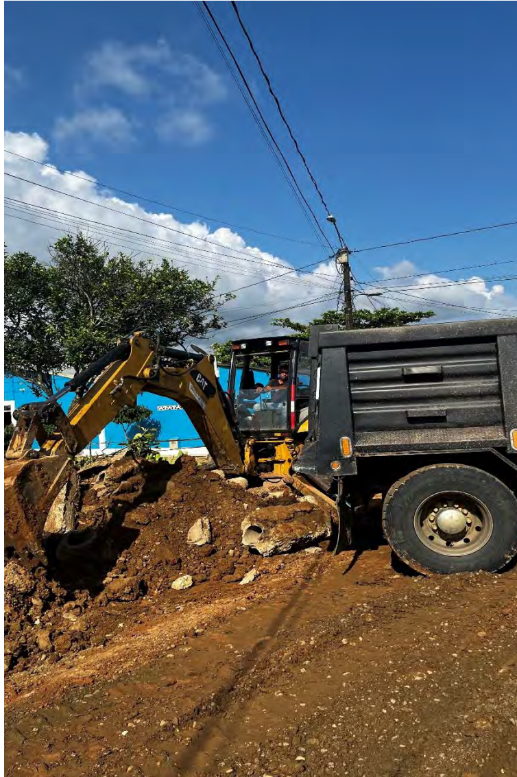
Imagen 4 Retiro de escombros
