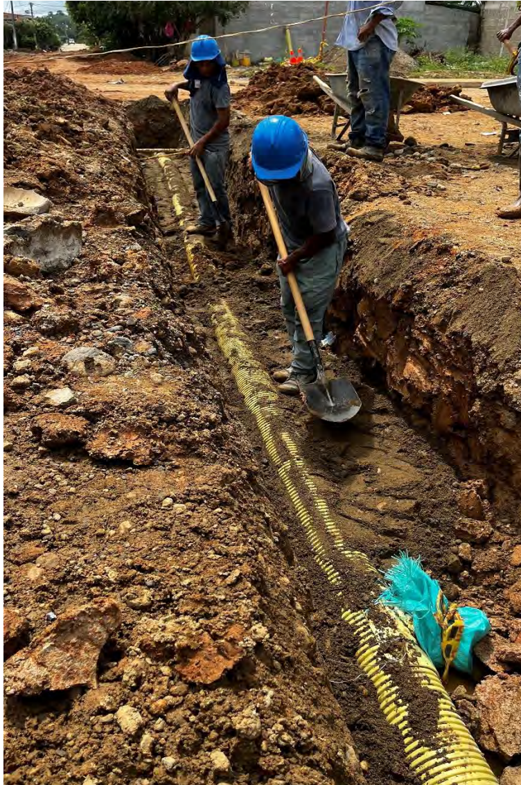
Imagen 14 Relleno cama de arena
