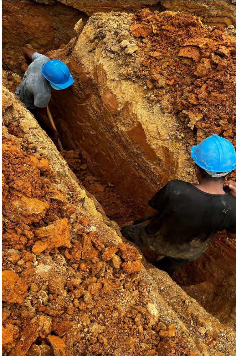
Imagen 9 Excavación a mano material común
