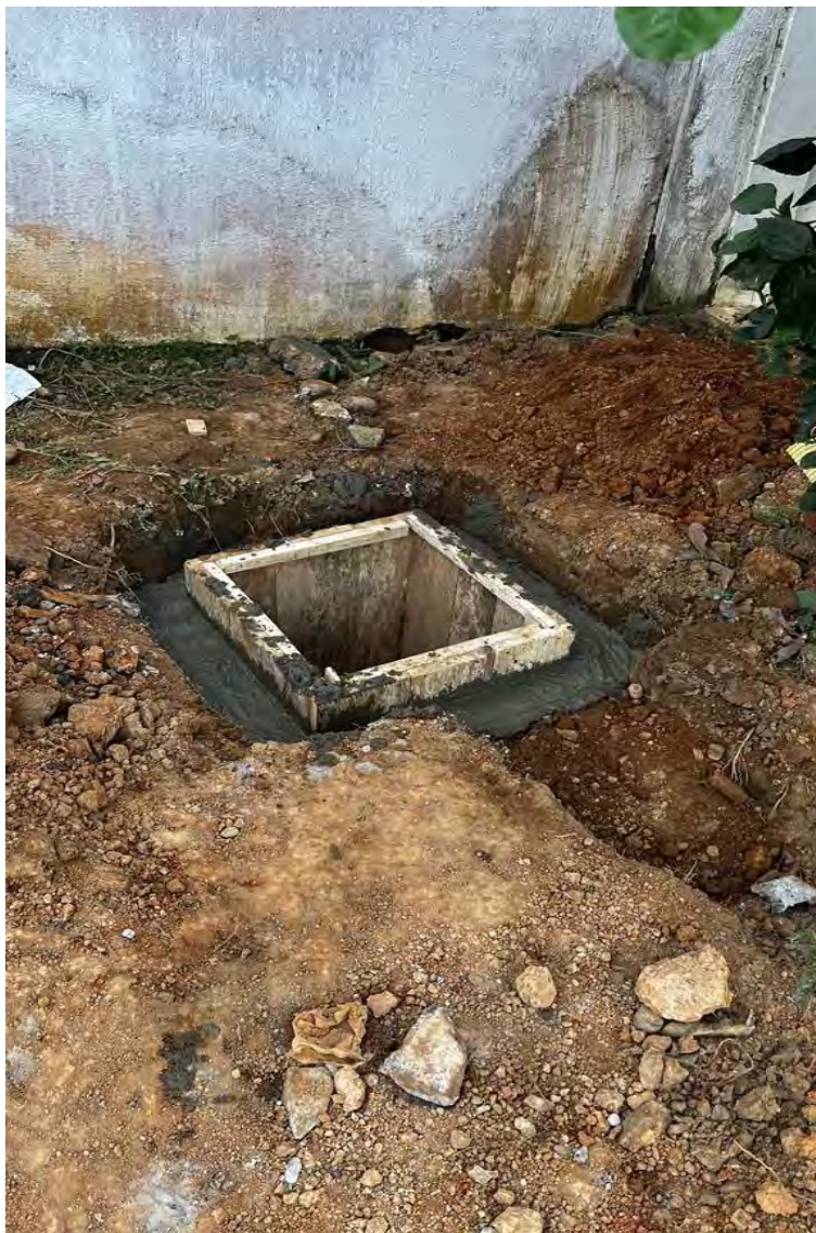
Imagen 18 Construcción registro
