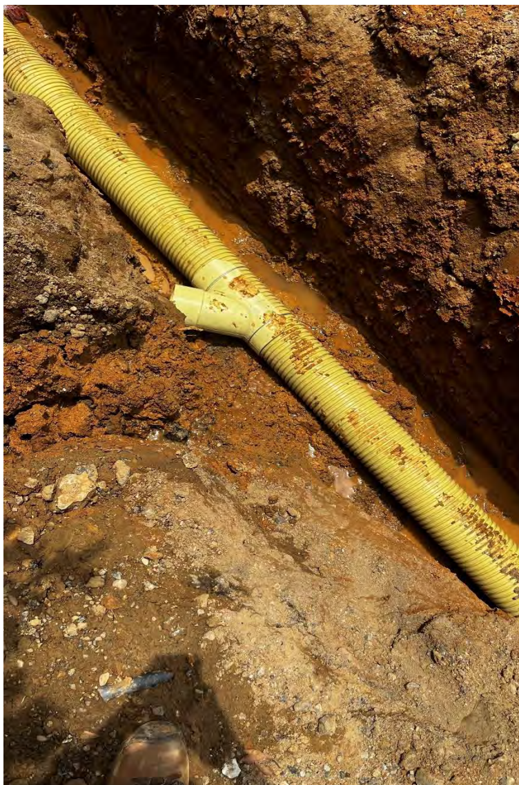
Imagen 27 Suministro e instalación silla yee
