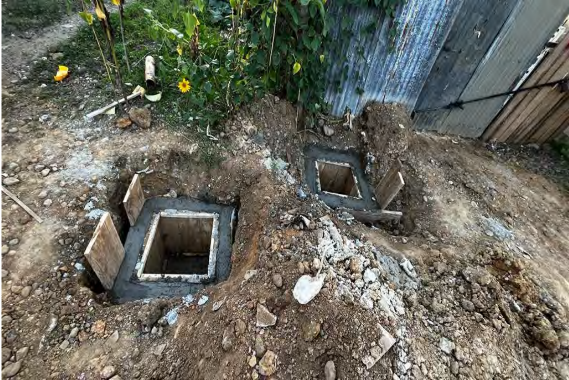
Imagen 16 Construcción de registro
