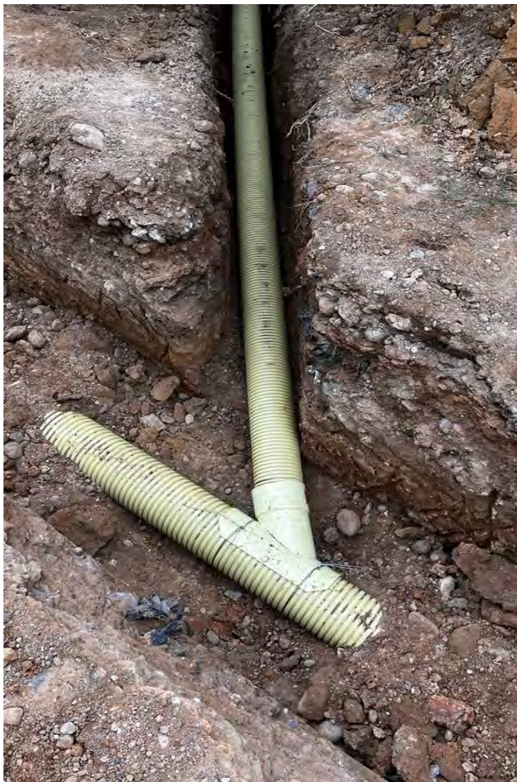
Imagen 15 Instalación de tubería, silla yee y domiciliaria
