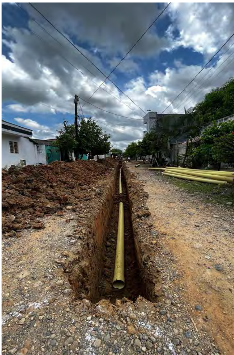
Imagen 12 Instalación de tubería
