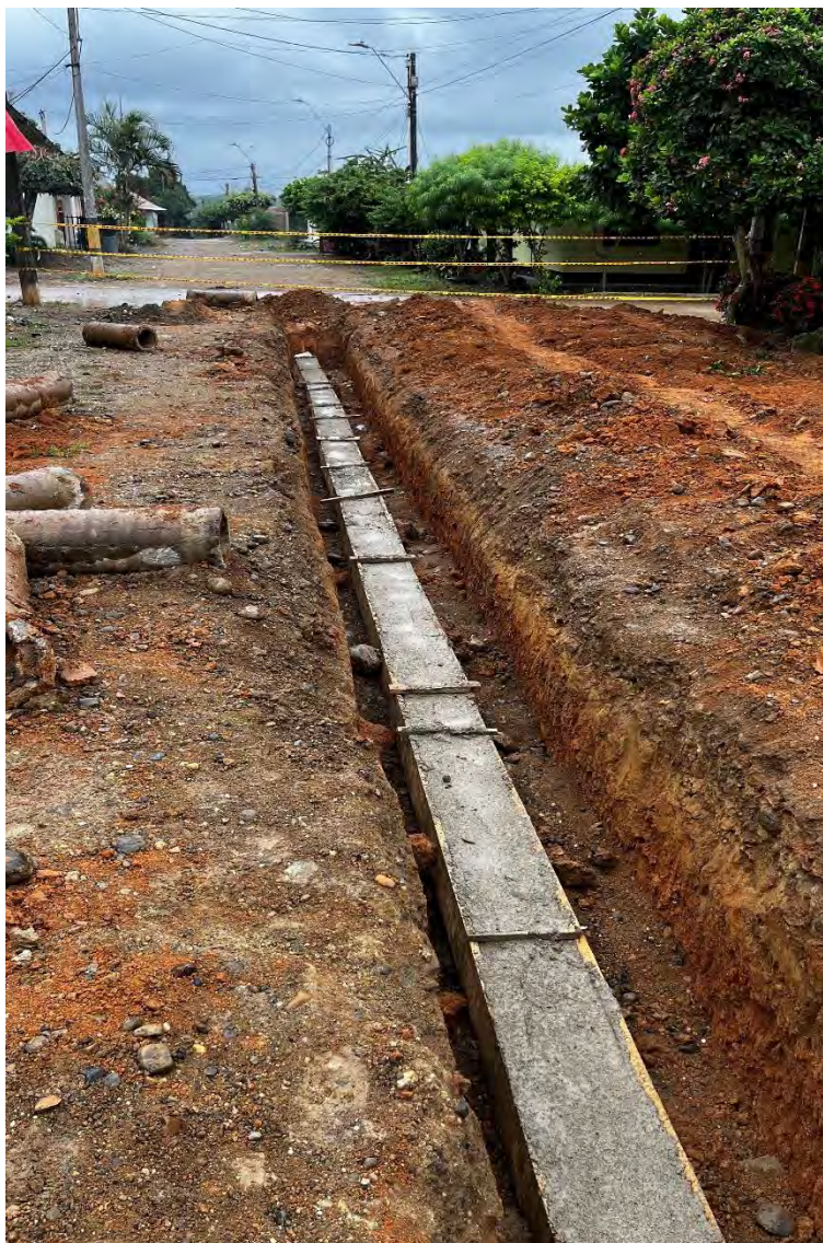
Imagen 36 Atraque en concreto para tubería
