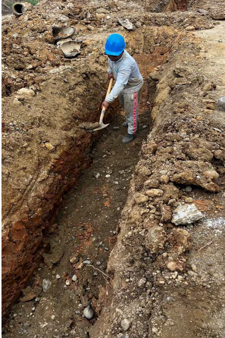
Imagen 15 Relleno cama de arena
