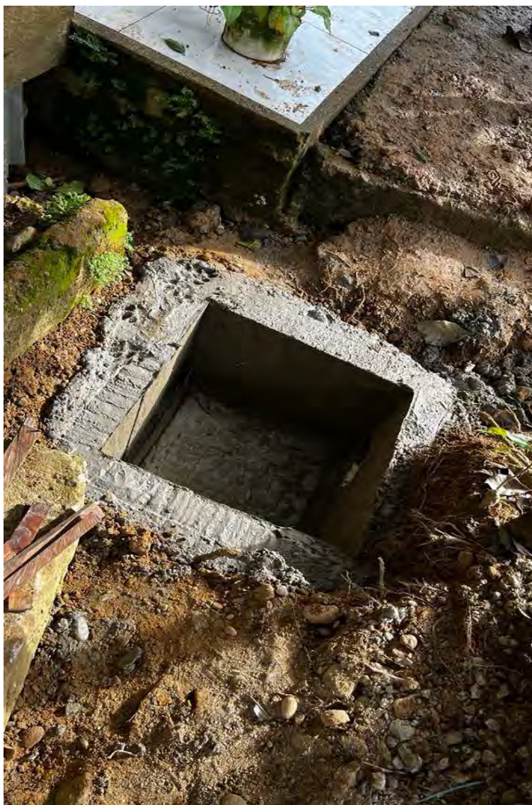
Imagen 17 Construcción de registro
