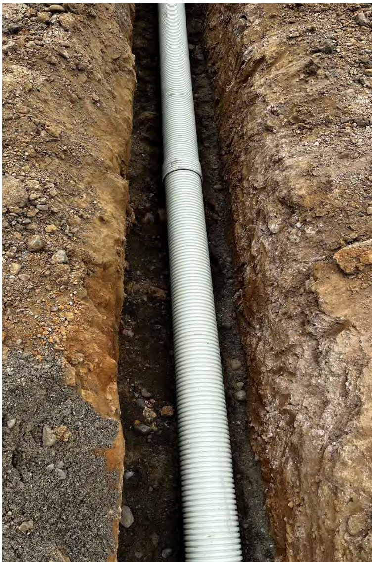
Imagen 13 Relleno cama de arena
