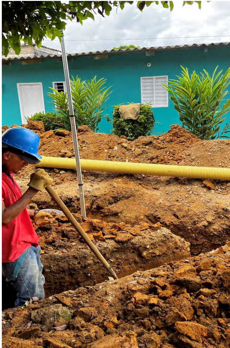
Imagen 7 Excavación a mano material común
