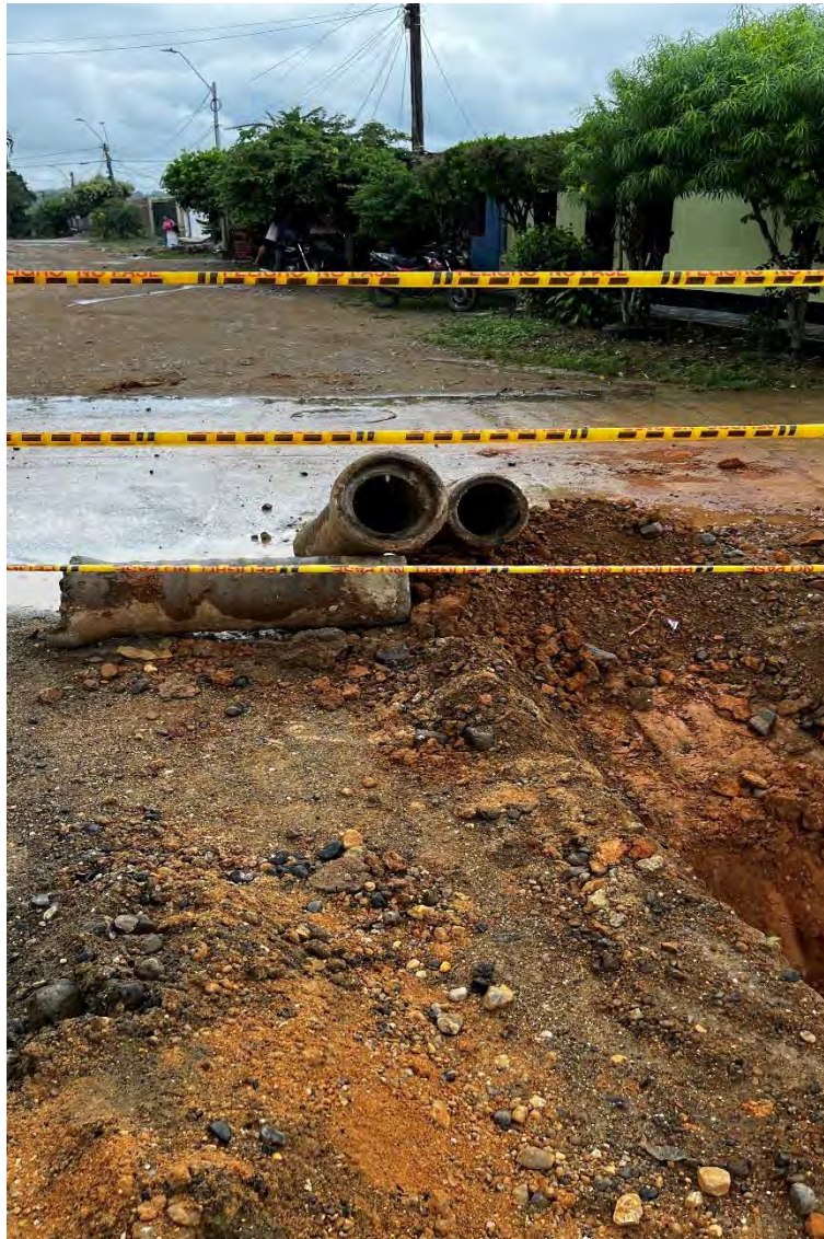
Imagen 3 Demolición de tubería existente
