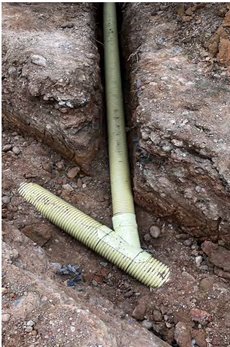
Imagen 32 Suministro e instalación tubería 6" pvc corrugada
