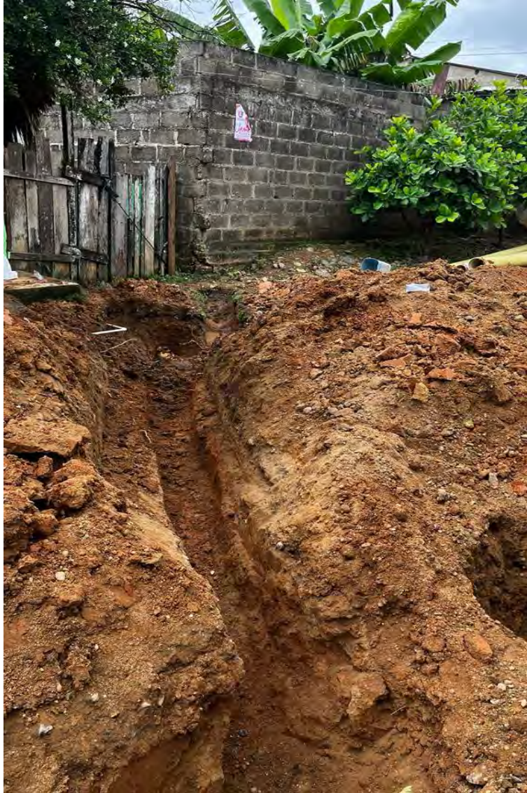
Imagen 3 Excavación manual de domiciliaria
