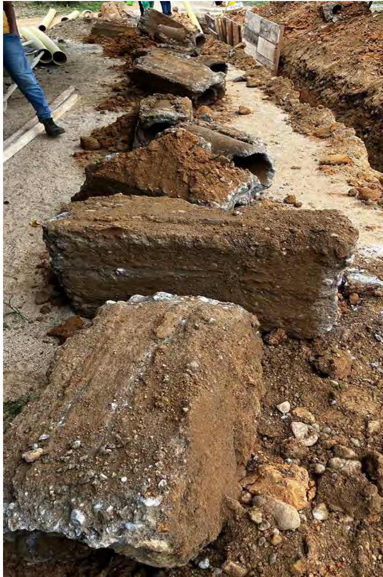
Imagen 1 Demolición y retiro de tubería existente asbesto cemento con atraque en concreto
