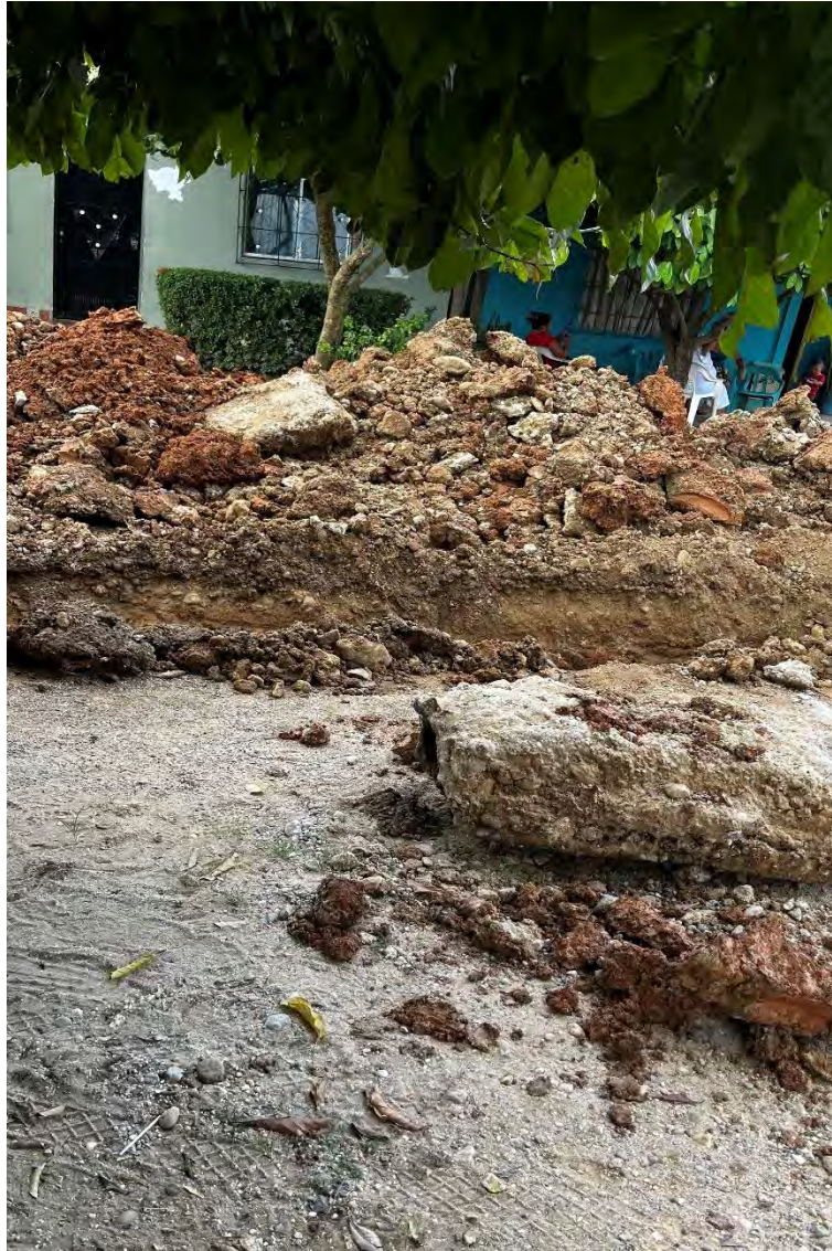
Imagen 1 Demolición de tubería existente
