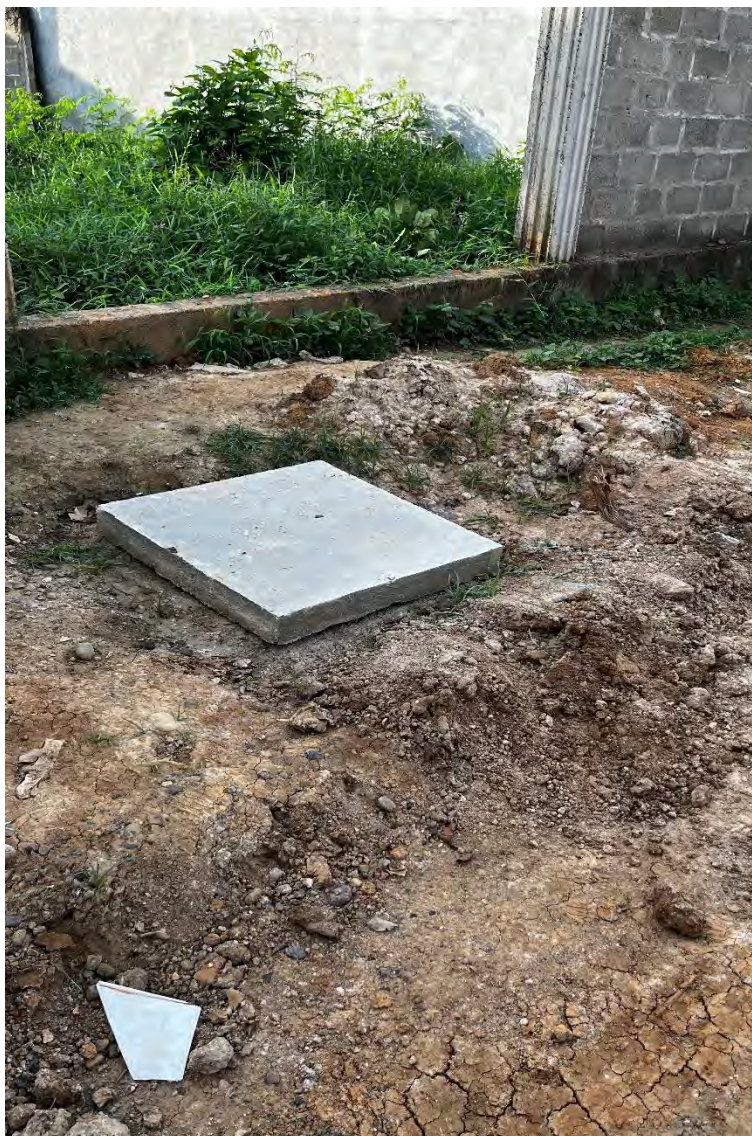
Imagen 30 Construcción de registro en concreto
