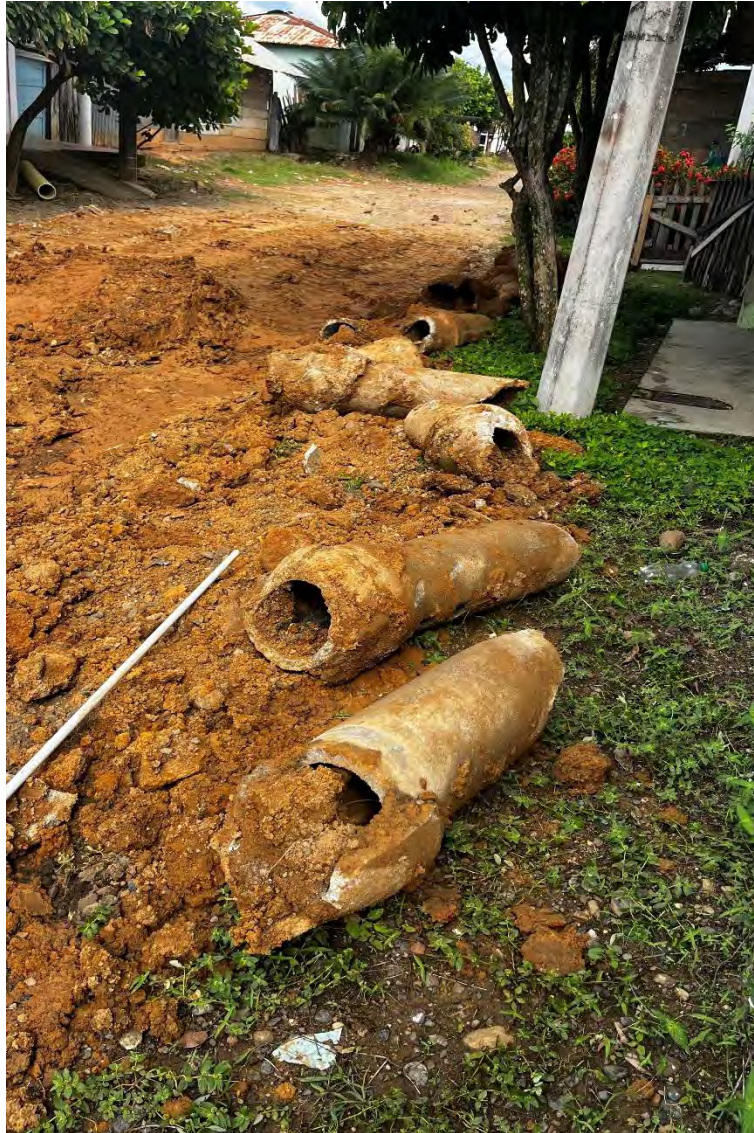
Imagen 2 Demolición de tubería existente
