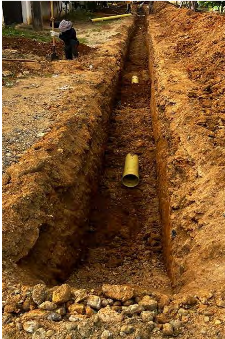
Imagen 9 Relleno con material de sitio
