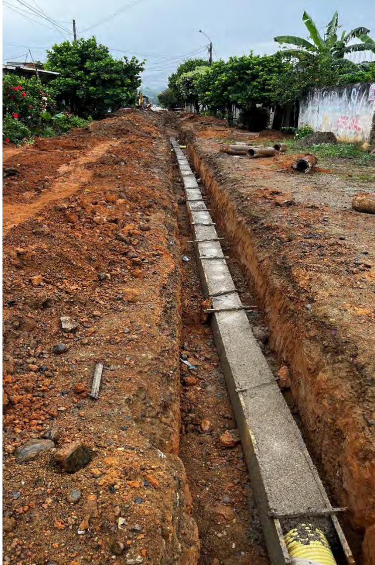
Imagen 35 Atrache en concreto para tubería
