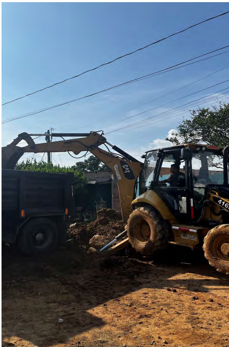
Imagen 6 Retiro de escombros
