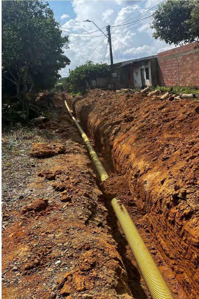
Imagen 24 Suministro e instalación tubería 8" pvc corrugada
