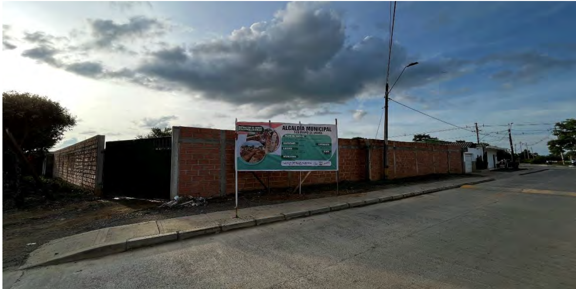
Imagen 3 valla informativa instalada
