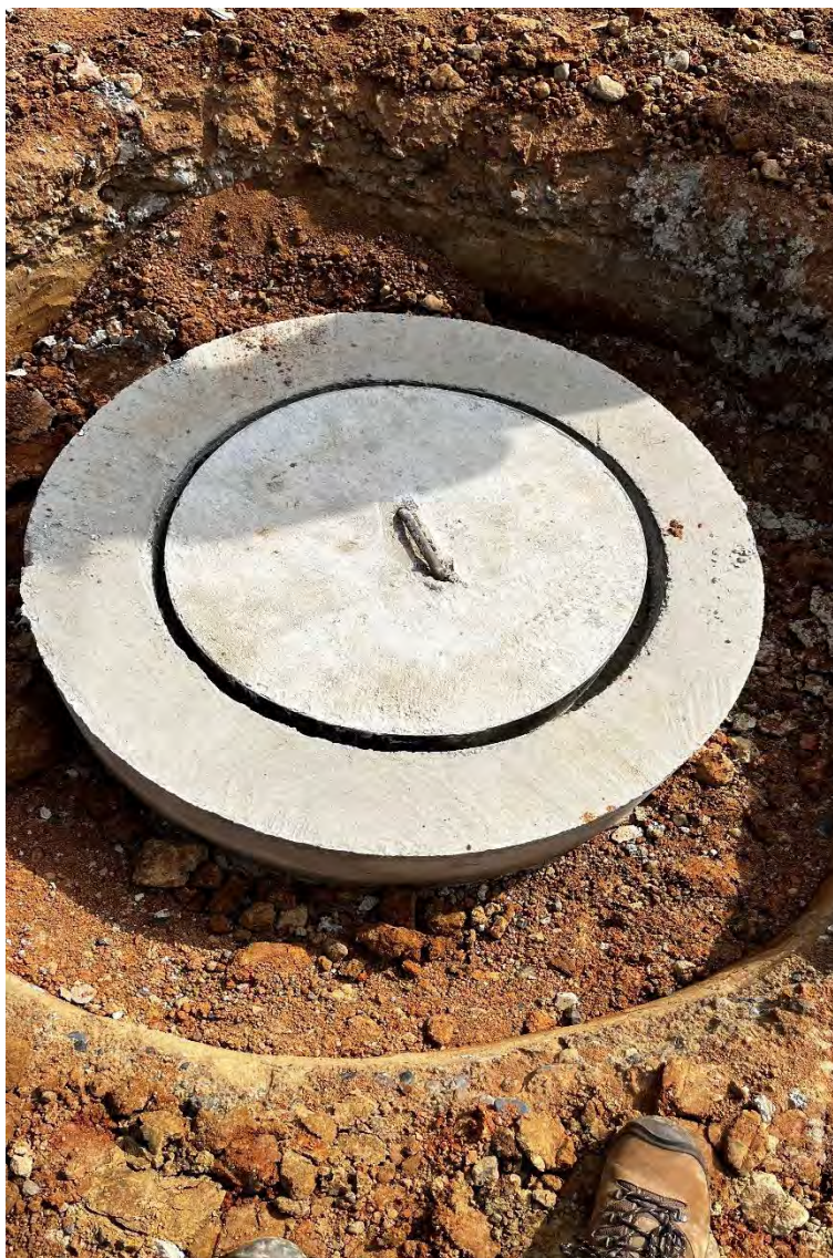
Imagen 34 Construcción de pozos de inspección
