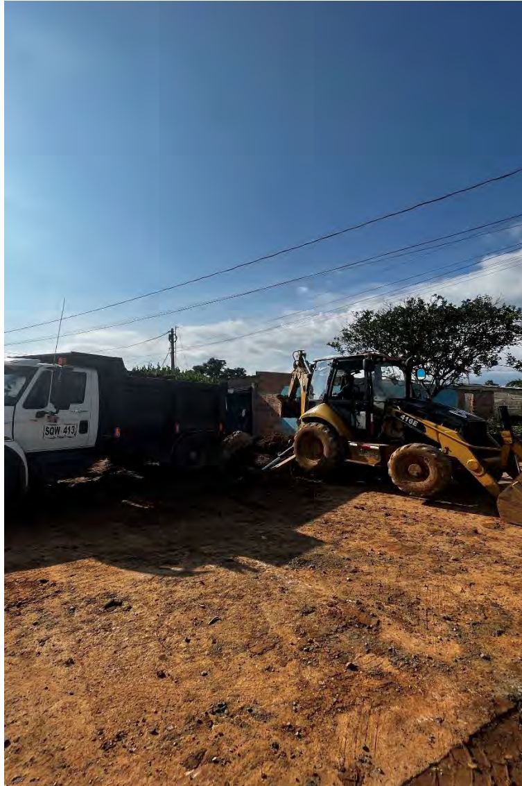
Imagen 5 Retiro de escombros
