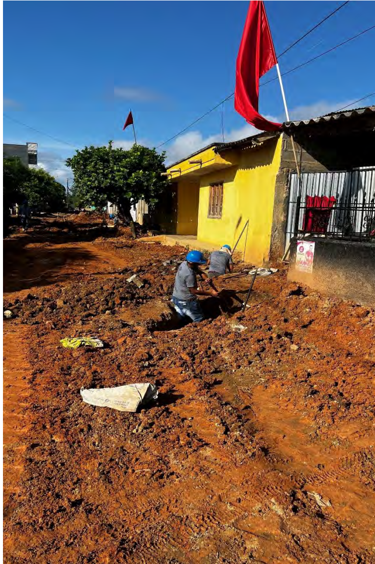
Imagen 8 Excavación a mano material común
