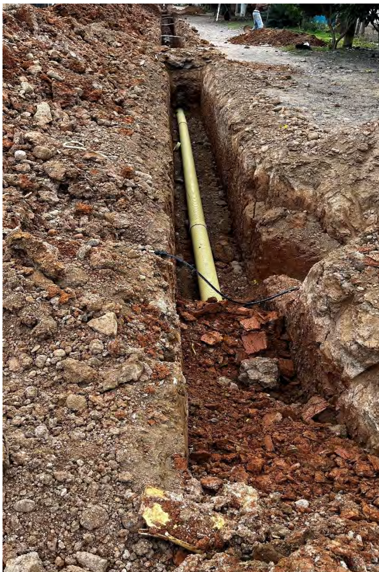
Imagen 26 Suministro e instalación tubería 8" pvc corrugada
