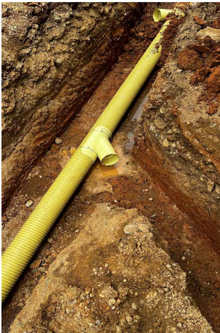
Imagen 28 Suministro e instalación silla yee
