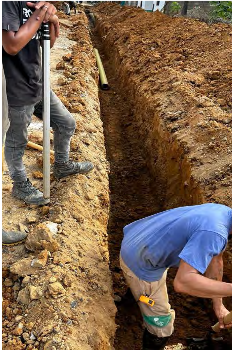
Imagen 4 Excavación manual
