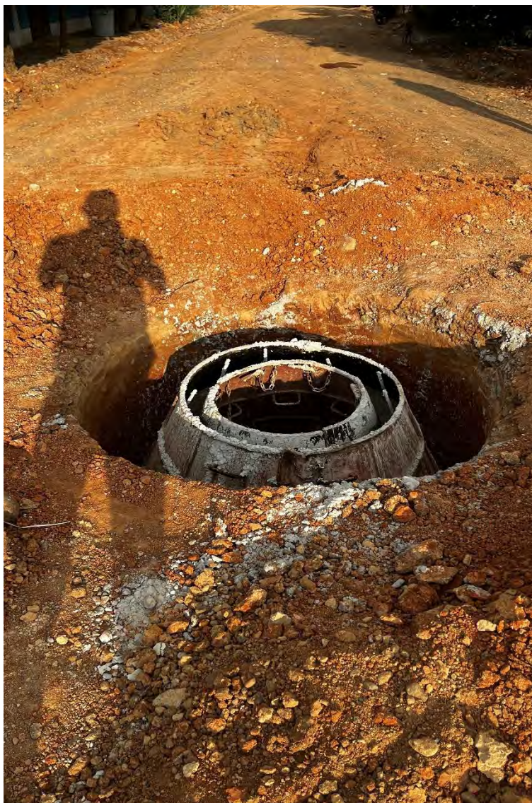
Imagen 33 Construcción de pozos de inspección
