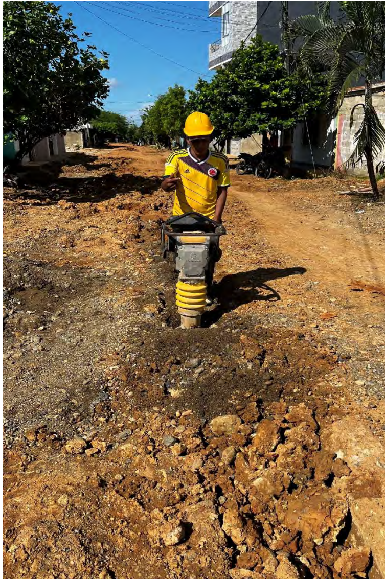
Imagen 18 Rellenos compactados
