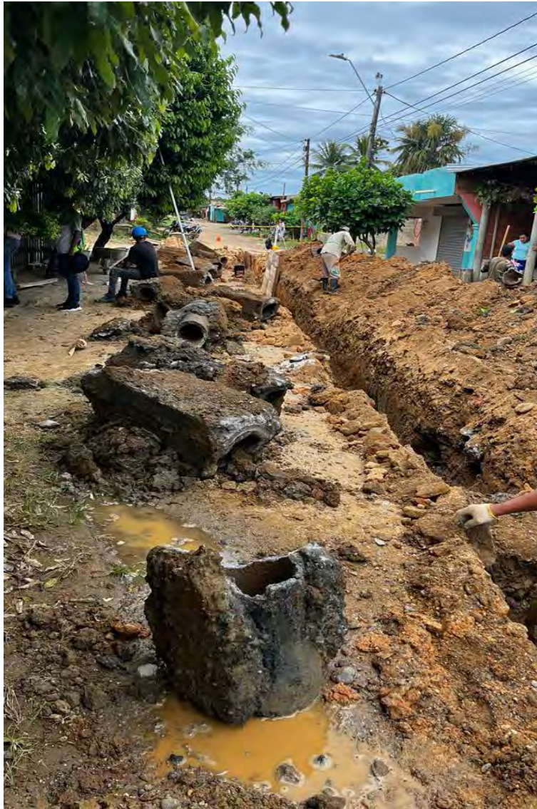
Imagen 2 Demolición y retiro de tubería existente asbesto cemento con atraque en concreto
