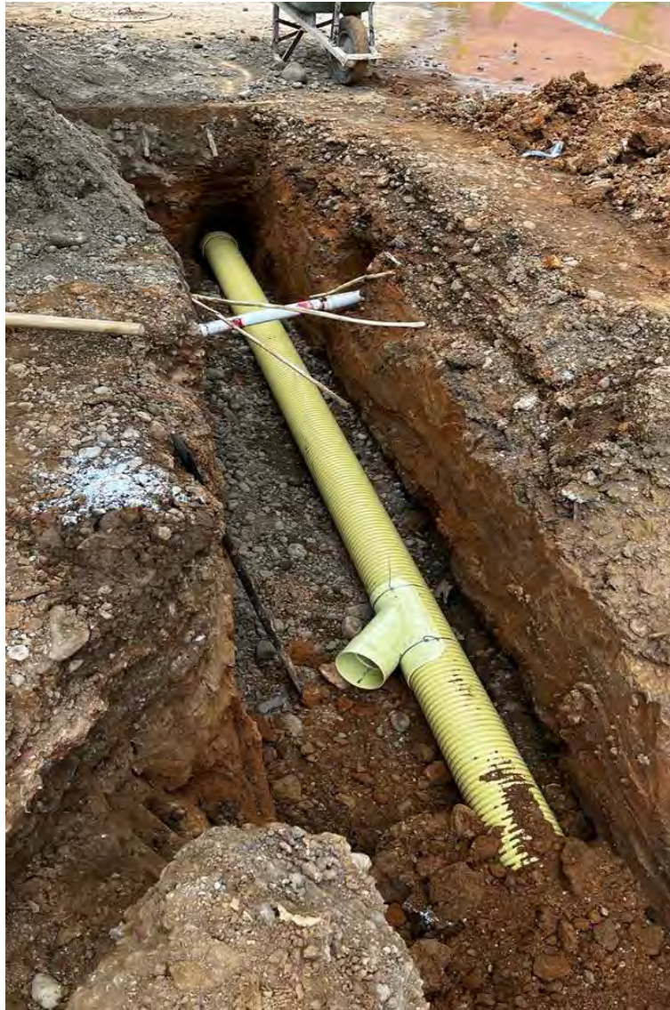
Imagen 14 Instalación de tubería y silla yee
