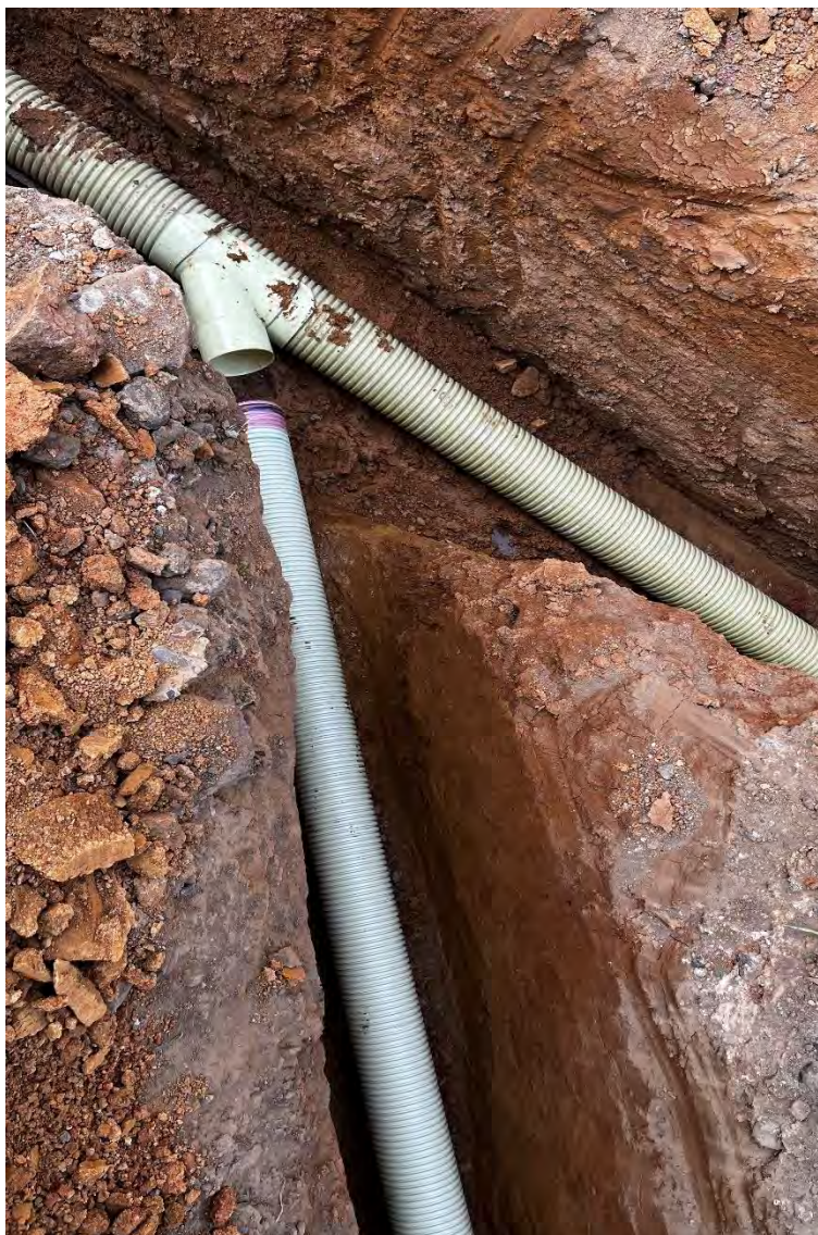
Imagen 31 Suministro e instalación tubería 6" pvc corrugada
