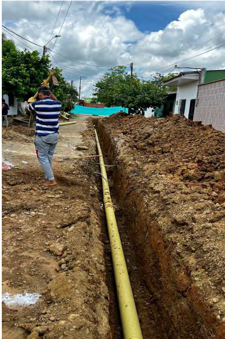
Imagen 13 Instalación de tubería
