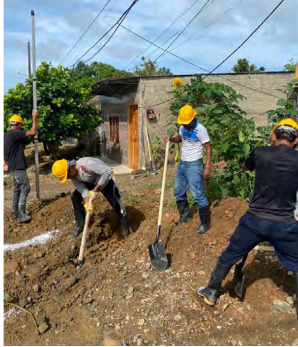
Imagen 6 Utilización de Elementos de Protección Personal
