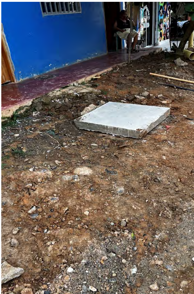
Imagen 29 Construcción de registro en concreto
