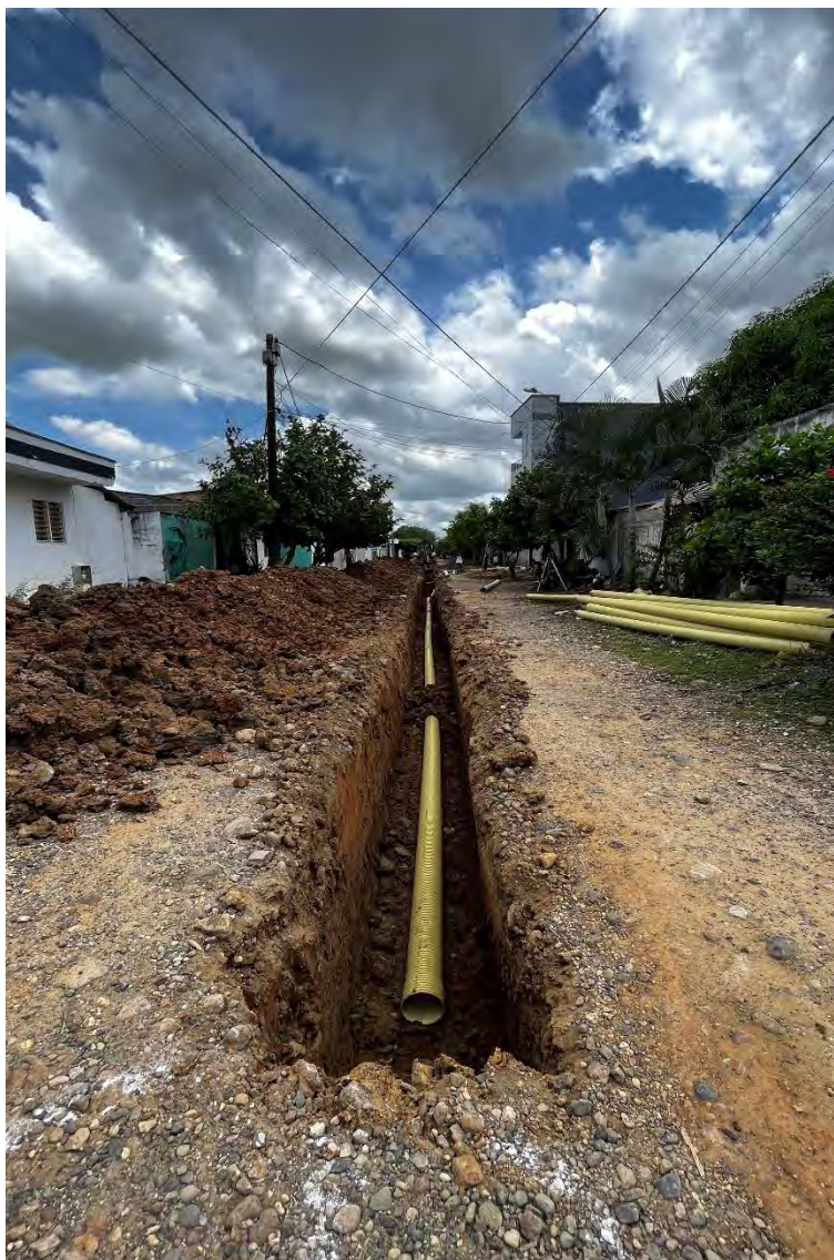
Imagen 25 Suministro e instalación tubería 8" pvc corrugada
