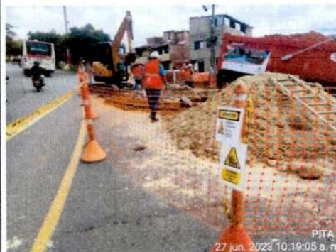
Demarcacion y señalizacion de las areas a intervenir CONSORCIO PITA 7
