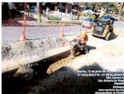
Uso adecuado de EPP en la actividad de compactación de material CONSORCIO PITA 7
