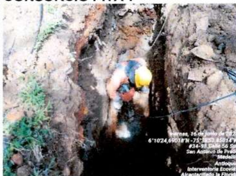
Uso adecuado de EPP en la actividad de perforación de roca CONSORCIO PITA 7
