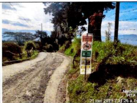
Señalización informativa de los trabajos en la vía CONSORCIO PITA 7
