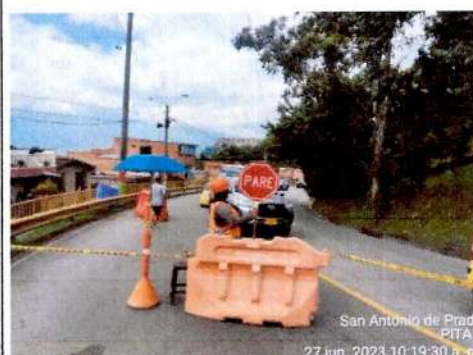
Señalización PMT para evitar accidentes de transito CONSORCIO PITA 7
