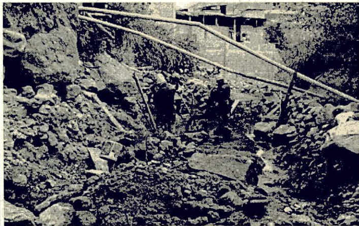
Foto 6: Excavaciones en material común y conglomerado.
