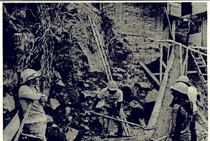
Foto 7: Vaciado de Concreto a través de canaleta.
