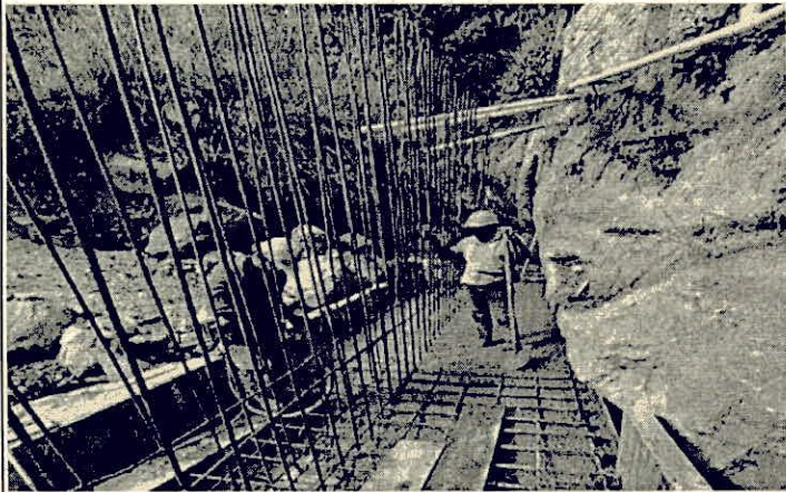
Foto 4: Proceso de Vibrado del Concreto.
