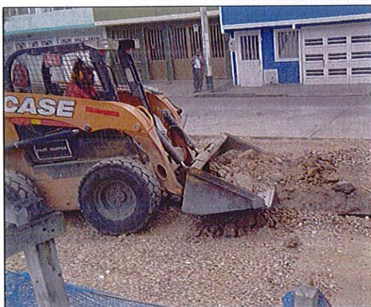
RETIRO DE ESCOMBROS
