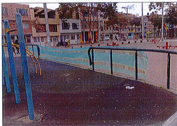
Implementación del cerramiento
