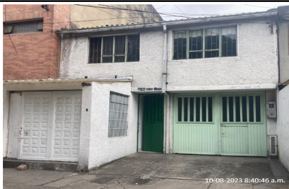
FOTO 4. REGISTRO FOTOGRÁFICO PUNTO DE ATENCIÓN AL CIUDADANO
