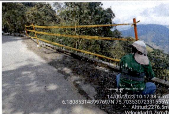
Foto 12. Mantenimiento señalización puntos críticos
