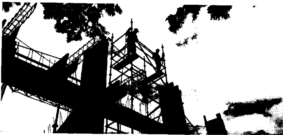
Inspección del cumplimiento del trabajo seguro en alturas en la ejecución de las actividades del proyecto
