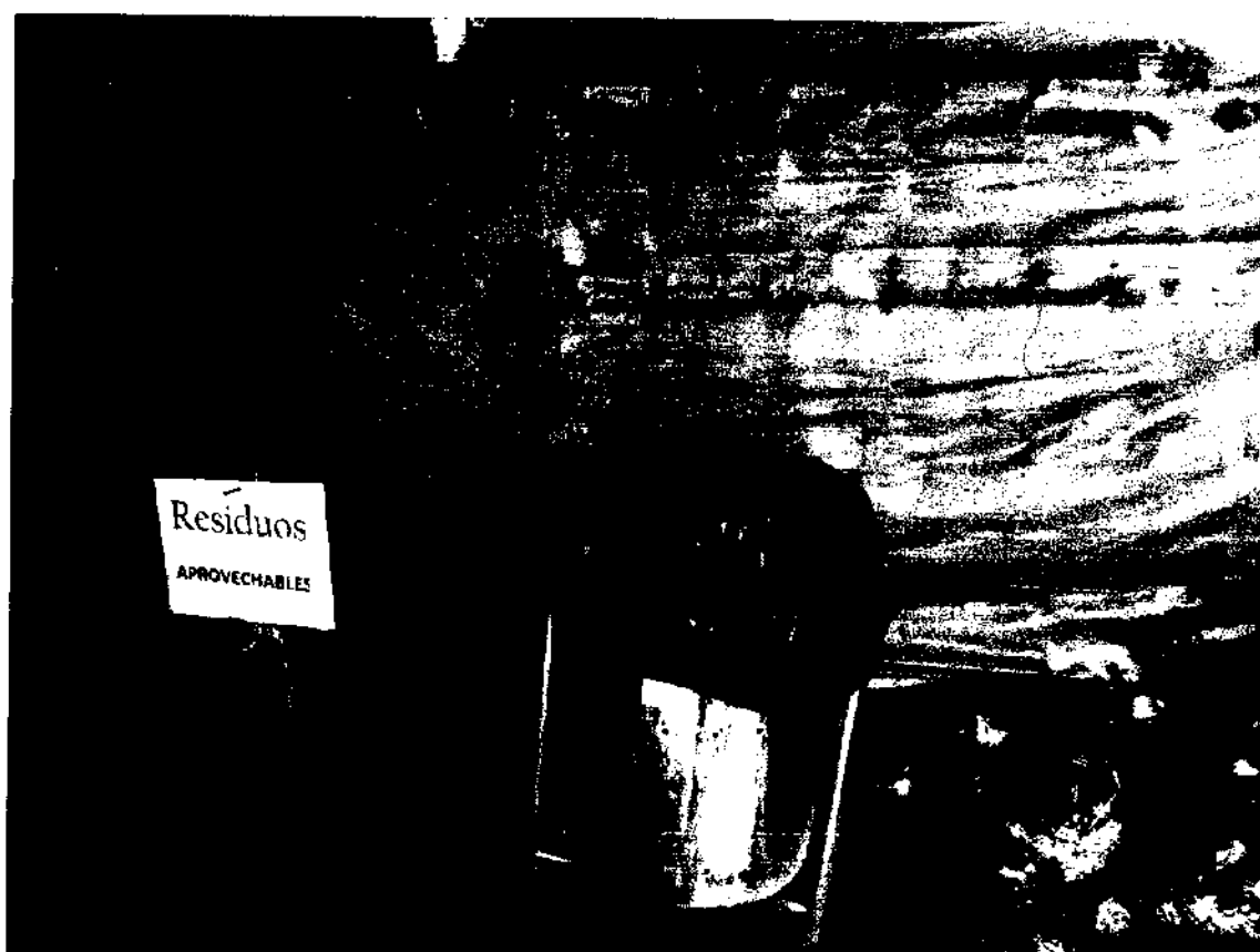
Inspección de Señalización en Puntos ecológicos en senderos de la obra
