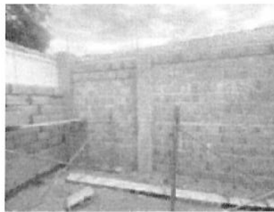
Levante muro estructural
