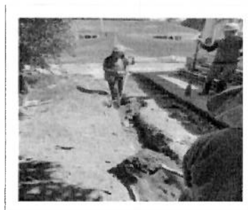
Excavación vigas externas
