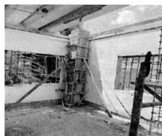
Fundida de columnas
