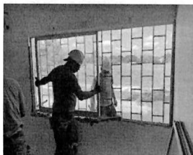
Desmante de Ventanas
