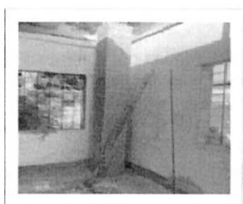
Desencofre de columnas
