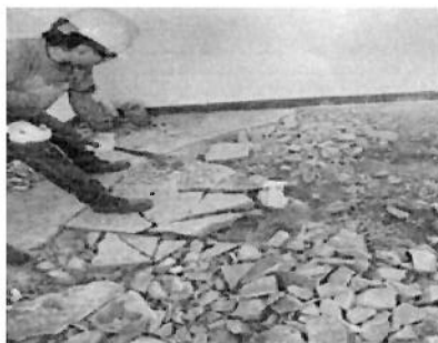
Demolición de piso
