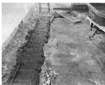
Fundida viga de cimentación
