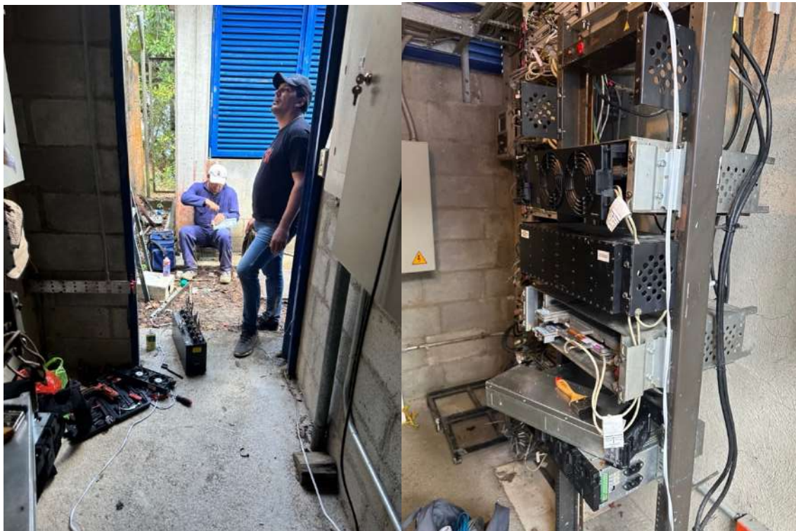
Mantenimiento módulos que conforman repetidores y rectificadores
