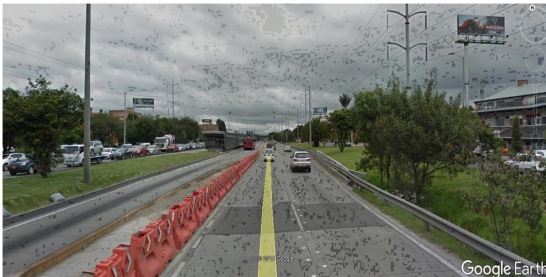
Vista Zona a Intervenir Calzada Rápida Autopista Norte Sentido Sur-Norte – Entrada Estación Calle 146. Fuente Google Earth.
