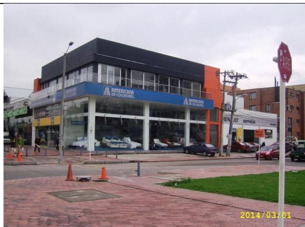
Imagen No.41 – Registro fotográfico andén costado Oriental
