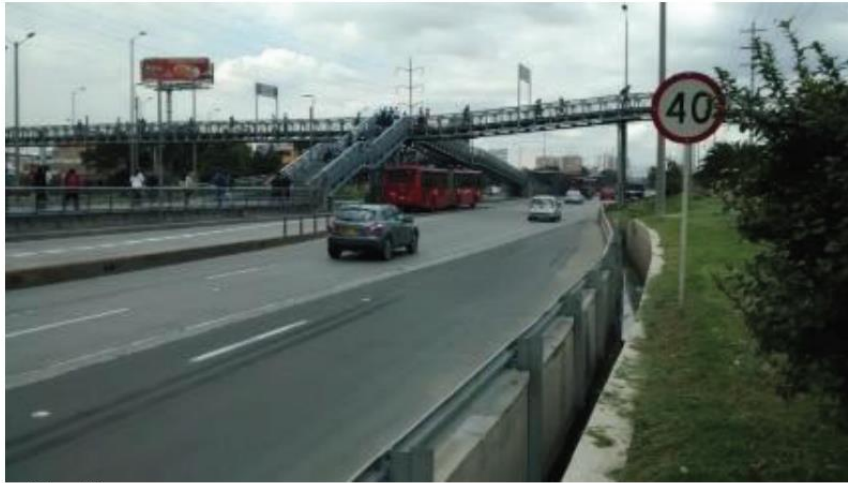
Figura 86 Transición de salida ampliación Toberín
