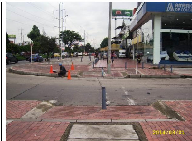
Imagen No.40 – Registro fotográfico andén costado Oriental
