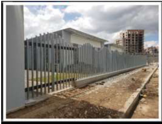
Instalación correas metálicas y culminación cerramiento principal.
