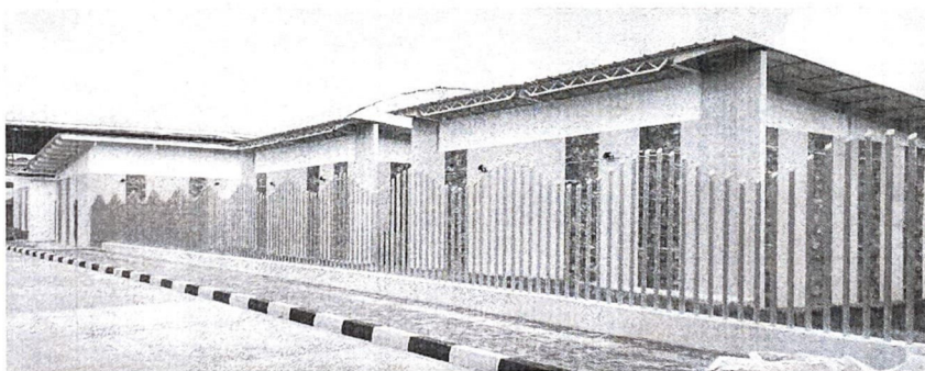
Instalación correas metálicas y culminación cerramiento principal.
