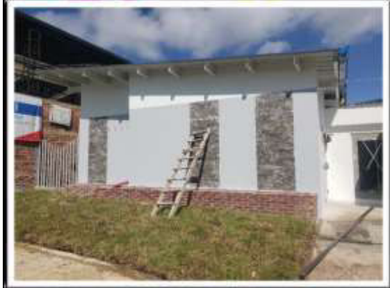
Instalación empedrado en césped natural en fachada principal
